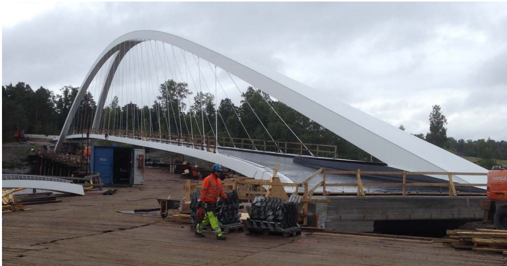
Kuva 3. Isoisänsilta rakennusvaiheessa Kalasataman päästä kuvattuna
