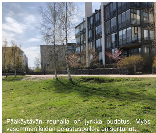
Yksi pahiten sortuneista pelastuspaikoista. Paikan tulisi sijaita kokonaisuudessaan salpaseinämällä.
