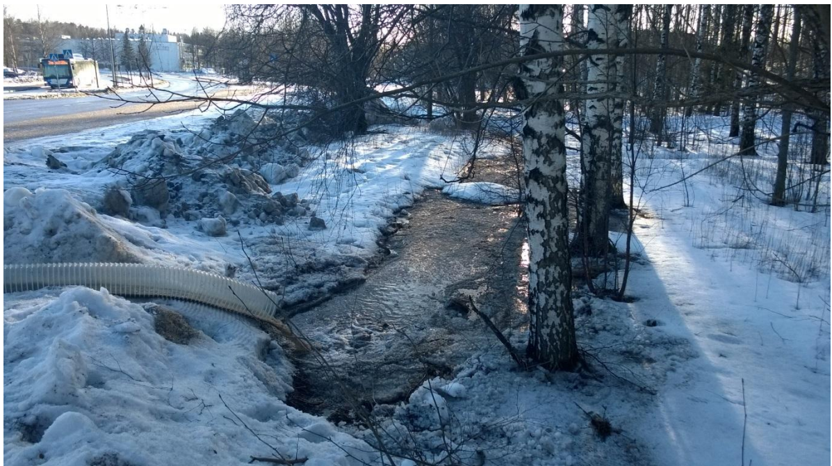
Kuva 12. Riukutienkohteen purkuputki Konalantien viereiseen avo-ojaan
