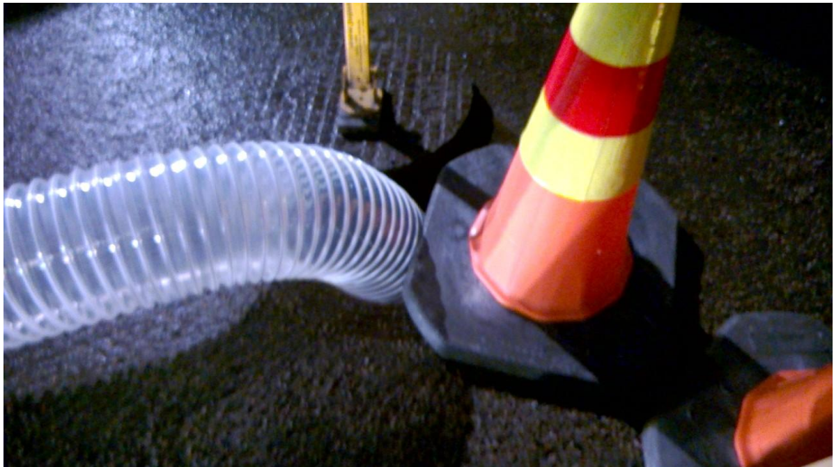
Kuva 9. Sulamisveden purku runkoviemäriin Olympiastadionin pysäköintialueella.
