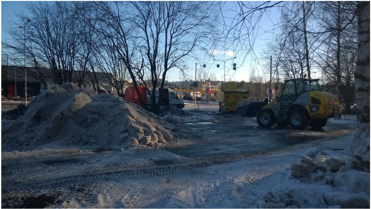
Kuva 7. Sulatustyömaa edellyttää valvontaa ja rajausta.
