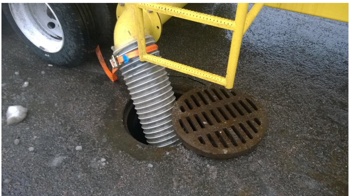
Kuva 10. Sulamisveden purku kokeiluna suoraan viemäriin.
