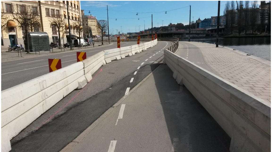
Kuva 7 Raskaalla betoniaidalla eroteltu pyörätie Tukholmassa
