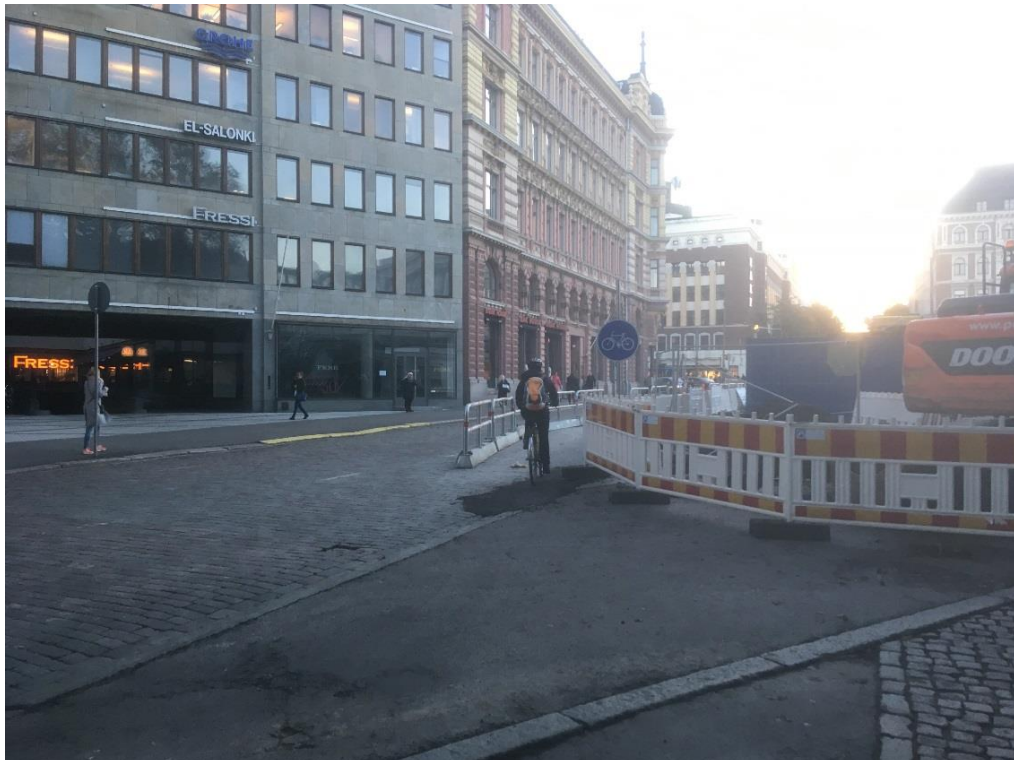
Kuva 4 Kaksisuuntainen pyörätie ohittaa työmaan Erottajanaukion kohdalla, jossa tila on otettu ajoradalta.
