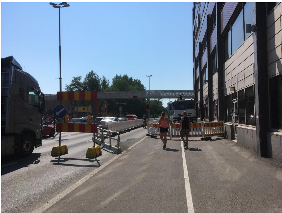
Kuva 3 Työmaanaikainen järjestely Sörnäisten rantatiellä. Tila pyöräliikenteelle on osoitettu ajoradalta.
