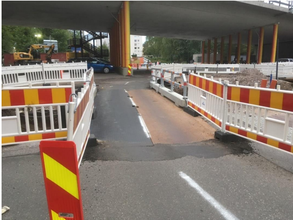
Kuva 60 Kaivannon yli voidaan järjestää tilapäinen silta, kuten Baanalla. Sillalla tulee huomioida, ettei kapea rengas pysty tipahtamaan sillan saumakohtiin.
