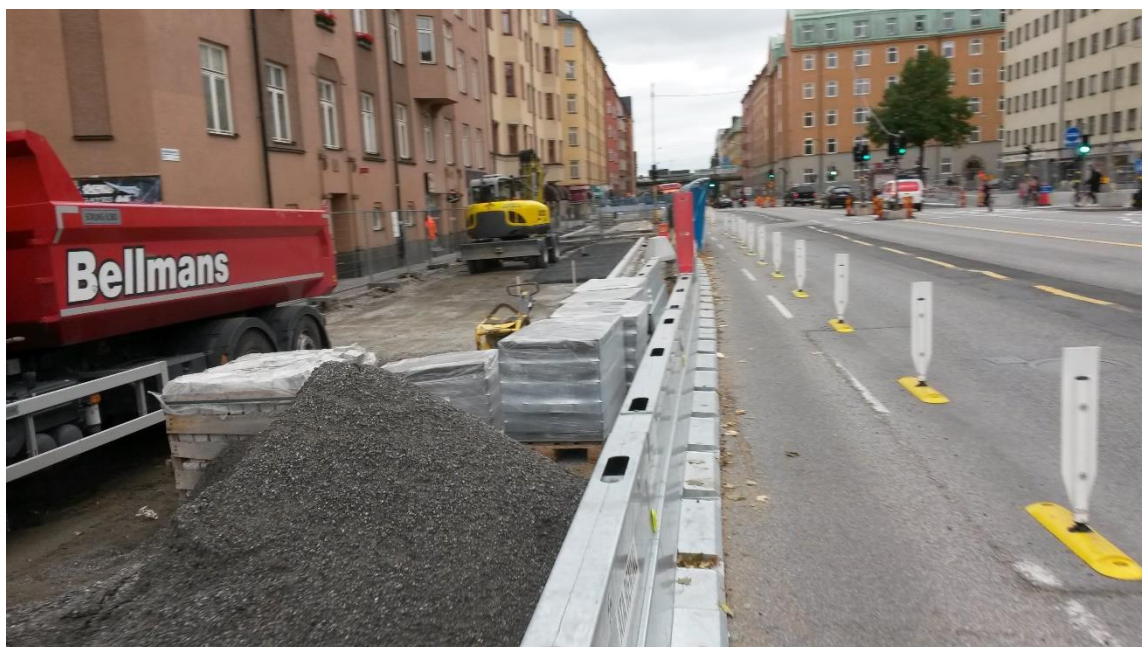
Kuva 6 Työmaa Tukholmassa, jossa on selkeästi rajattu työmaa-alue ja työnaikainen pyöräkaista.
