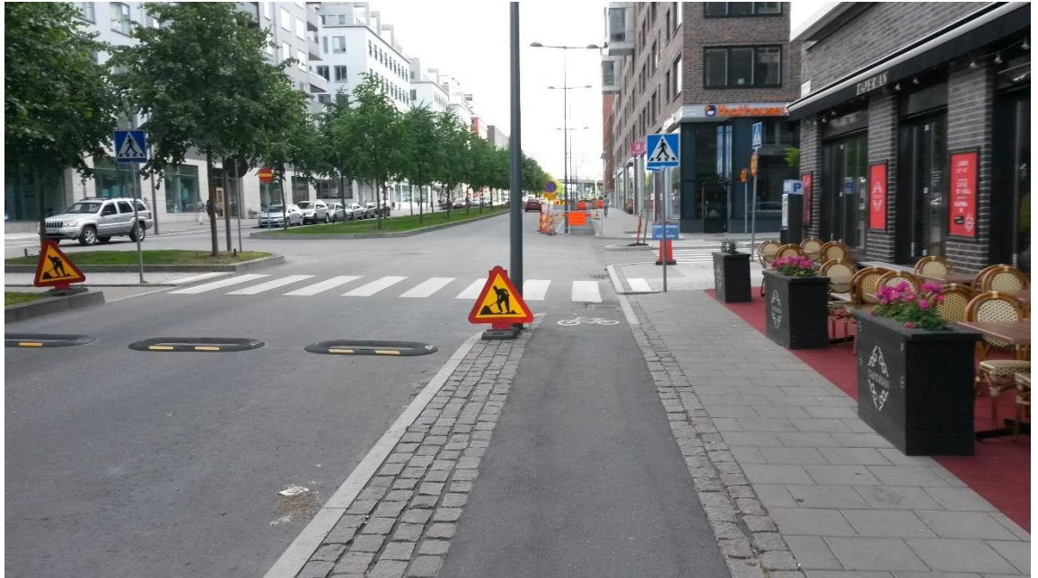
Kuva 9 Pyöräliikenne ohjataan ennen työmaa-aluetta ajoradalle 1-suuntaiselta pyörätieltä Tukholmassa. Autoliikenteen nopeuksia hidastetaan liityntäkohdassa.
