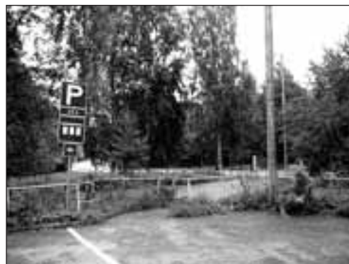
Peukaloisientien pään pysäköintialueen laita on huonossa kunnossa
