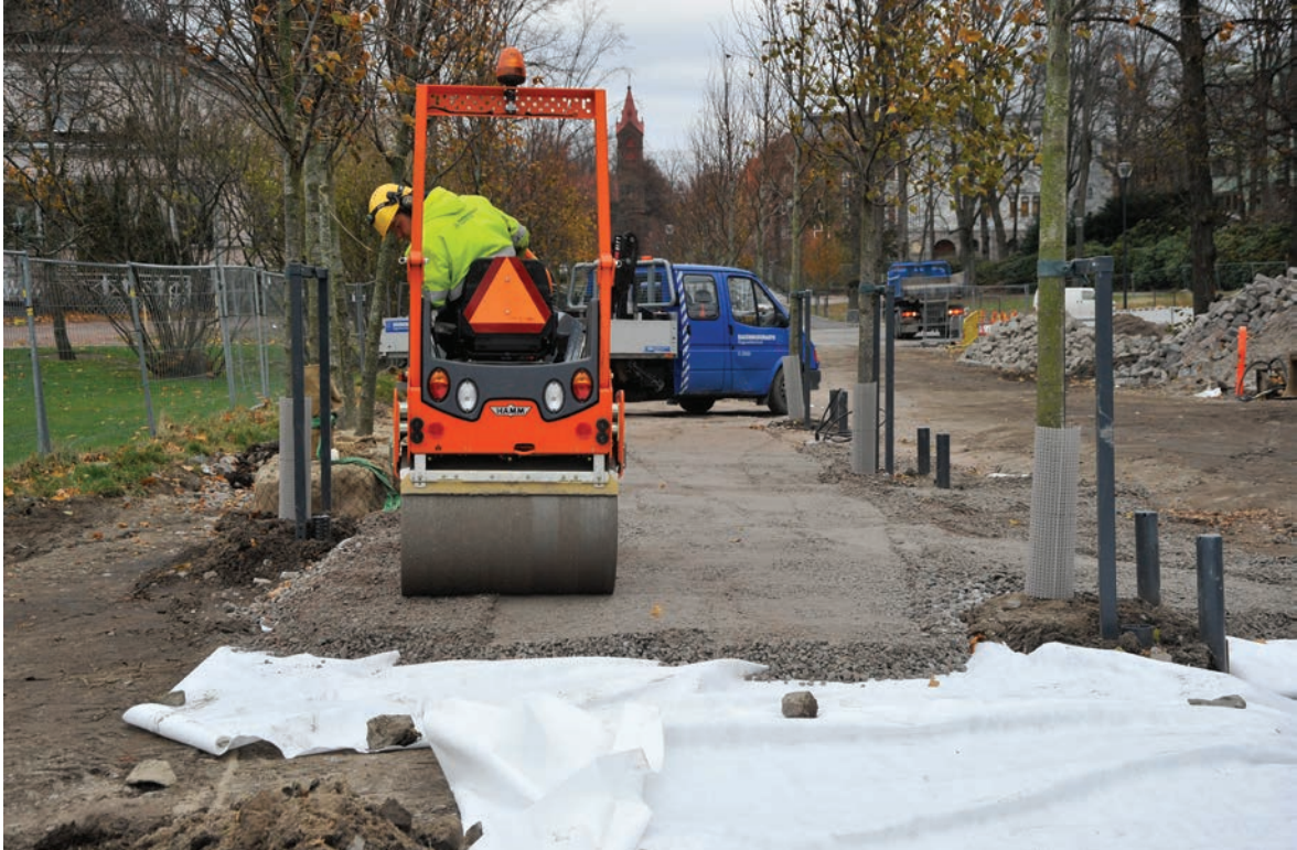
Alinna: Päälystetöitä uusien lehmusten rajaamalla kujanteella. VP.
