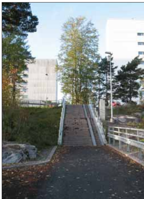
Esimerkillisessä kunnossa olevat portaat Meripihkapolulla.
