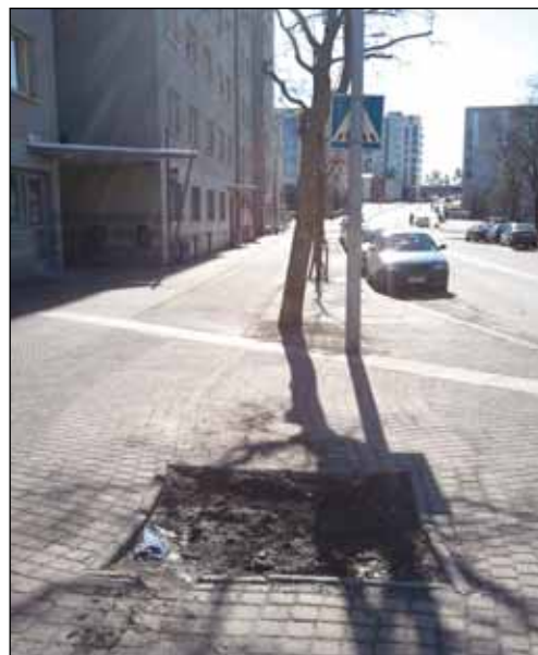
Salpausseläntien kevyen liikenteen väylällä oleva istutuskuoppa täytetään ja kivetään.
