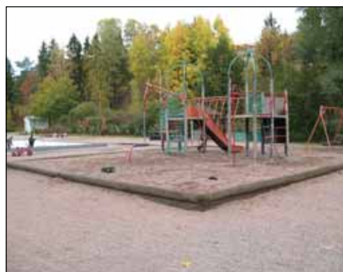
Leikkipuisto Salpausselkä kaipa kiireellisesti peruskorjausta.
