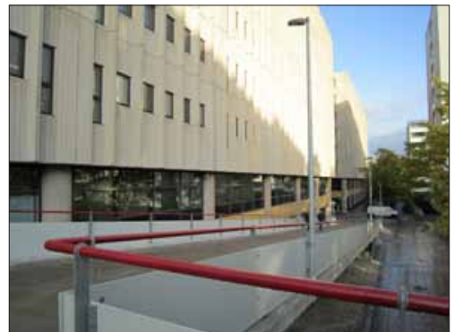
Resiinakujan kaiteissa on käytetty punaista tehosteväriä; Opastinsillan tehosteväri on keltainen (kuva yllä).
