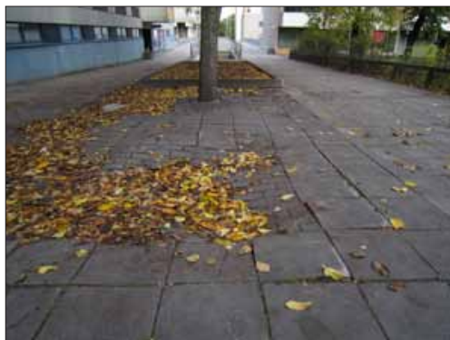
Painuneet kiveykset hankaloittavat puhtaanapitotöitä erityisesti Itä-Pasilassa.
