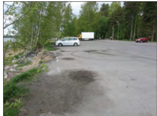
Uimarannan pysäköintialue on jäsen- tymätön ja huonokuntoinen.
