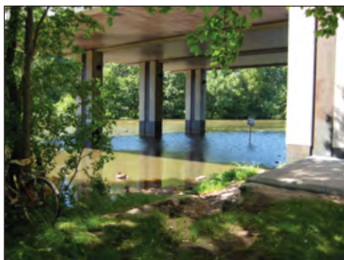
Munkinpuiston lammikot ovat osittain umpeenkasvaneet ja matalat.
