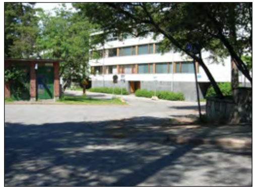
Tuulaspolun ja Tiilimäen risteyksessä puuttuvat reunakivilinjat vaikeuttavat ajolinjojen hahmottamista
