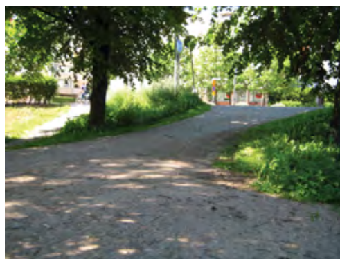
Kivitorpanpuistosta Laajalahdentielle nouseva puistokäytävä ei täytä esteettömyyden perustason vaatimuksia.
