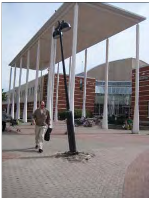
Ala-Malmintorilla päällysteet ja kalusteet ovat kärsineet vaurioita.
