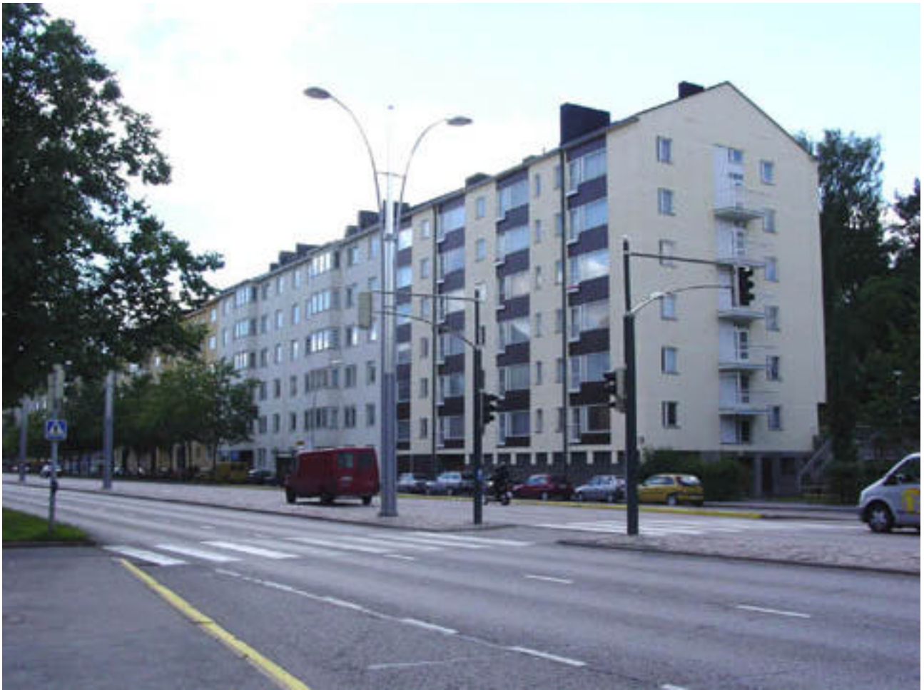
Kuva 2. Huopalahdentie, kohde 2. Rakennukset ovat korkeita ja rajoittuvat jalkakäytävään.
