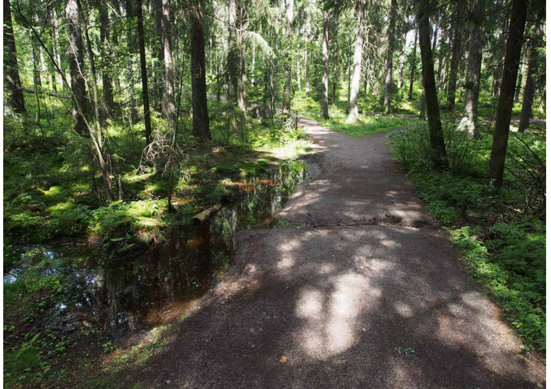
Ongelmakohdissa käytävien kuivatusta parannetaan uudella rumpuputkella.
