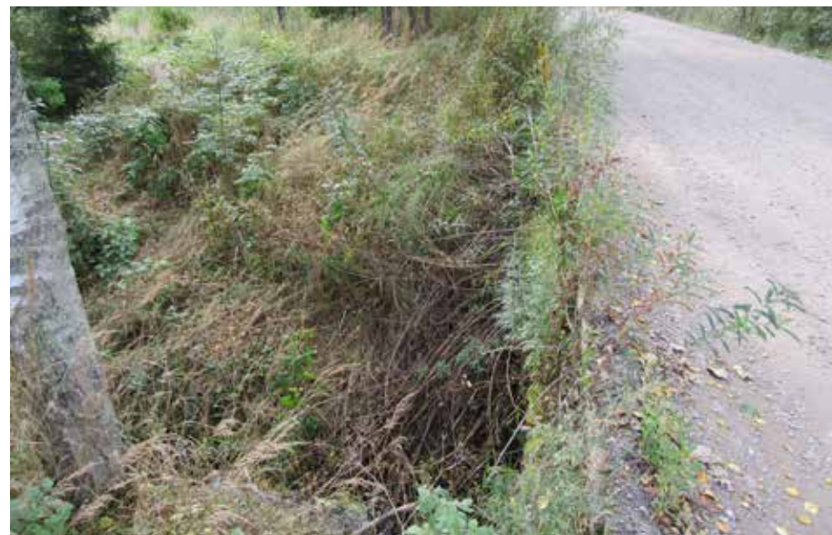
Uutelantien alittavan rummun kohdalla ei ole kaiteita vaikka tieltä ojaan on syvä pudotus.
