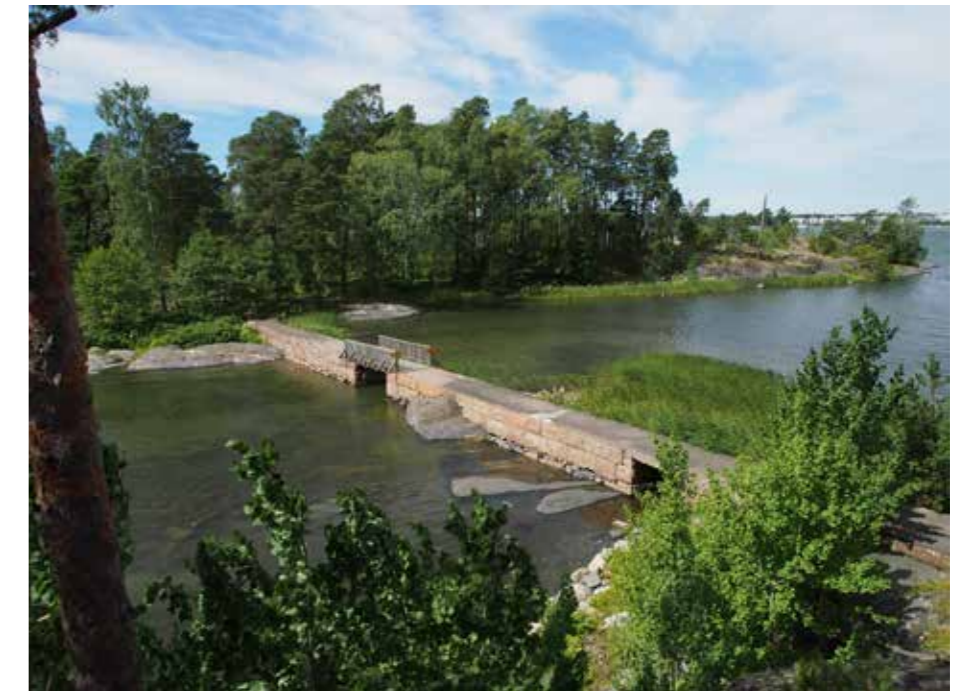
Nuottasaaren johtaa mantereen puolelta graniittinen, kunnostusta vaativa kävelysilta/kannas.
