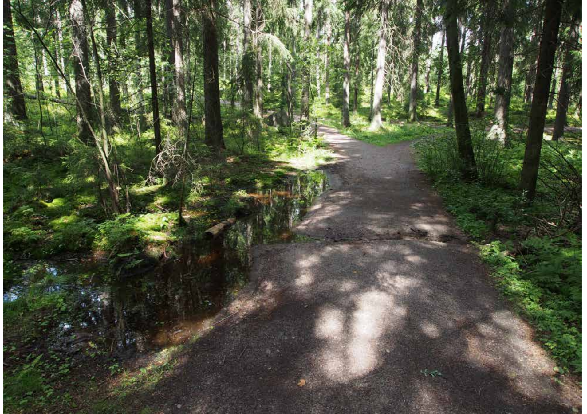
Ongelmakohdissa käytävien kuivatusta parannetaan uudella rumpuputkella.
