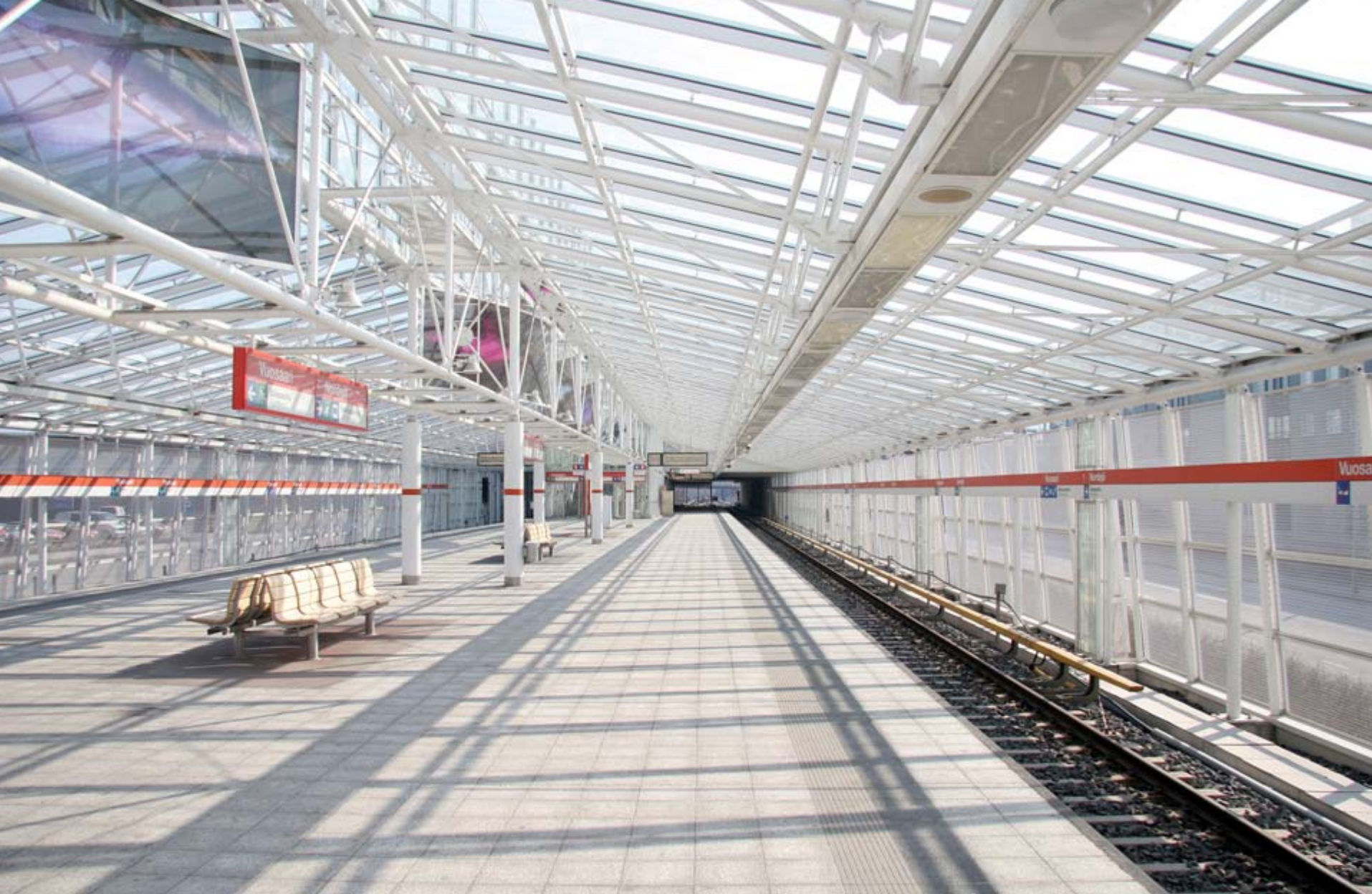
3. Lasiseinät ja -katto aikaansaavat voimakkaan häikäisyn metroasemalla. Voimakkaat heittovarjot aiheuttavat ongelmia näkövammaisille luodessaan vaikutelman tasoerosta. (Vuosaaren metroasema)
