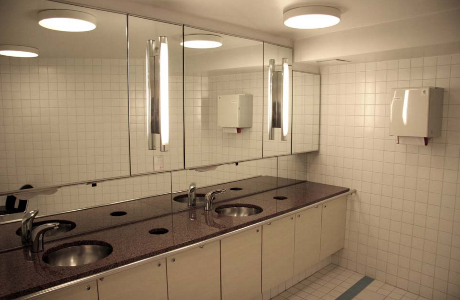
13. Näkövammaisten henkilöiden kannalta on parempi sijoittaa valaisimet peilin sivuille mieluummin kuin yläpuolelle. (Tampere-talo)
