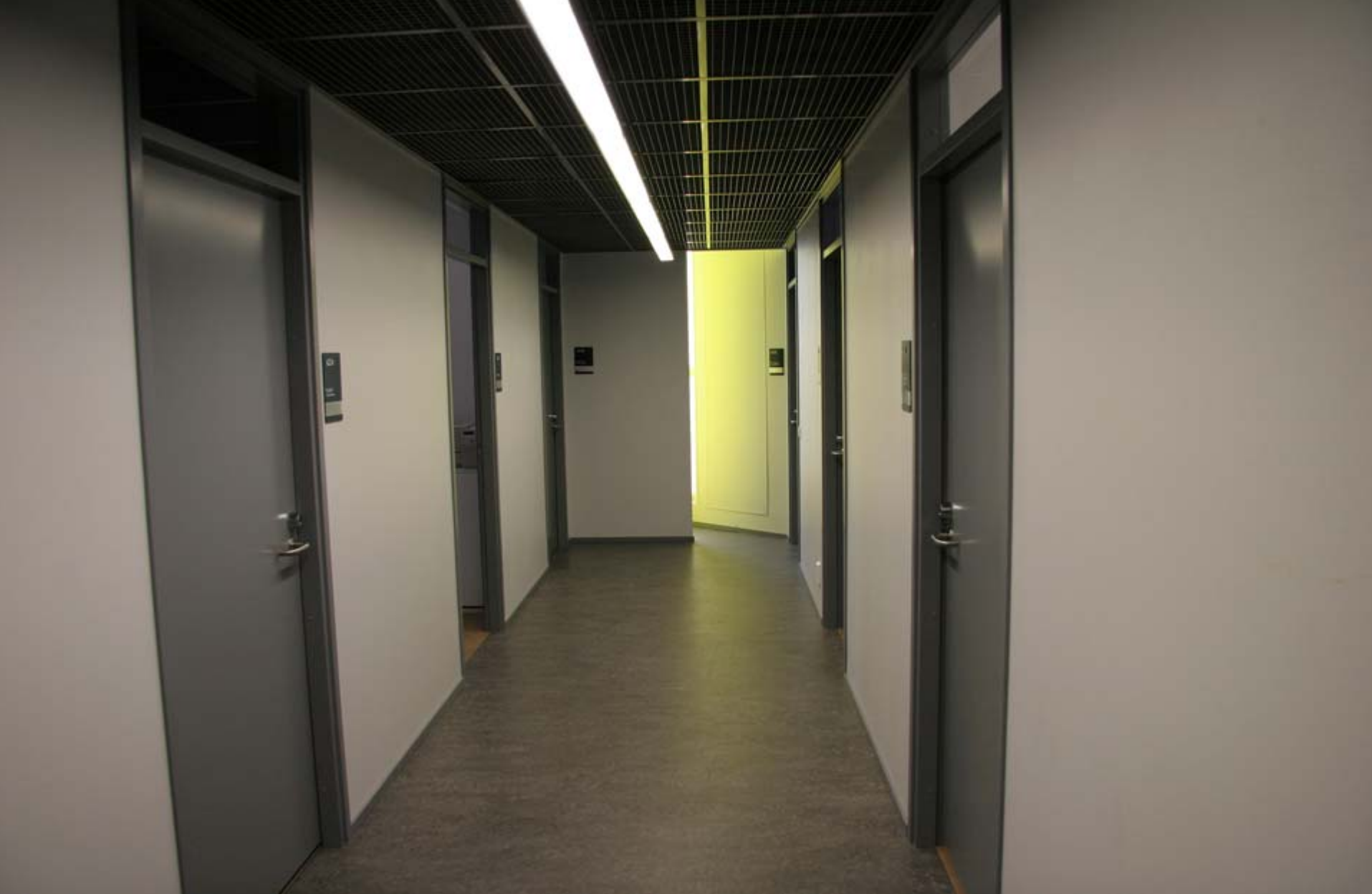
12. Ikkuna käytävän päässä on peitetty kaihtimella vastavalohäikäisyn estämiseksi. (Näkövammaisten palvelu- ja toimintakeskus Iiris)
