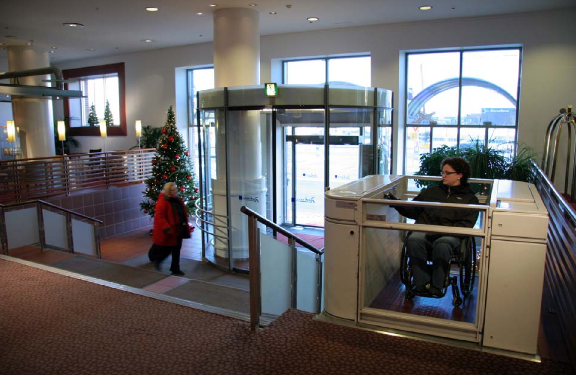
1. Pystyhissin ovet ovat vastakkaisilla seinillä. Kuormatason koko on vähintään 1400 mm x 900 mm. Ovet ovat lyhyillä seinillä. (Radisson SAS Seaside Hotel)
