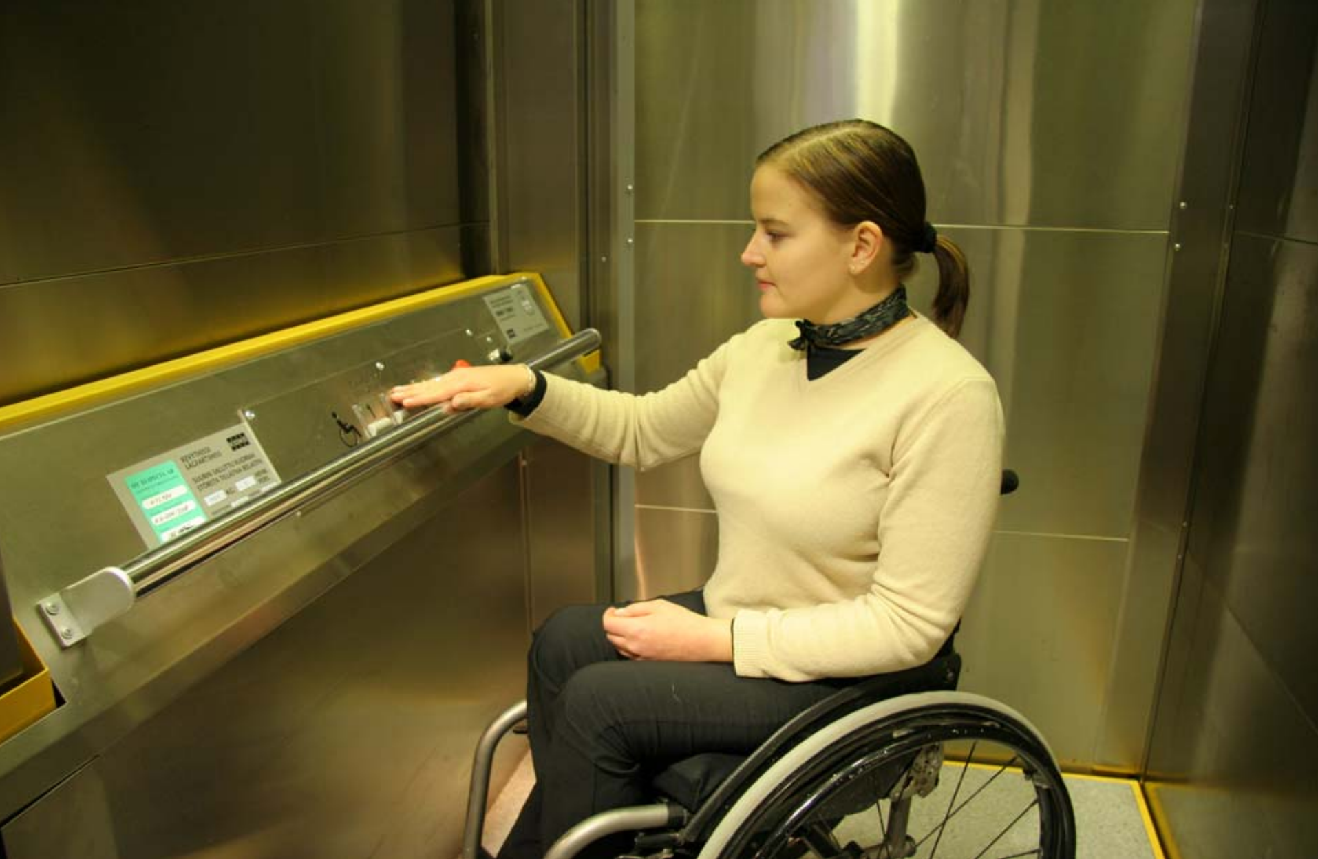
8. Pystyhissin ovet ovat vierekkäisillä seinillä. Kuormatason tulee olla kooltaan 1400 mm x 1400 mm. (Helsingin Kaupunginteatterin pieni näyttämö)
