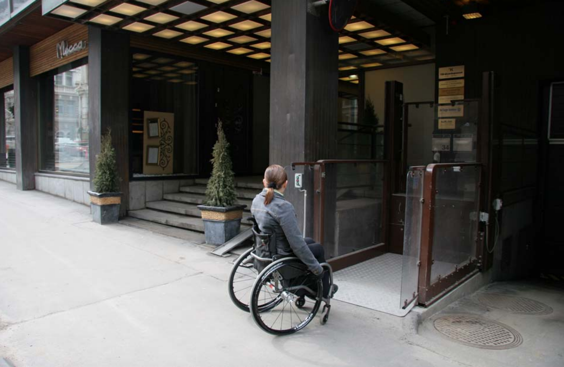
10. Ulkona katoksessa sijaitseva pystyhissi nousee ravintolan sisäänkäynnin tasolle. (Ravintola Mecca)
