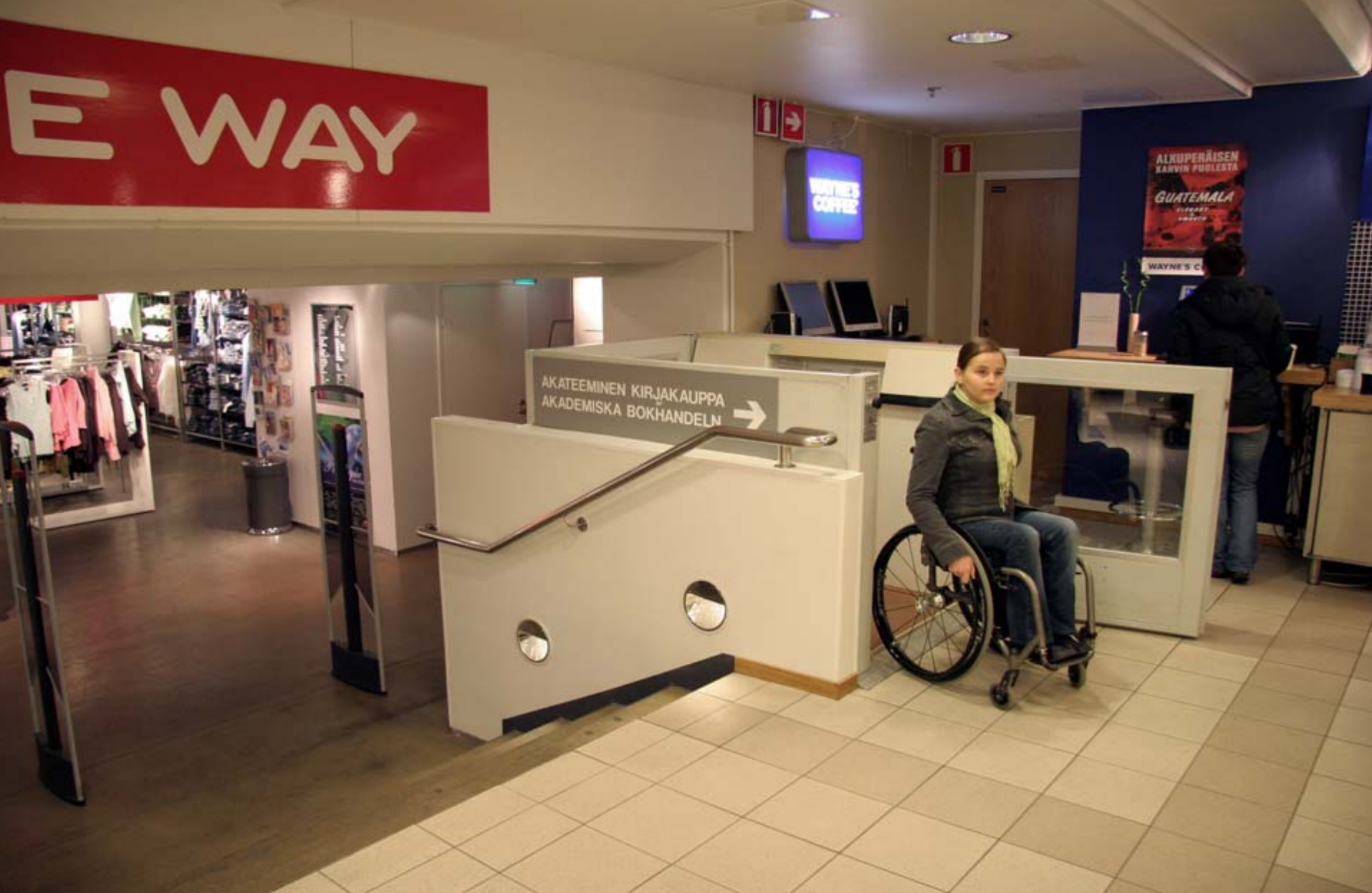
6. Pystyhisä ylätasolla. Yli metrin tasoerossa pyörätuolihisä tai hisä on yleensä suositeltavampi kuin luiska. (Stockmann)
