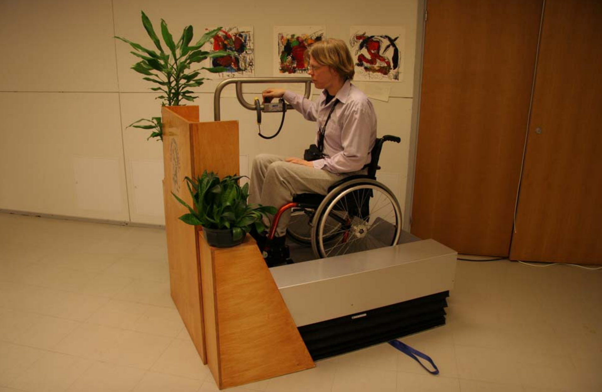
12. Pystyhissillä varustettu puhujanpöytä yläasennossa. Tällaista hissiä voidaan käyttää myös puhujankorokkeen yhteydessä, jos tasoero on enintään 500 mm. (Kynnys ry)
