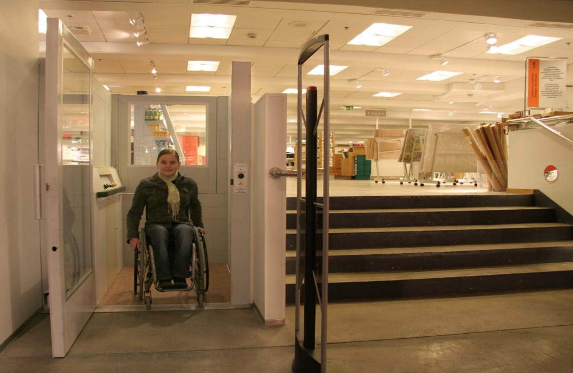
4. Pystyhissi alatasolla. Pyörätuolihiessin kuorman tulee olla vähintään 250 kg, suositeltava kuorma on 300 kg. (Stockmann)
