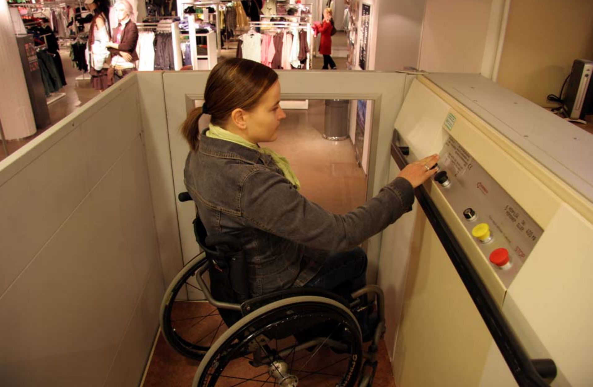
5. Painonapit pystyhissin sisällä. Nappia on painettava jatkuvasti, jotta hissi liikkuu. (Stockmann)
