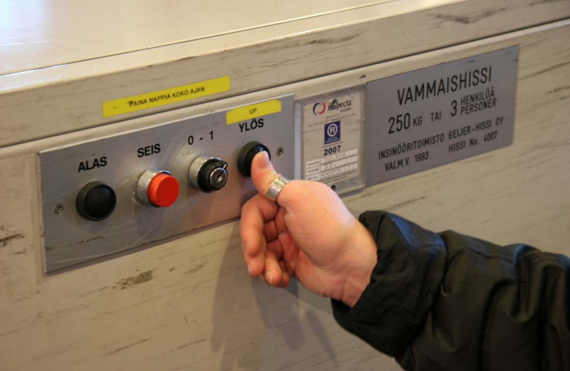
2. Pystyhissinn painonappien sopiva korkeus pyörätuolin käyttäjälle on 800 mm. (Radisson SAS Seaside Hotel)
