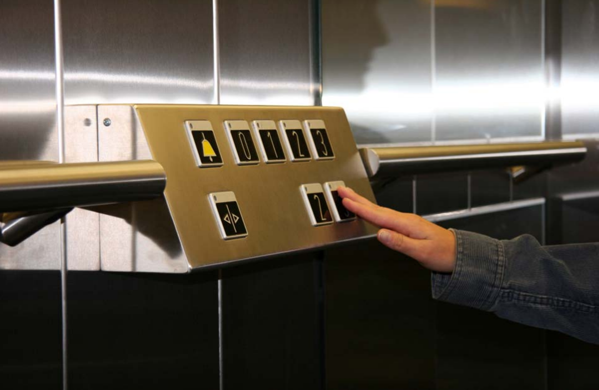
13. Hississä on kahdet kookkaat painonapit hyvin pyörätuolin käyttäjän ulottuvilla. Painonapeissa on kohonumerot ja hyvä kontrasti. (Synapsia)
