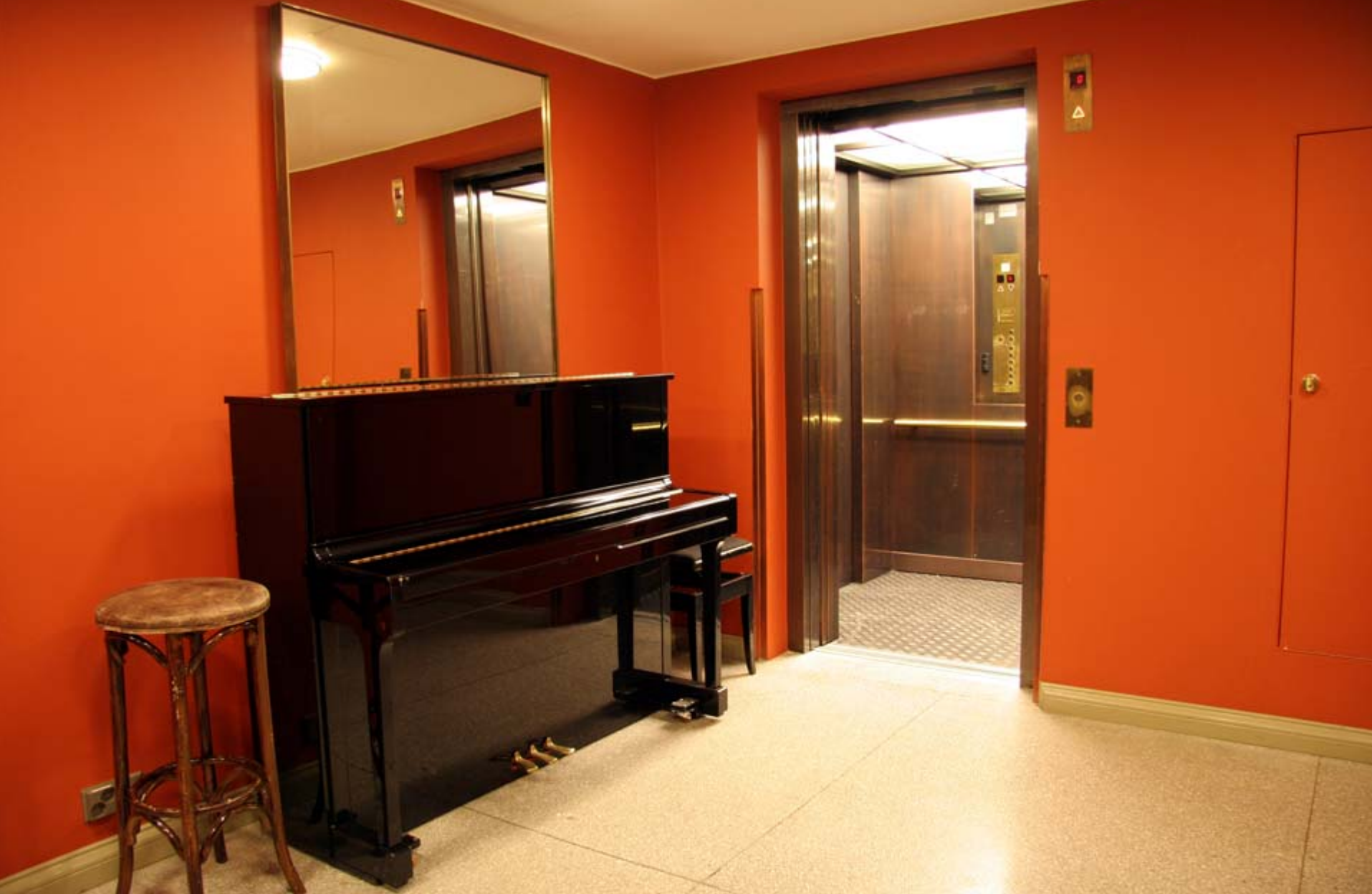
9. Hissikorin ovet ovat tässä vierekkäisillä seinillä jolloin korin koon tulee olla 1400 mm x 1400 mm. Rakennuksen ulkoseinää on ohennettu jotta on saatu tilaa riittävän tilavalle hissille. (Suomen Kansallisteatteri)
