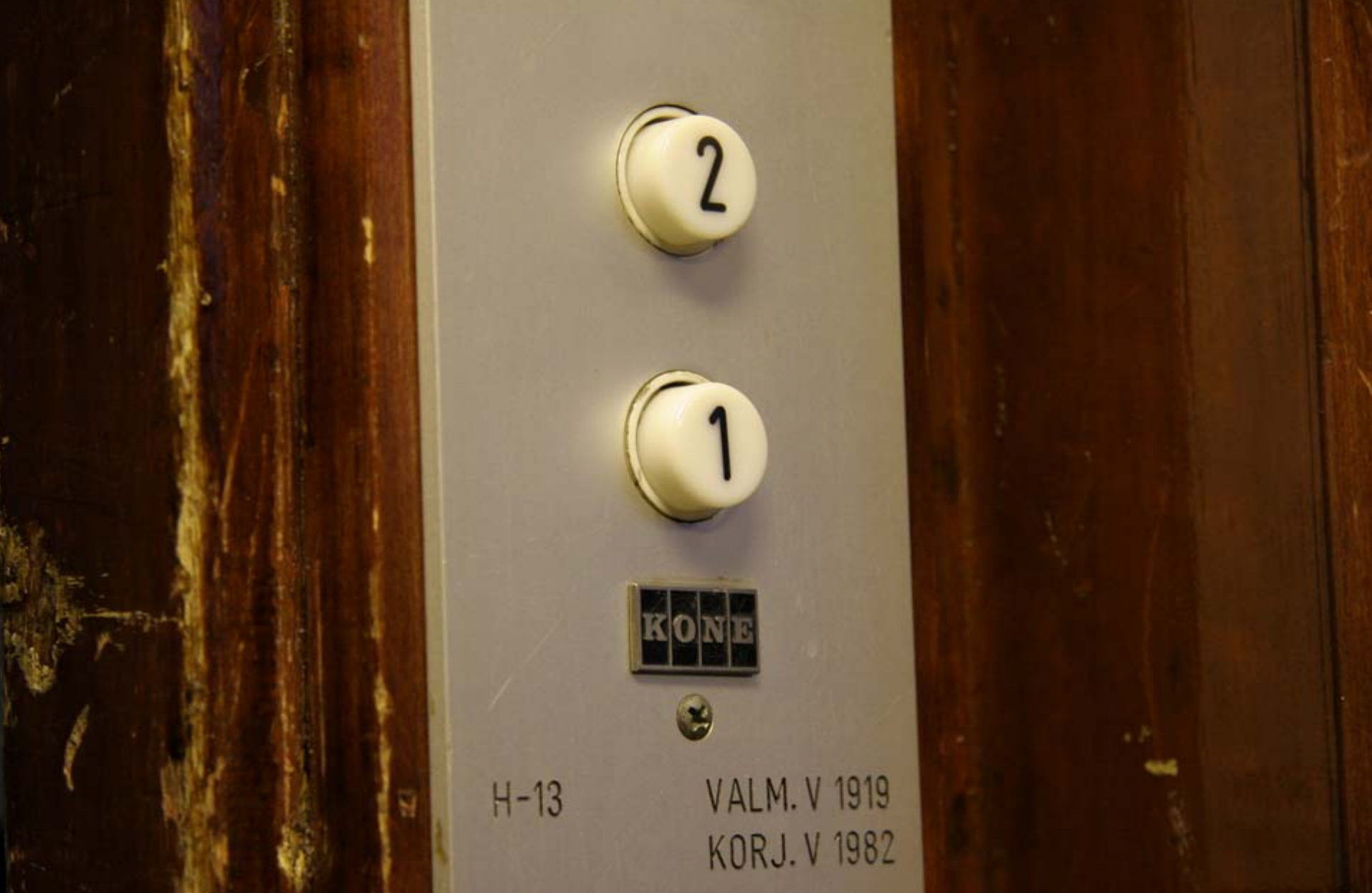
3. Vanhat hissien painonapit ovat värykseltään hyvät, musta numero valkoisella pohjalla, mutta kooltaan liian pienet. (Freesenkatu)
