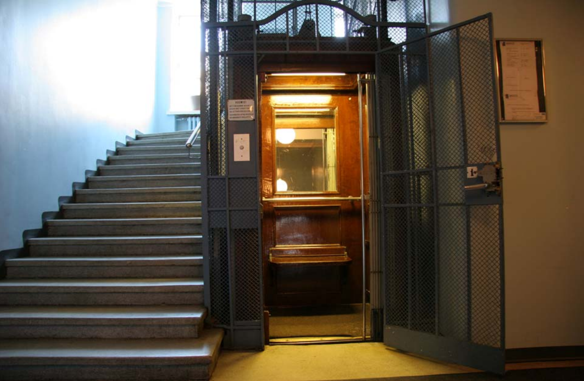
1. Vanhoissa hisseissä ongelmana ovat korin liian pieni koko, oviaukon riittämätön leveys, painonappien sijainti liian korkealla ja hissien sijainti usein portaiden takana. (Freesenkatu)
