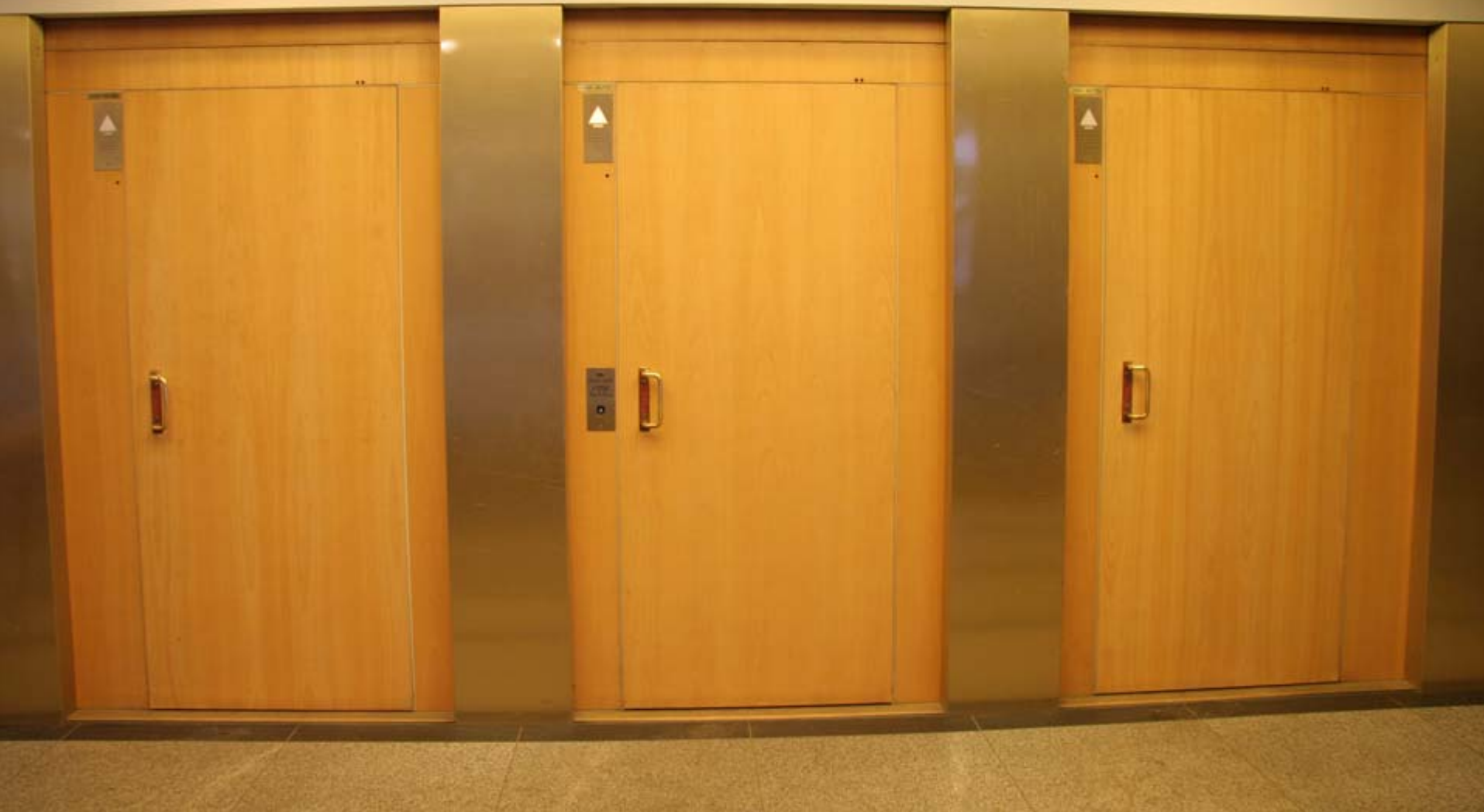
5. Vaikka tämä rakennus on 1950-luvulta, sen kolme hissiä ovat kooltaan nykyvaatimusten mukaiset 8 hengen standardihissit. Kääntöovet tulisi kuitenkin vaihtaa liukuoviksi. (Aleksanterinkatu 48)
