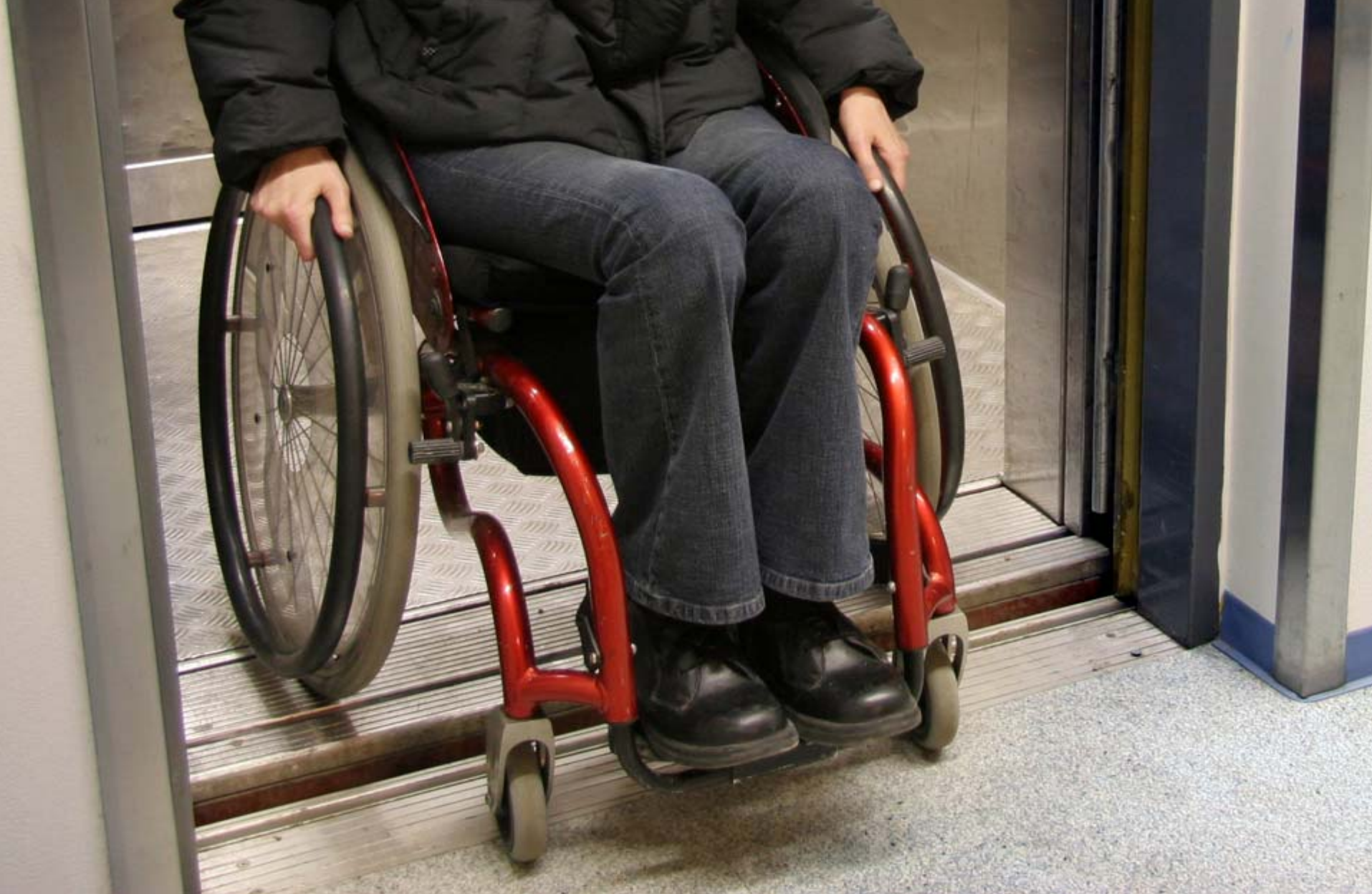
15. Hissin pysähtymistarkkuuden tulee olla \pm 20 mm. Uusissa hisseissä päästään \pm 10 mm:n pysähtymistarkkuuteen. (Siltasaarenkatu 4)
