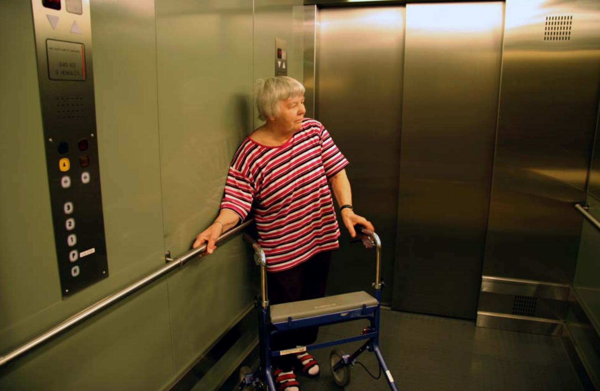
11. Rollaattorilla ei voi peruuttaa ulos hissistä, kuten pyörätuolilla. Tämän hissien kori on riittävän leveä rollaattorilla kääntymiseen eli vähintään 1200 mm. (Riistavuoren vanhustenkeskus)
