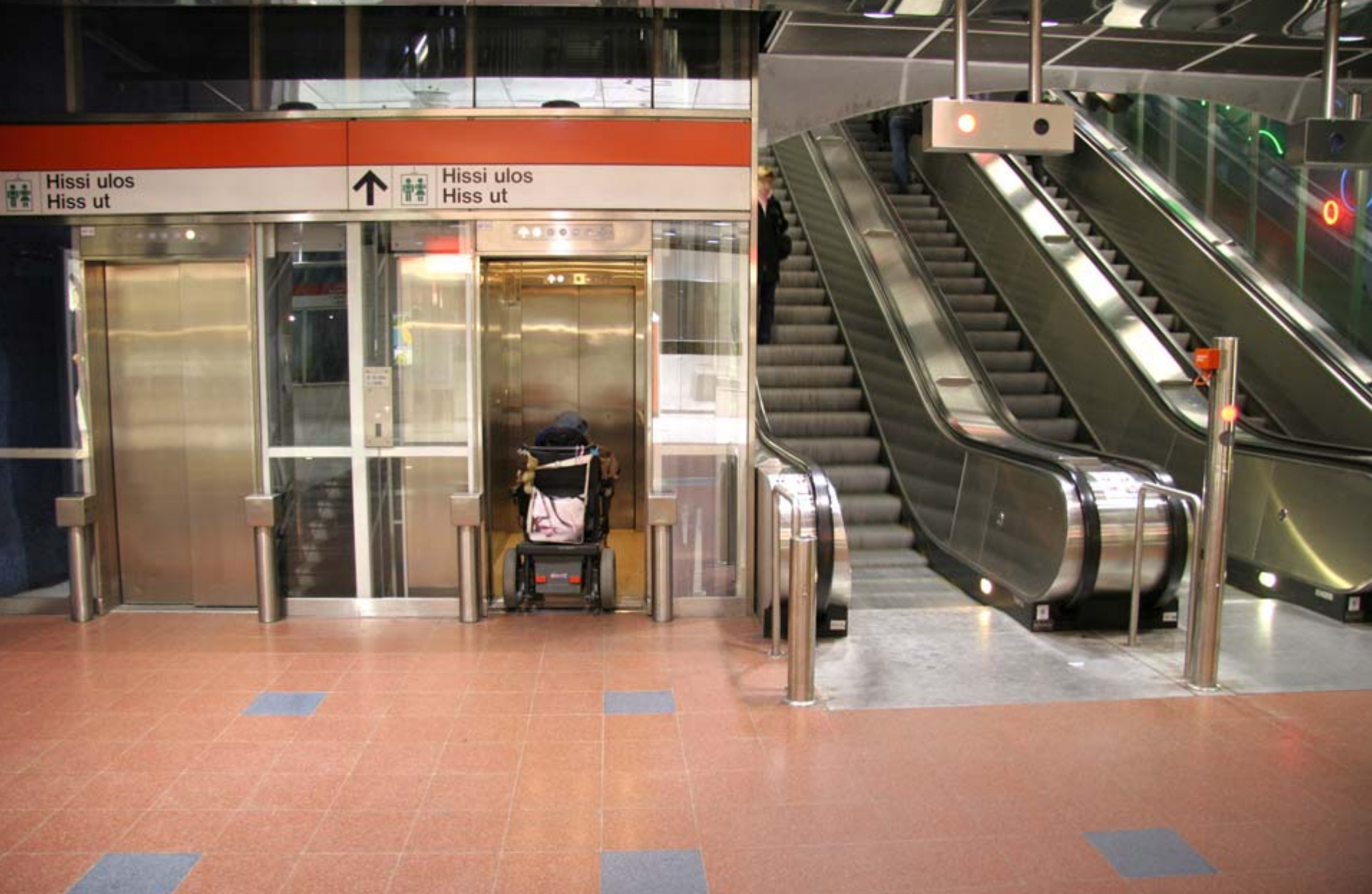
23. Liukuportaiden lisäksi tarvitaan aina myös hissi. Tämä läpikulkuhissi kulkee vinottain liukuportaan vieressä. (Kaisaniemen metroasema)
