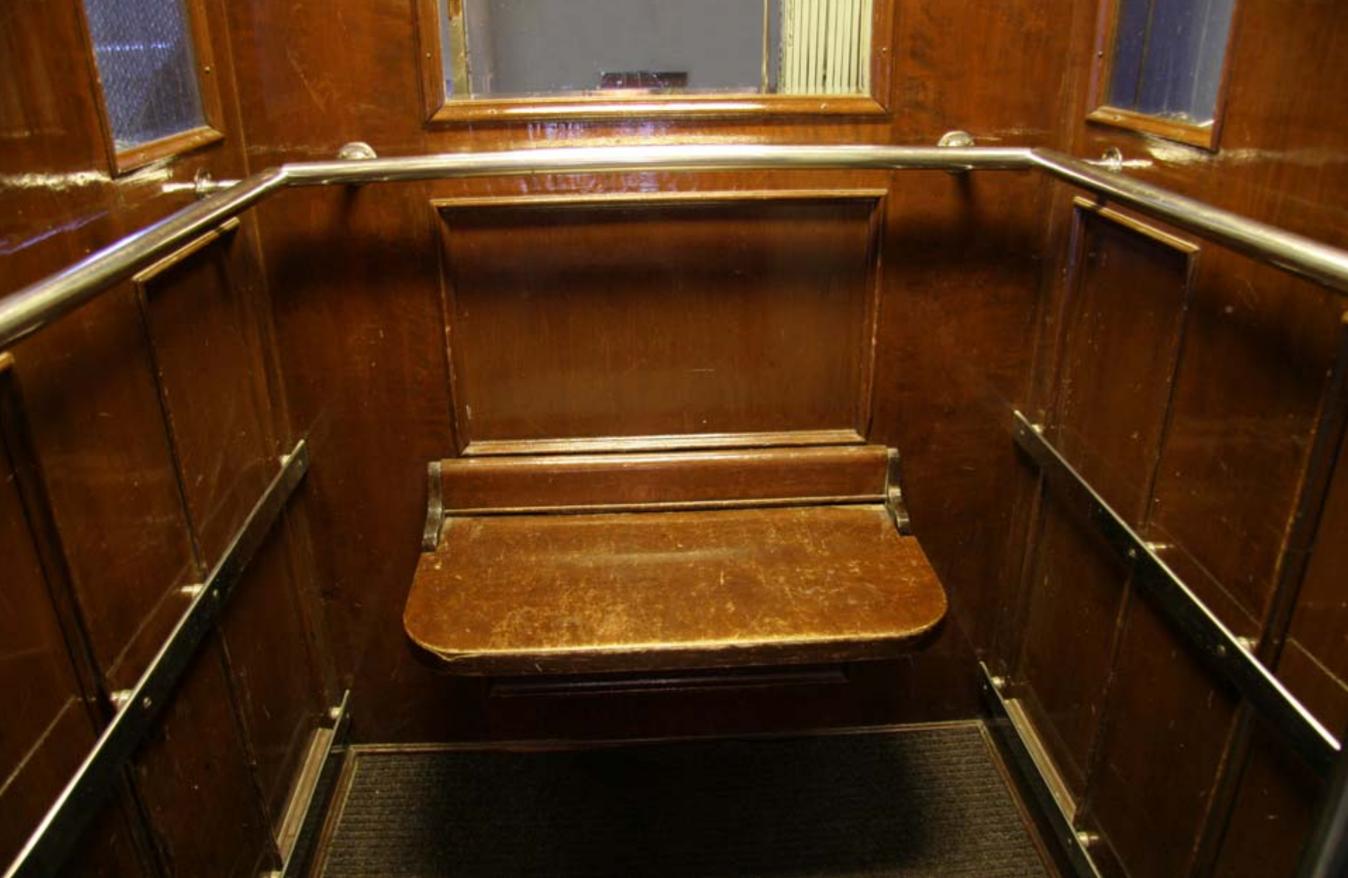
2. Hissin varusteina voivat olla käsijohteen lisäksi peili ja kääntöistuin. (Freesenkatu)
