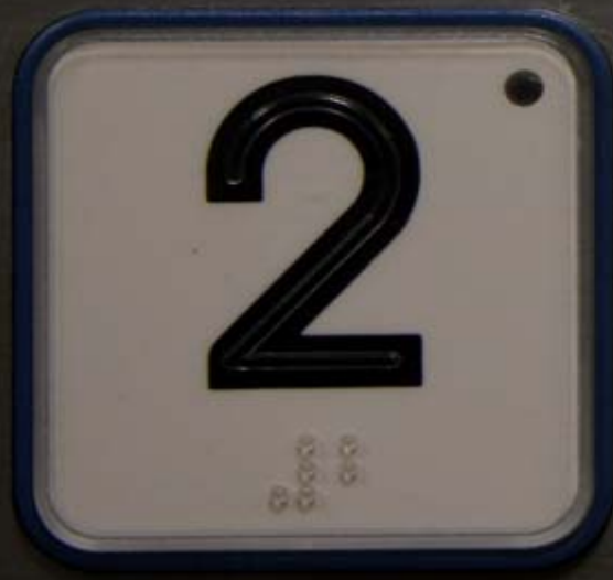
17. Suurissa painonapeissa on selkeät numerot. Parhaiten näkyy musta numero valkoisella pohjalla kuten tässä. Painonappien järjestys ei ole standardin mukainen. (Siltasaarencatu 4)
