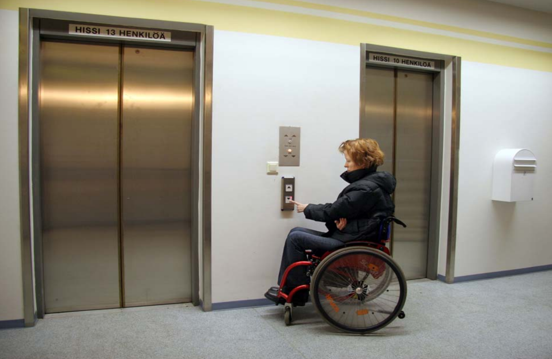
14. Näiden hissien alkuperäiset kutsunapit ovat liian korkealla. Uudet kutsunapit on asennettu pyörätuolin käyttäjän ulottuville. (Siltasaarencatu 4)
