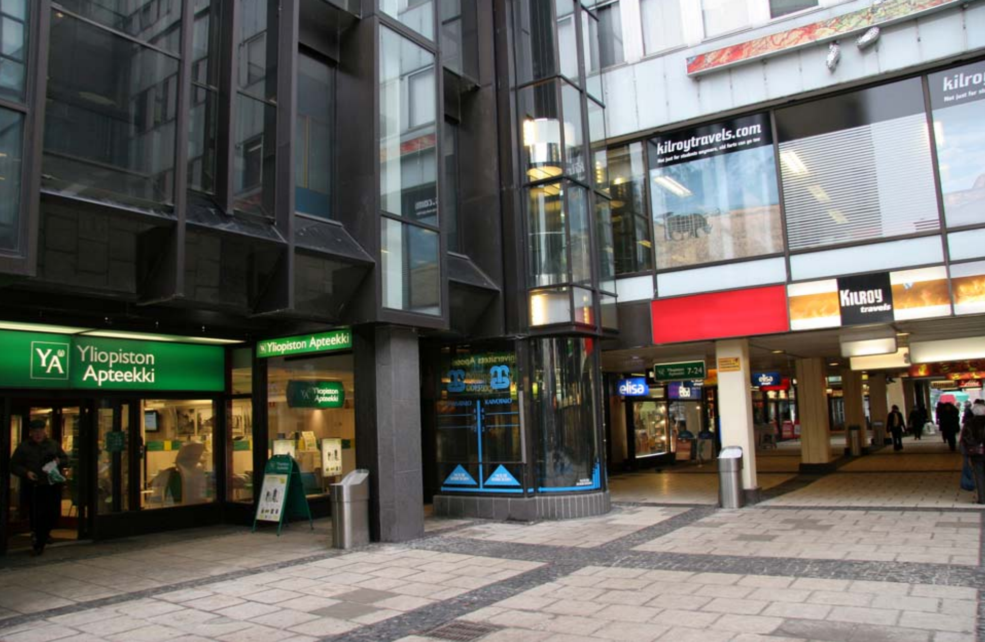
22. Uusi hissitori on sijoitettu rakennusrungon ulkopuolelle. (Kaivopiha)
