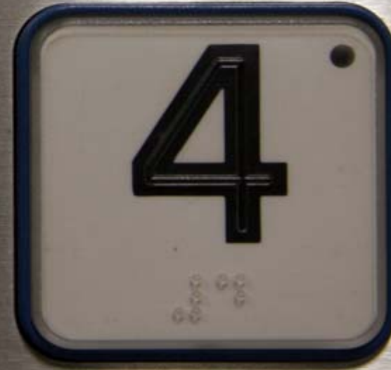
17. Suurissa painonapeissa on selkeät numerot. Parhaiten näkyy musta numero valkoisella pohjalla kuten tässä. Painonappien järjestys ei ole standardin mukainen. (Siltasaarencatu 4)
