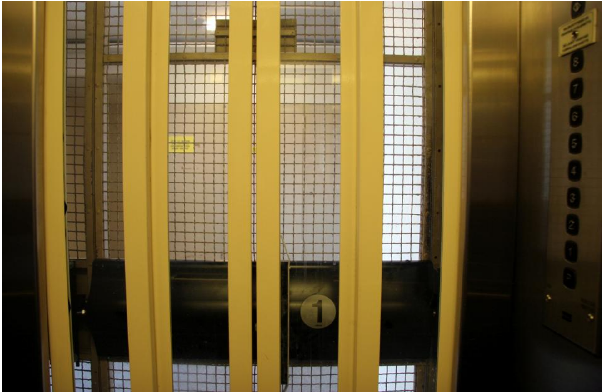
20. När hissen moderniserades byttes i hisskorgens grind till automatiska skjutdörrar med glasrutor. Det är angenämare att använda hissen när man kan se ut. (Kuortanegatan 13)
