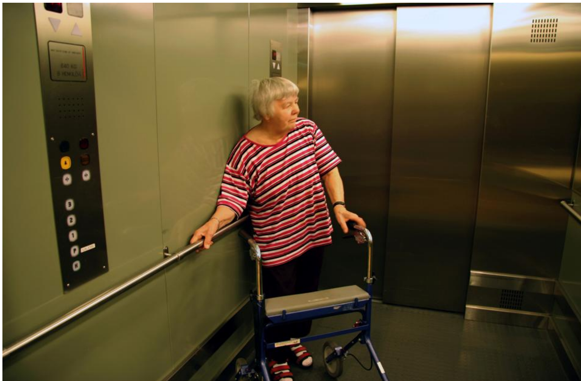
11. Med rollator går det inte att backa ut ur hissen på samma sätt som med rullstol. Korgen i denna hiss är tillräckligt bred för att vända med rollator, dvs. minst 1200 mm. (Djurbergets servicecentral)
