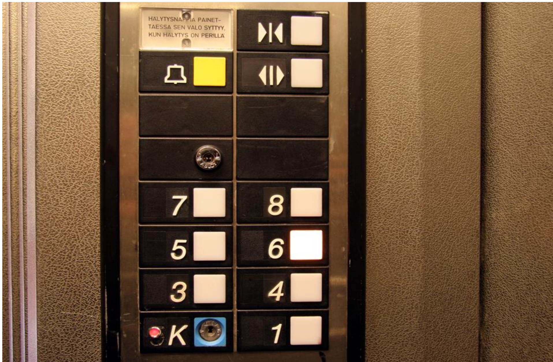
19. Hissens tryckknappar är tydliga, de har bra kontrast och ordningsföljden följer EU-standarderna: från vänster till höger och nerifrån upp. (Mikaelsgatan 13)
