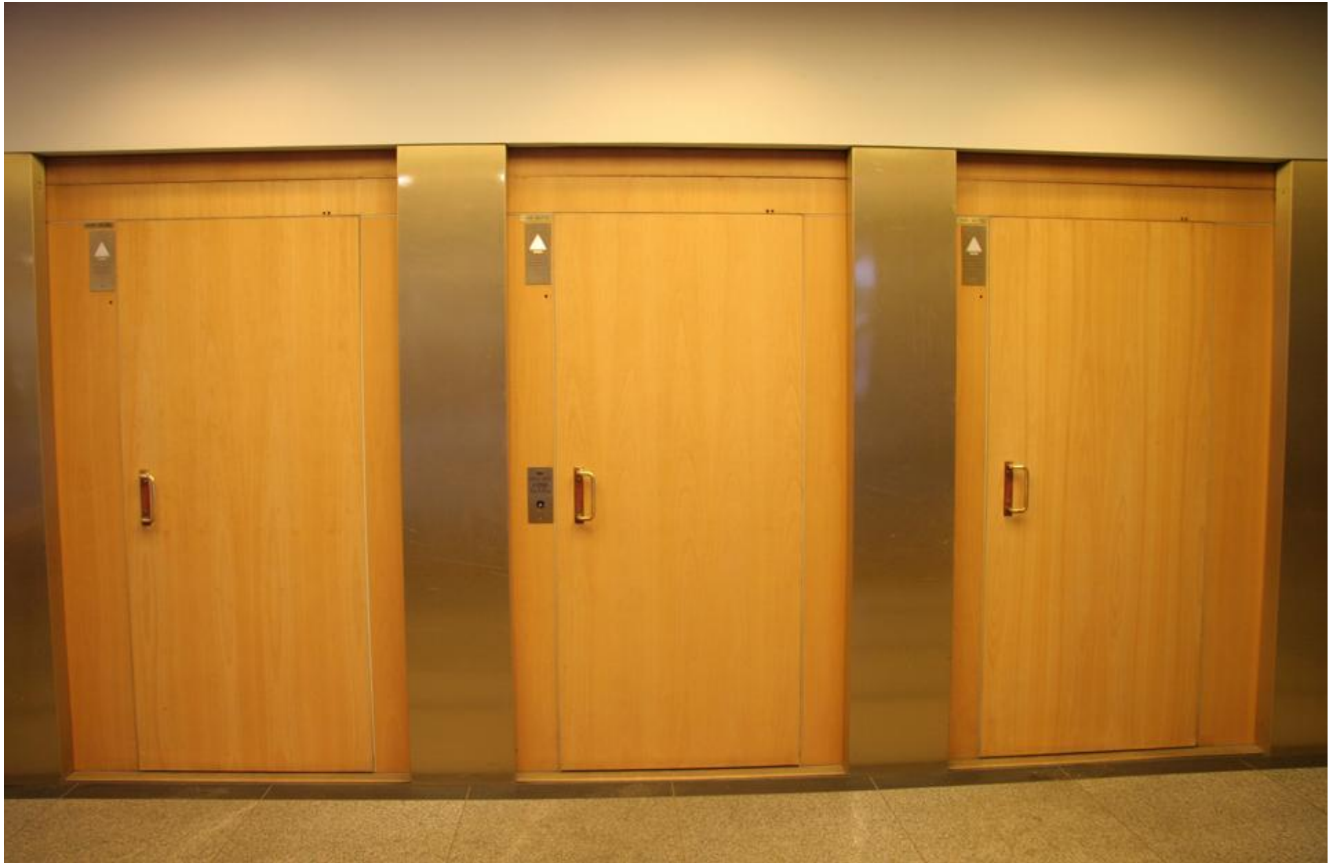
5. Fastän denna byggnad är från 1950-talet, uppfyller storleken på de tre hissarna dagens krav för standardhissar för 8 personer. Svängdörrarna borde ändå bytas ut mot skjutdörrar. (Alexandersgatan 48)
