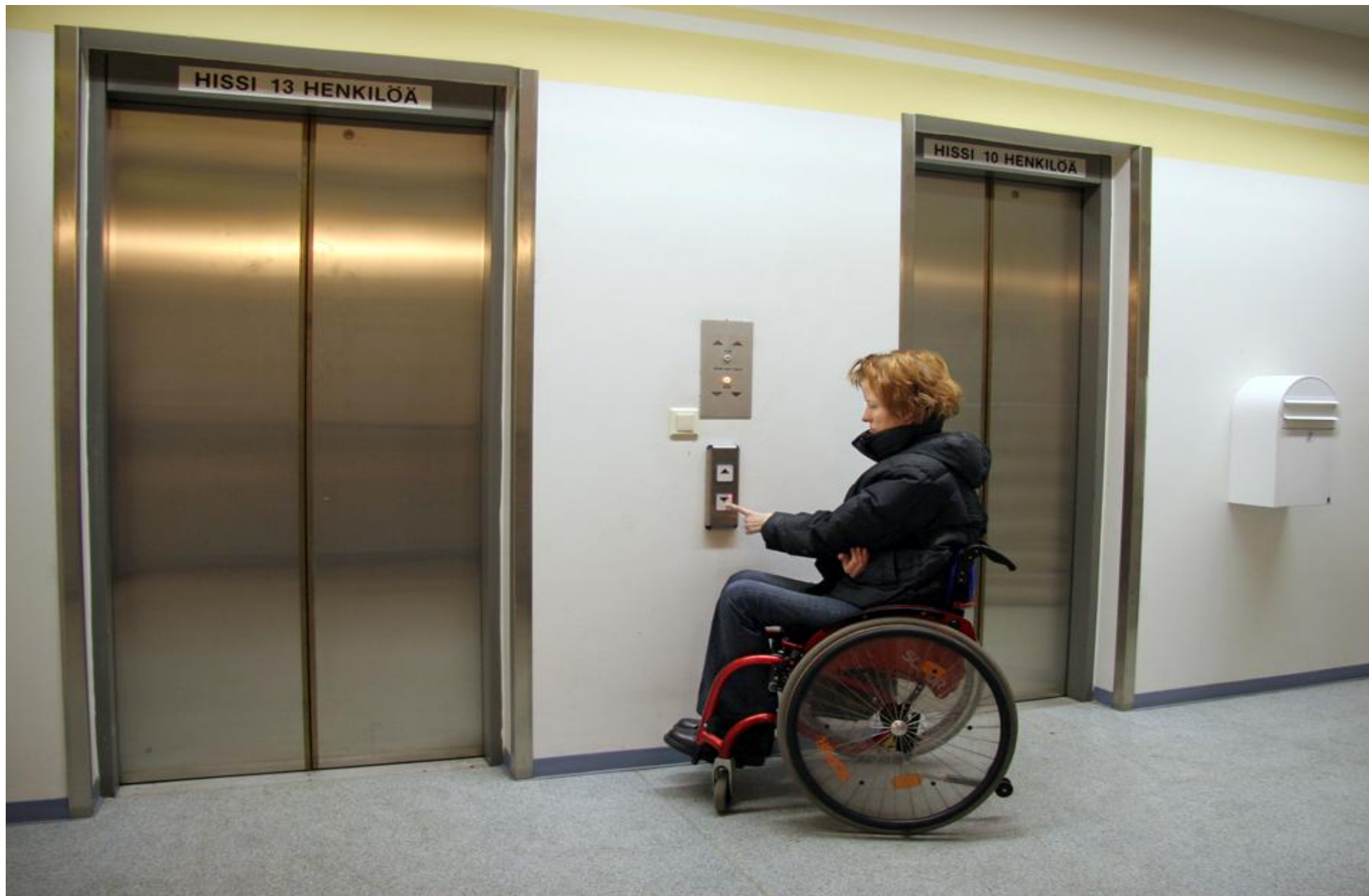
14. I dessa hissar sitter de ursprungliga anropsknapparna för högt. De nya anropsknapparna har installerats så att de kan nås av rullstolsanvändare. (Broholmsgatan 4)
