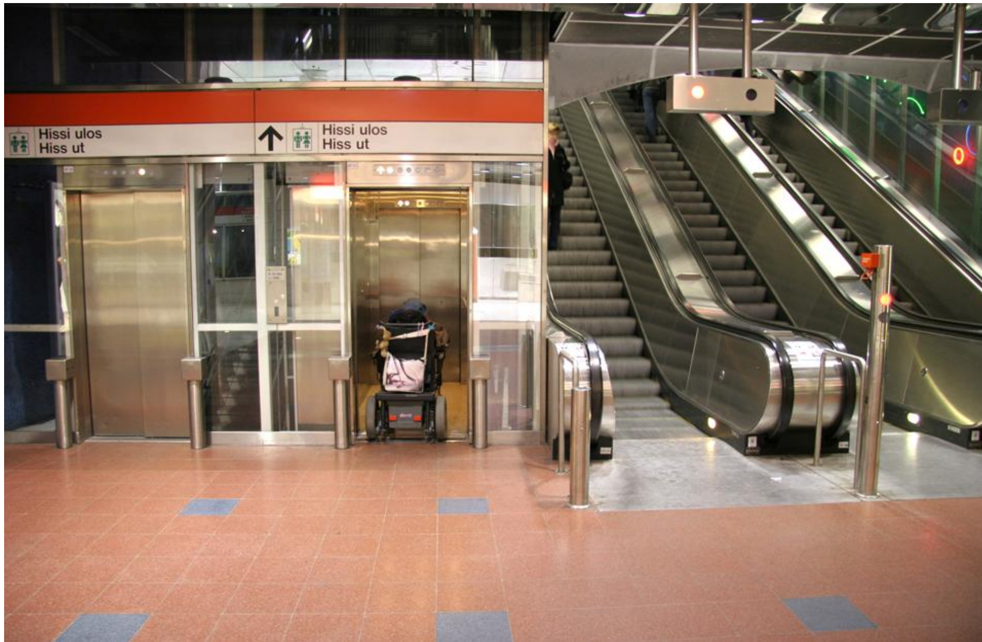
23. Förutom rulltrappor behövs det också alltid en hiss. Denna genomgångshiss går snett bredvid rulltrappan. (Kajaniemi metrostation)
