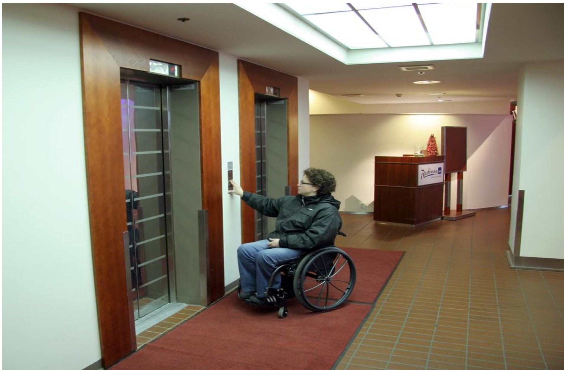
7. Det fria utrymmet framför hissdörren skall vara åtminstone så stort, att det går att vända med rullstol, dvs. 1500 mm x 1500 mm. Rekommenderat utrymmesdjup är en och en halv gånger hisskorgens djup. (Radisson SAS Seaside Hotel)
