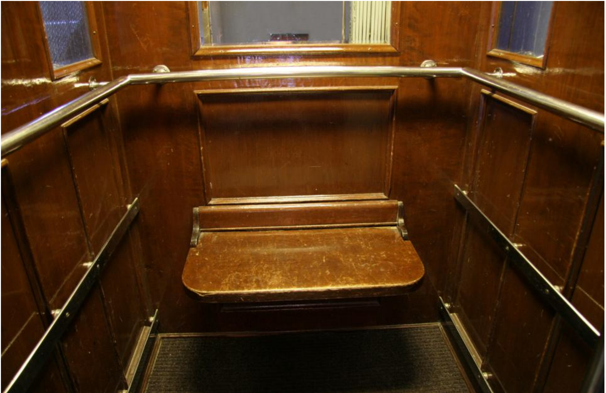
2. Hissen kan vara utrustad med ledstång och dessutom spegel och nedfällbar sits. (Freesekatan)
