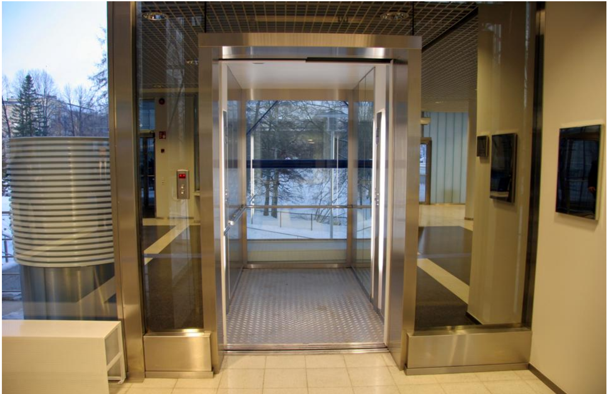
21. Det kan vara svårt för en person med svag syn att urskilja hissen med glasväggar. (Tammerforshuset)
