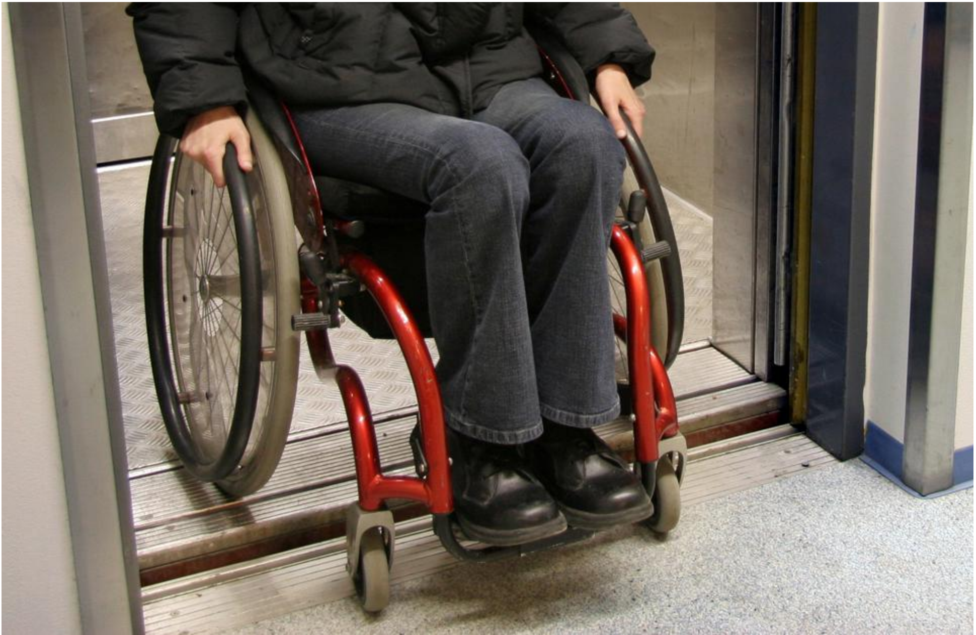
15. Hissens plannoggrannhet skall vara \pm 20 mm. I nya hissar nås en plannoggrannhet som är \pm 10 mm. (Broholmogatan 4)
