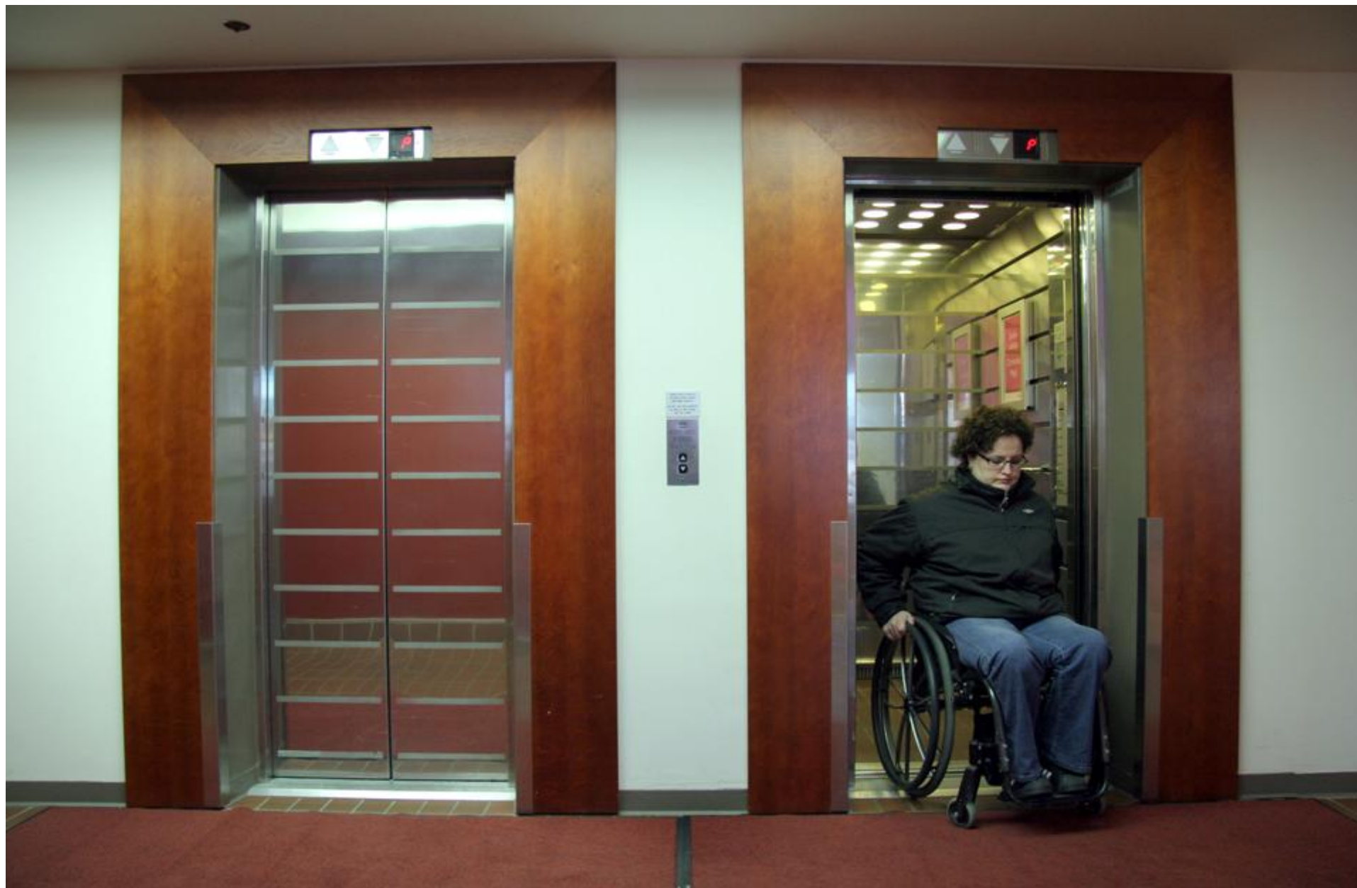
6. De inre måtten på hisskorgen i en standardhiss för 8 personer är 1100 mm x 1400 mm. Dörren finns i kortväggen och dess fria bredd är 900 mm. Det är lätt att hitta hissdörrarna även med svag syn tack vare kontrasten mot den omkringliggande väggen. (Radisson SAS Seaside Hotel)
