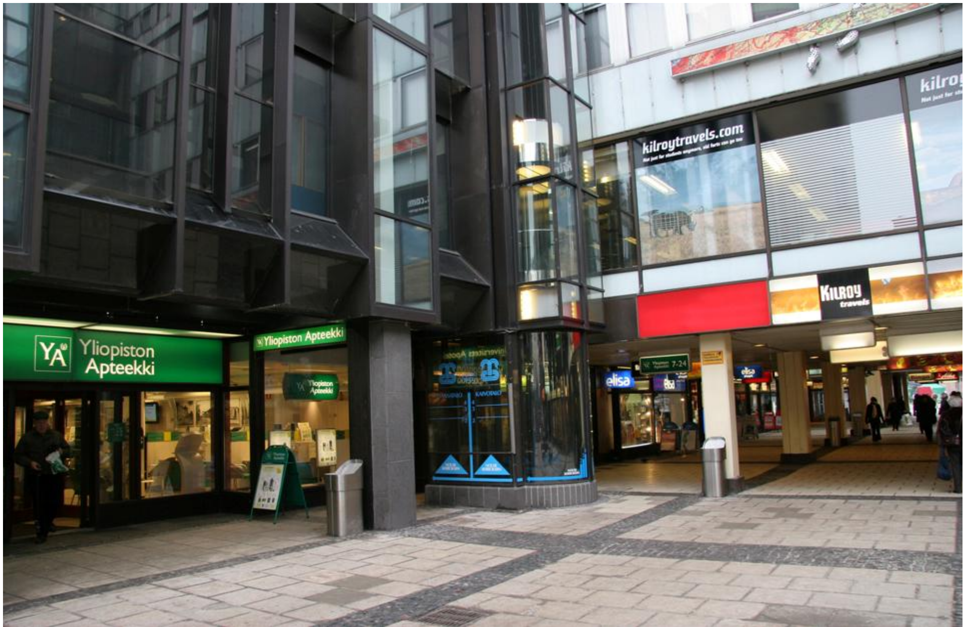
22. Det nya hisstornet har placerats utanför byggnadsstommen. (Brunnsgråden)
