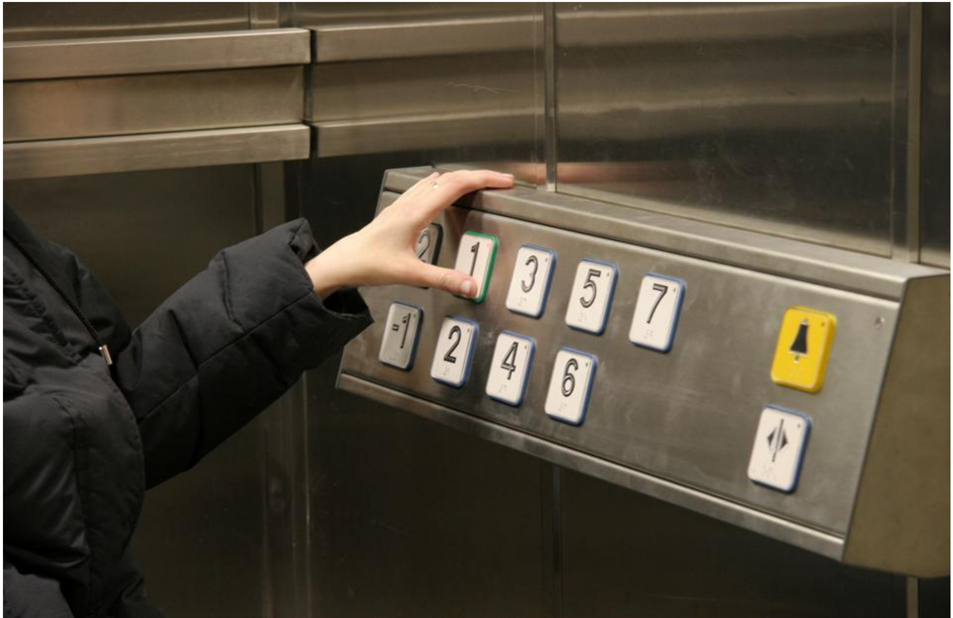
16. De ursprungliga tryckknapparna i hisskorgen sitter för högt uppe. Tryckknapparna lägre ner har installerats senare. (Broholmsgatan 4)
