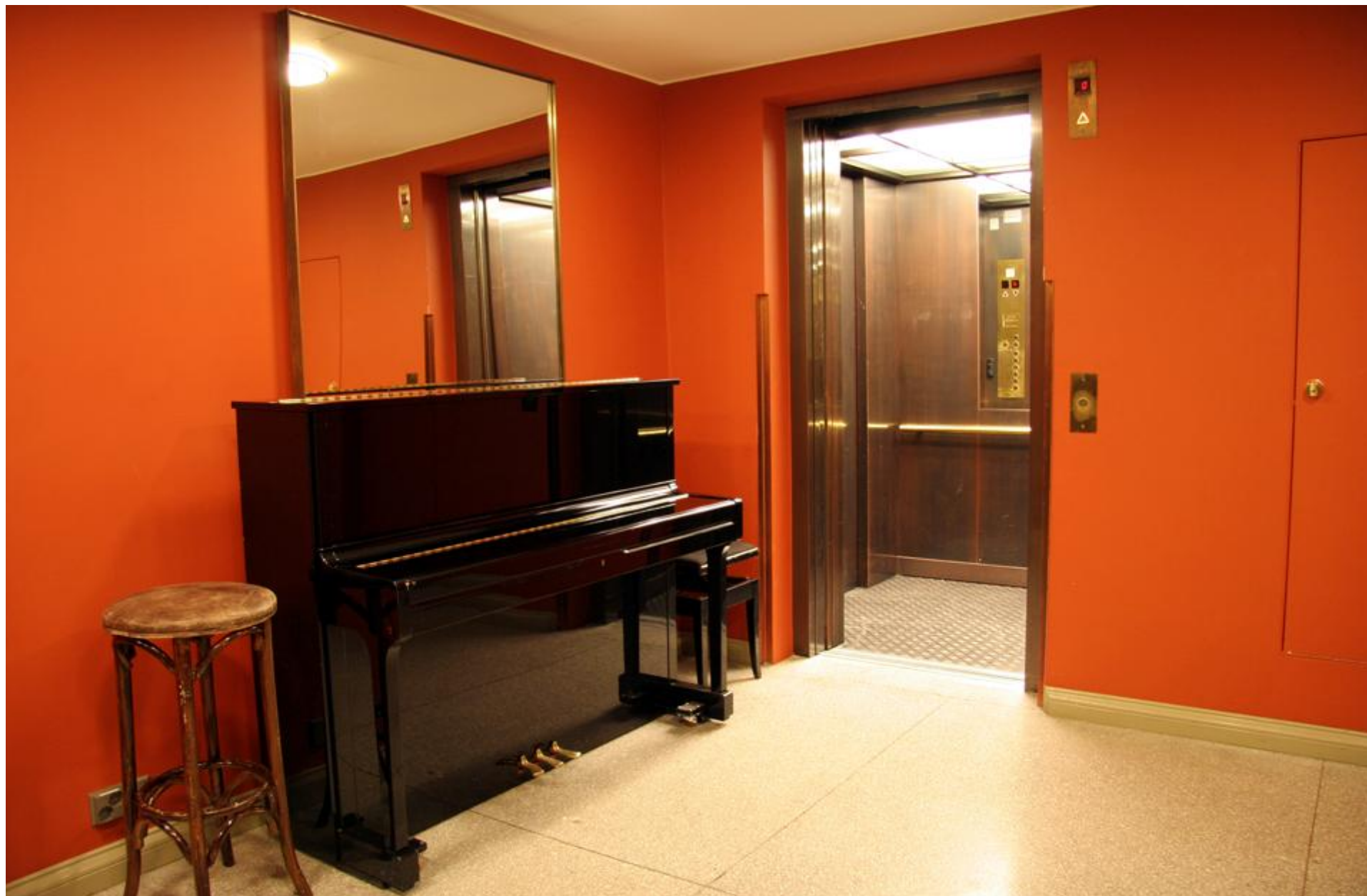
9. Hisskorgens dörrar finns här i intilliggande väggar och då skall korgen vara 1400 mm x 1400 mm. Byggnadens yttre vägg har förtunnats vilket gett utrymme för en tillräckligt rymlig hiss. (Finlands Nationalteater)
