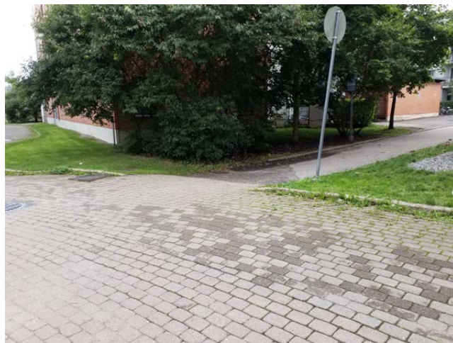
Kuva 68. Kaupparaitilla kunnostetaan mm. pintamateriaalit ja rakenteelliset ongelmat.
