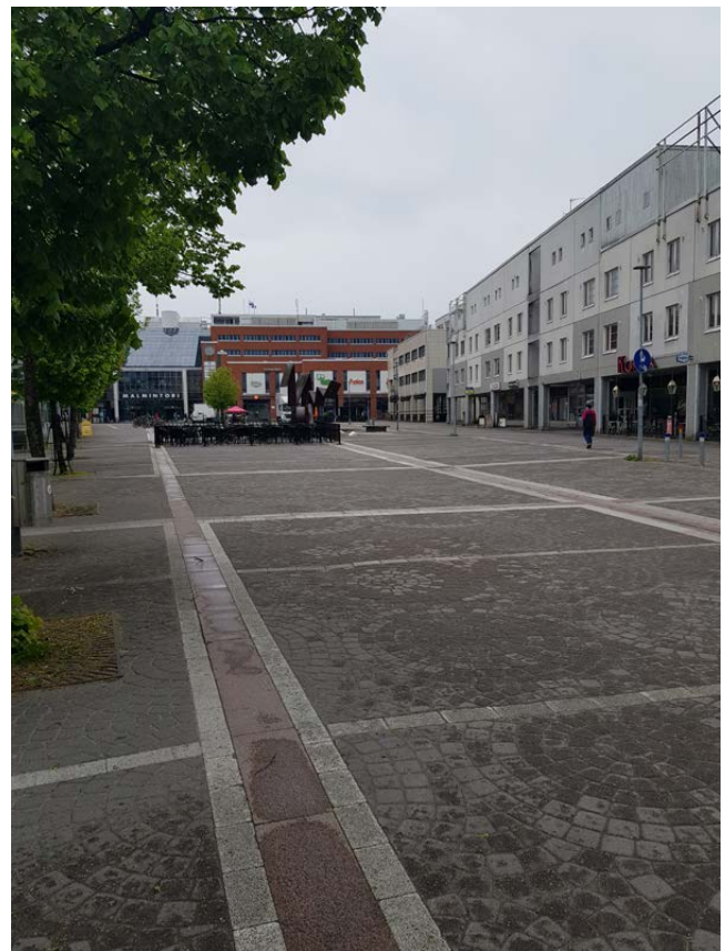
Kuva 67. Ylä-Malmin tori peruskorjataan kokonaisuudessaan.
