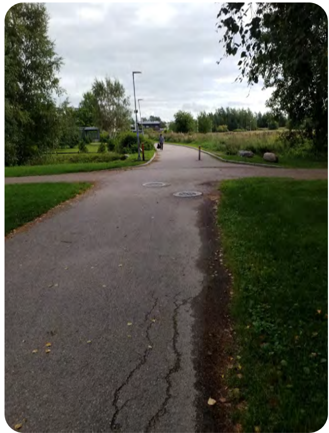
Kuva 40. Sammalpolun liittyminen Helluntairaittiin.
