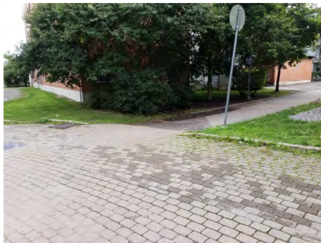
Kuva 68. Kaupparaitilla kunnostetaan mm. pintamateriaalit ja rakenteelliset ongelmat.
