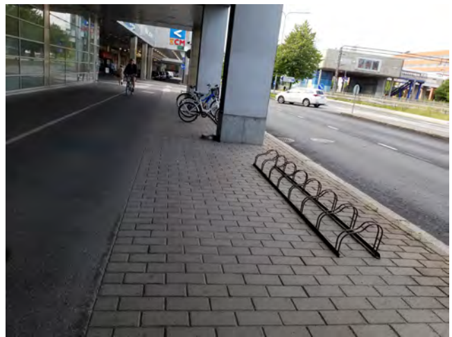
Kuva 86. Malminkaaren pyörätelineet uusitaan ja ajoradan viereen asennetaan kaide.
