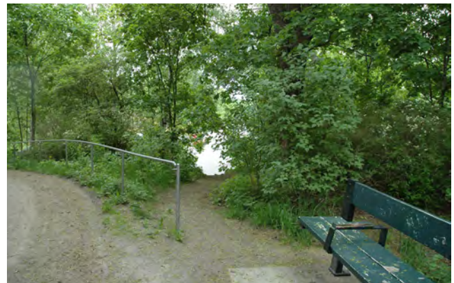
Kuva 65. Kirkkopuiston kalusteet kunnostetaan ja vaaralliselle reitille kulun estävää kaidetta jatketaan.
