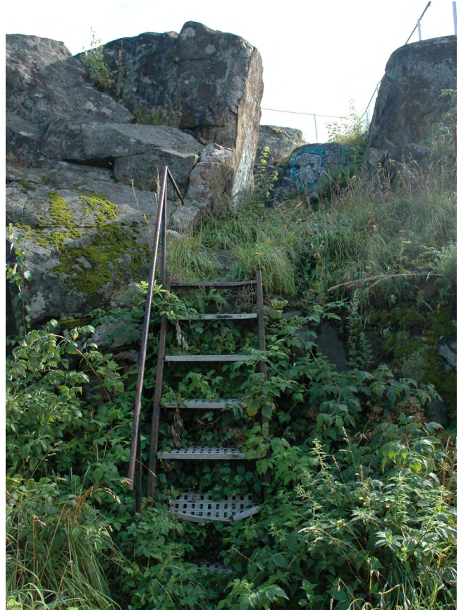
Kuva 79. Ormusmäelle rakennetaan turvalliset kulureitit. Kuvassa nykyiset huonokuntoiset portaat.
