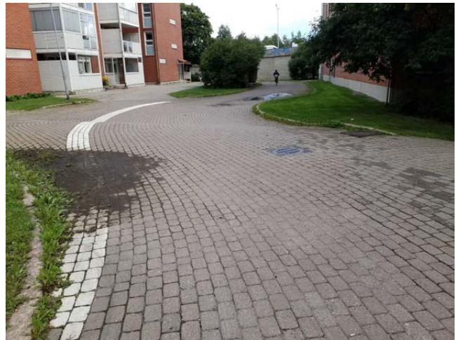
Kuva 65. Kaupparaitilla kunnostetaan mm. pintamateriaalit ja rakenteelliset ongelmat.
