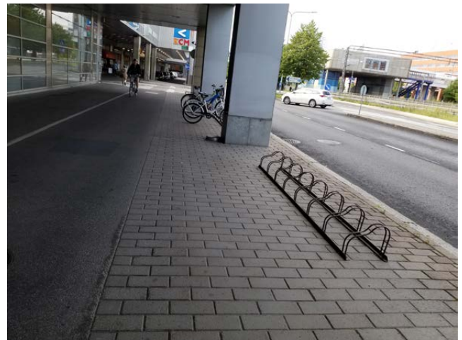
Kuva 83. Malminkaaren pyörätelineet uusitaan ja ajoradan viereen asennetaan aita.
