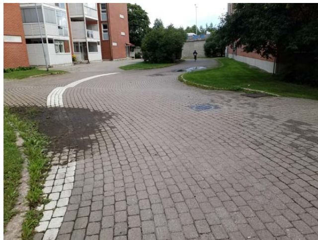
Kuva 65. Kaupparaitilla kunnostetaan mm. pintamateriaalit ja rakenteelliset ongelmat.
