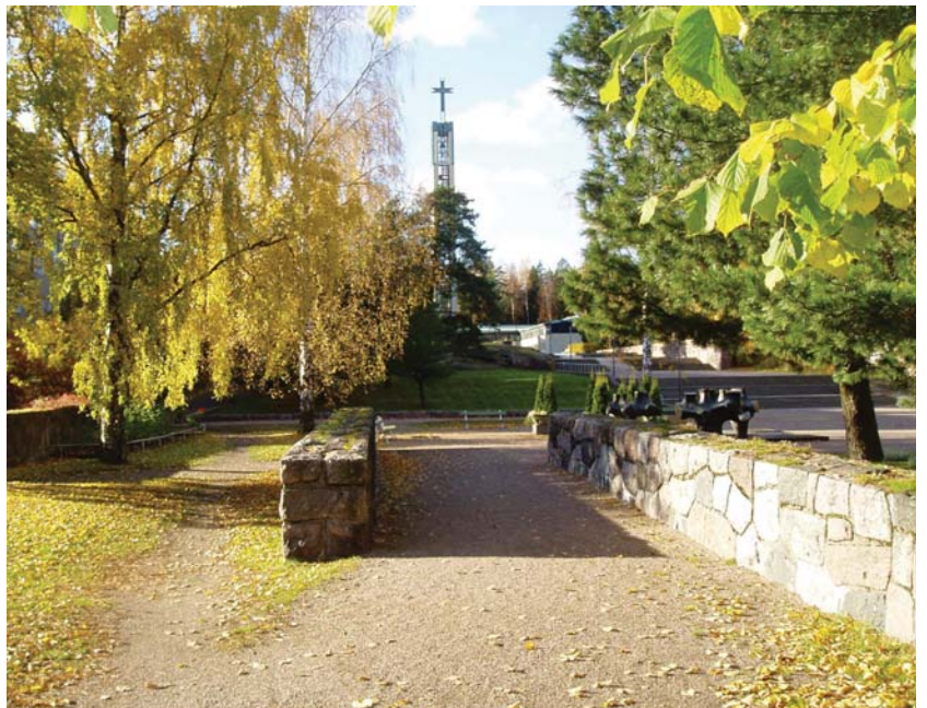
Kirkkopuiston sisäänkäynnit ovat kuluneita.
