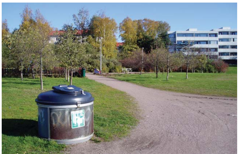
Syväkeräyssäiliöiden alustojen viimeistelyyn kiinnitetään huomiota.
