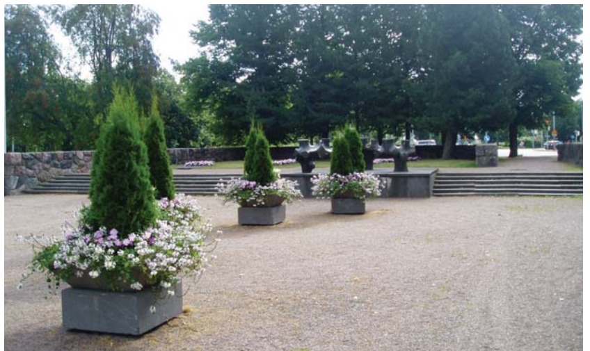
Kirkkopuiston kivituhkapinnoite on paikoitellen rikkaruohottunut.
