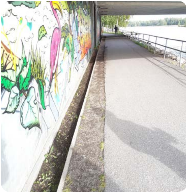
Kuva 74. Päällysteen rajautuminen kouruun ja kourun kunto.
