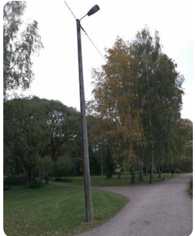
Kuva 76. Valaistus on uusimisen tarpeessa.
