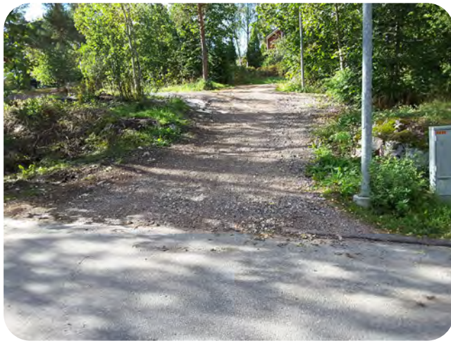
Kuva 73. Peruskorjattava Oravatie-Karhutien raittiyhteyden osuus Näätätien ylityskohdassa.
