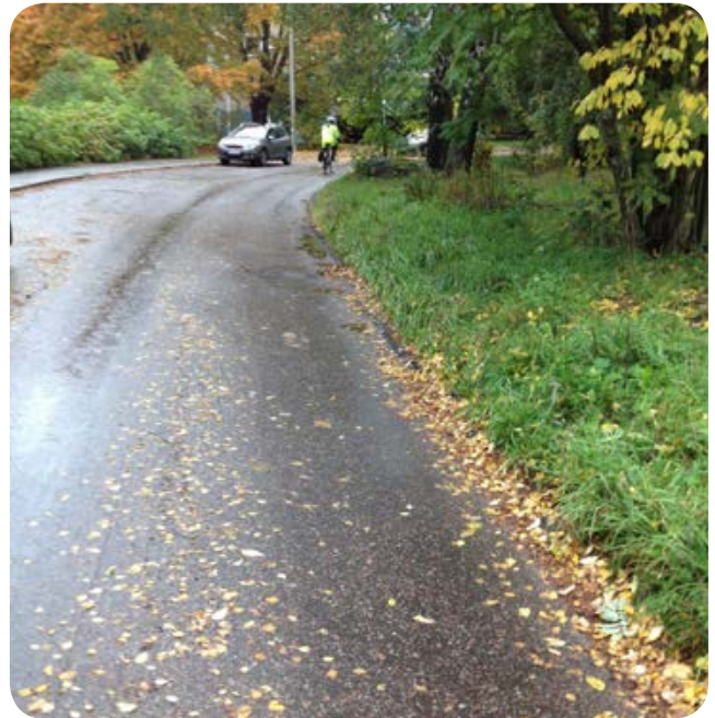
Kuva 69. Laaja reunapainuma, jossa pahimmassa kohdassa rakenteet ovat pettäneet. Asfaltti on levinnyt painuman yhteydessä asfalttimakkaran päälle viheralueen reunassa.
