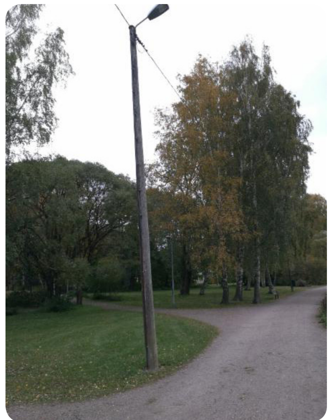
Kuva 76. Valaistus on uusimisen tarpeessa.
