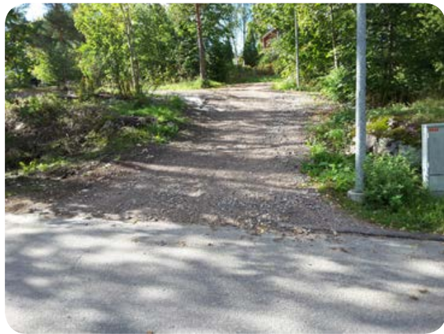
Kuva 78. Peruskorjattava raittiosuus Näätätien ylityskohdassa.
