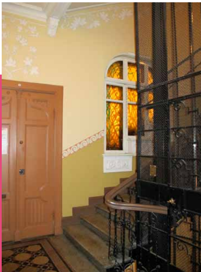
Uudenmaankatu 25:n hyvin säilyneessä ja entistetyssä porrashuoneessa on hieno maalaus- ja reliefikoristelu.
