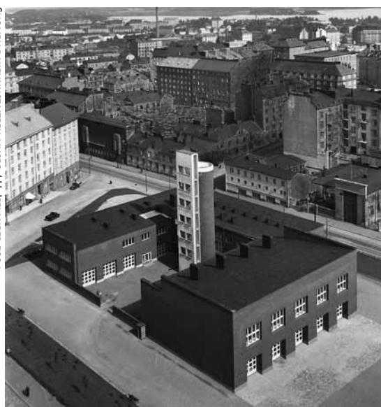
Kallion paloasema funktionalistisessa asussaan vuonna 1934. Kuvassa keskellä yhdistetty letkujen kuivaus- ja harjoitustorni. Rakennusta laajennettiin ja osa siitä purettiin 1970-luvun alkupuolella.
