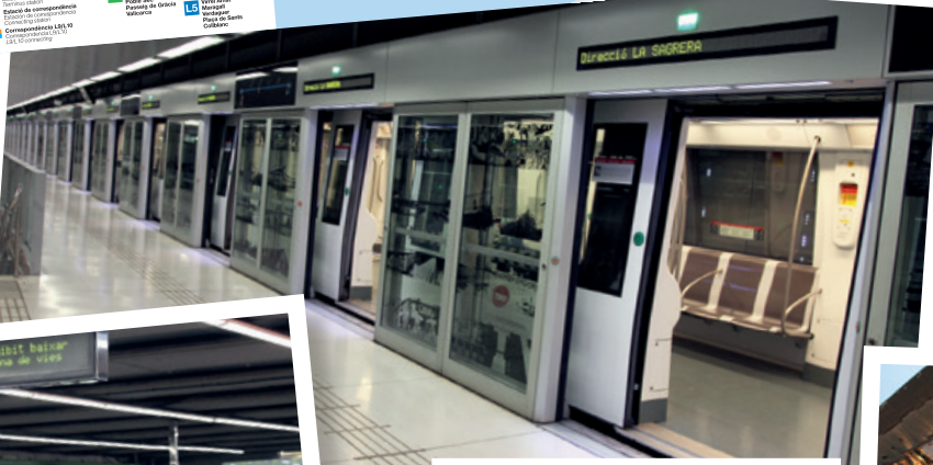
Automaattimetrossa on täyskorkea laiturioviseinä.
