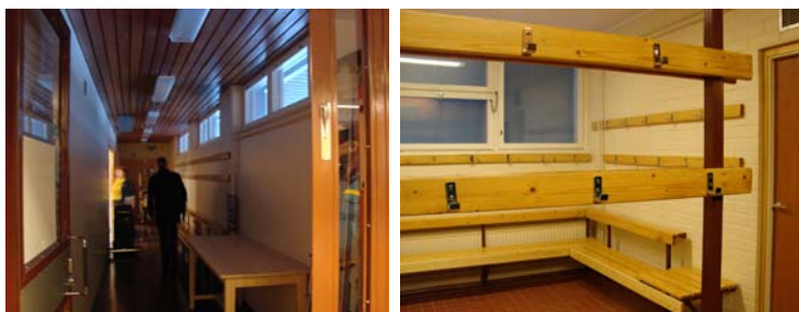
Nykyinen Paloheinän ulkoilumaja - käytävä ja pukuhuonetiloja
