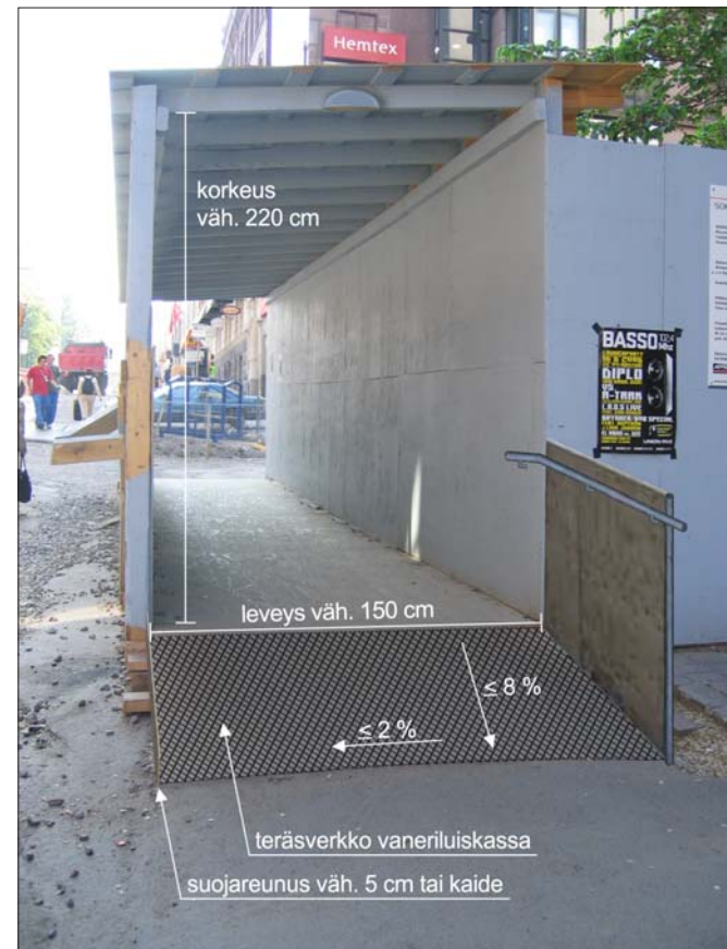
Kuva 5. Sulkuaita/sulkupuomi pitää sijoittaa täsmälleen suojatien kohtaan, jotta näkövammaisen ohjautuu oikealle reitille. Merkkien sijoituskorkeus 1,4–1,6 m.
