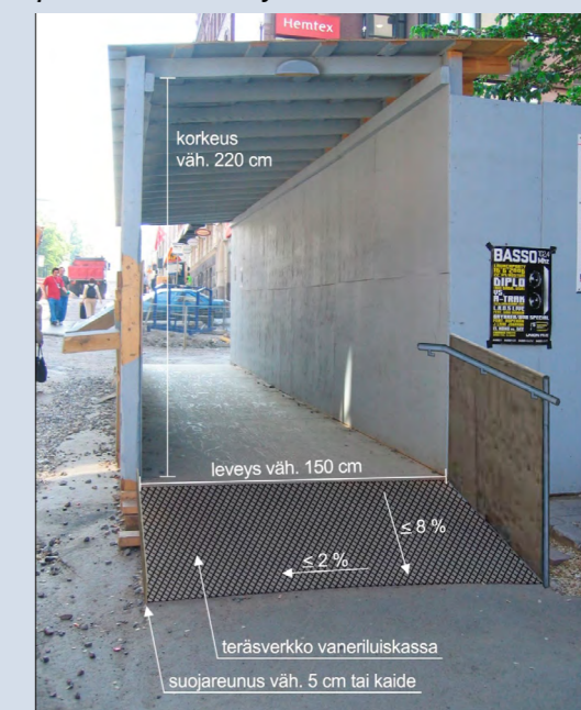
Kuva 4. Esimerkki katetusta työmaa-aikaisesta jalankulkuväylästä ja luiskasta. Luiskan sivuseinä ohjaa kulkijan selkeästi pois ajoradalta. Teräsverkko vaneriluiskan päällä toimii erityisesti talviolosuhteissa.
