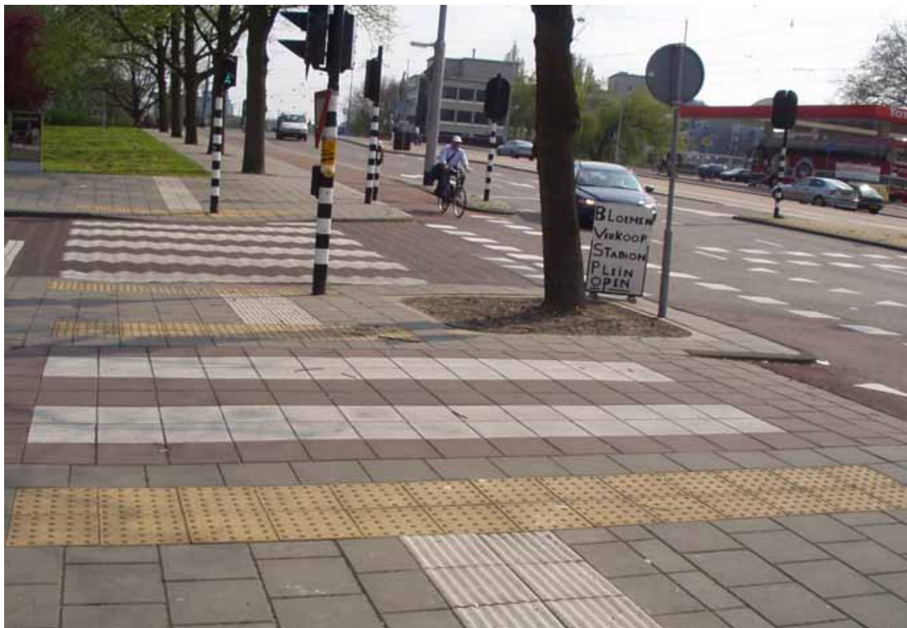
Kuva 14. Amsterdamissa on käytetty betonisia opaslaattoja risteysalueilla monin eri tavoin. Stadionin läheisyydessä risteys on hyvin merkitty, mutta risteävät pyörätiet vaikeuttavat varoitusalueiden hahmottamista.
