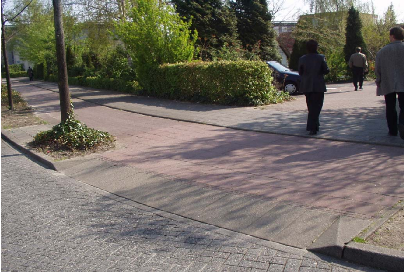
Kuva 8. Hollannissa käytetty betoninen luiskaelementti liittyy luontevasti ympäröiviin päällysteisiin ja rakenteisiin, jotka kaikki ovat myös betonia. Näkövammaisten vaatimusta tunnistettavasta tasoerosta ja kontrastiväristä ei ole huomioitu.
