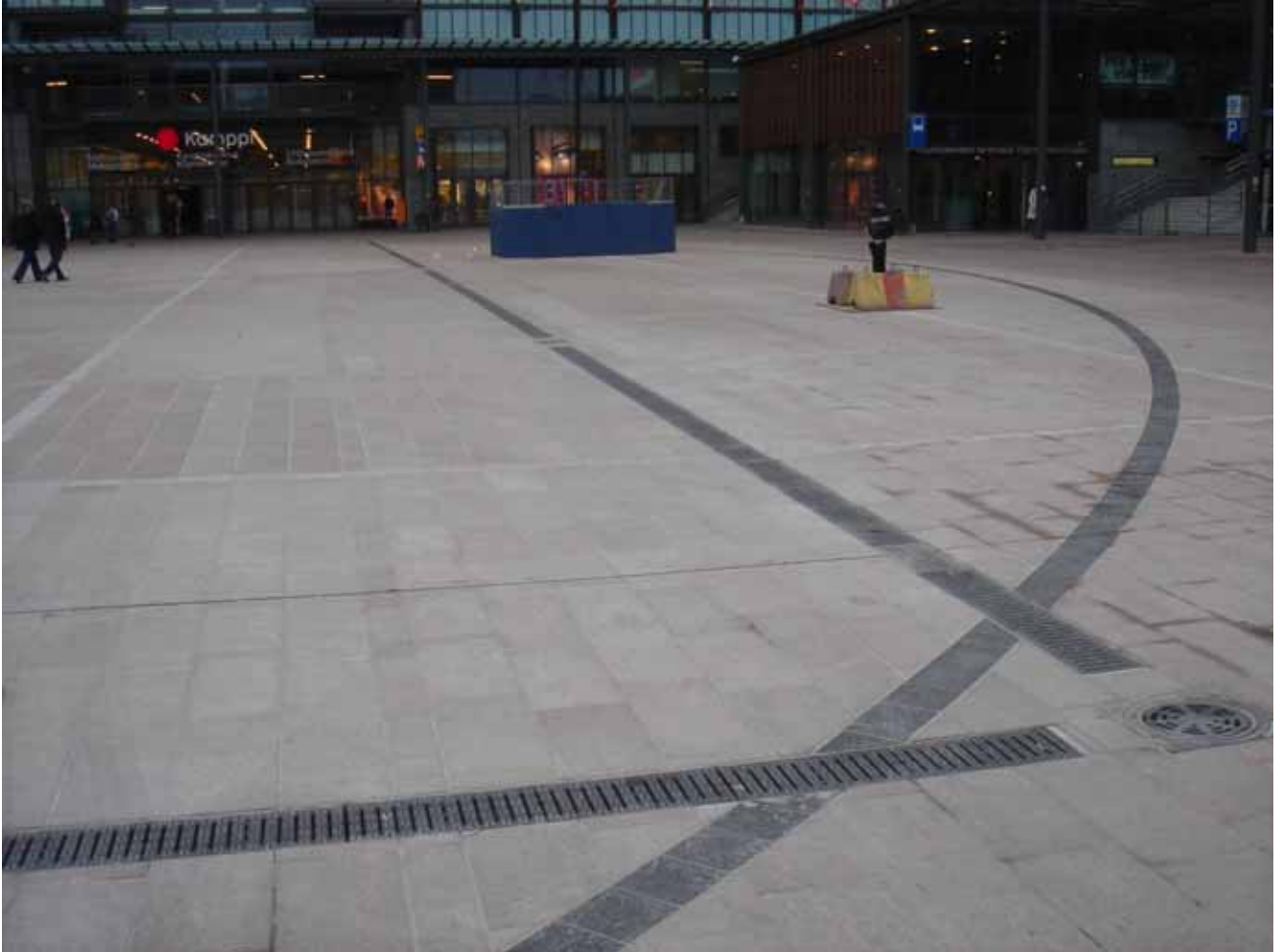
Kuva 29. Kannelliset sadevesikourut voivat toimia näkövammaisten opasraitoina, jos ne on sijoitettu loogisesti. Helsingin Kampissa torilla on rengasmaisen kuvioaihe, joka vaikeuttaa sadevesikourujen ja opasraitojen hahmottamista. (Kuva Näkövammaisten keskusliitto ry)
