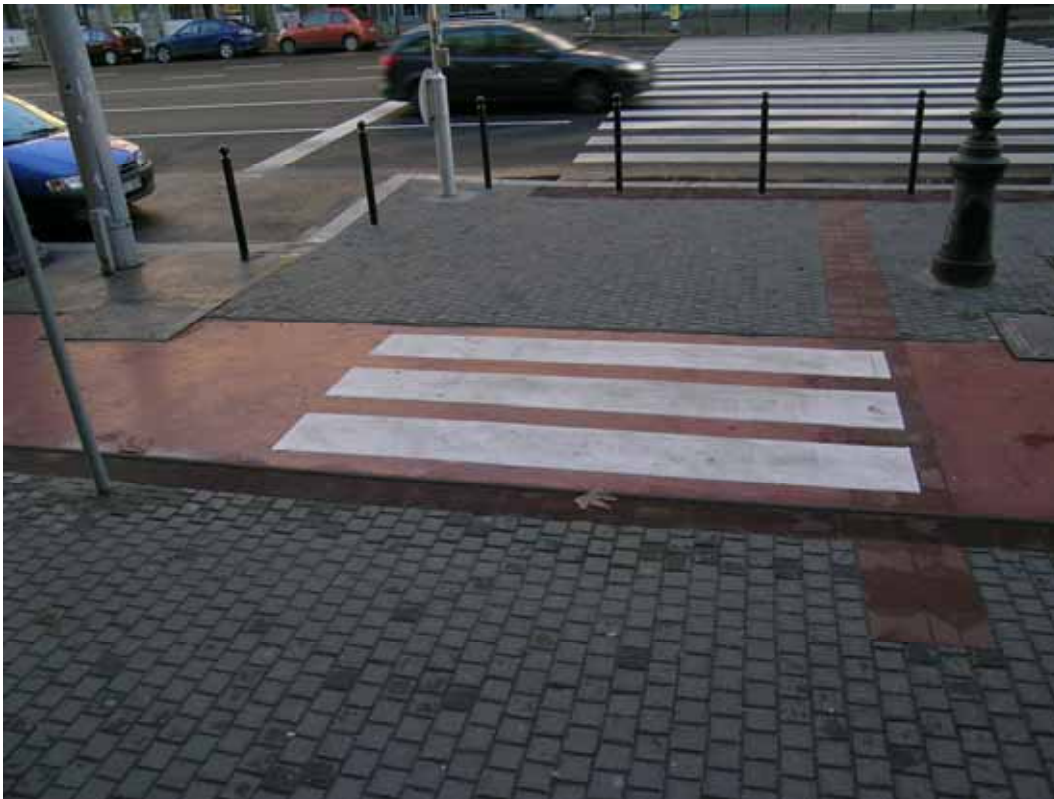
Kuva 19. Ohjaus ja varoitusmateriaalina käytetään usein valkoisia uralaattoja. Budapestissa uralaatat ovat väriltään punaruskeita, jolloin ei synny värikontrastia. Pyörätien reunassa on lisäksi käytetty kohoraitaa.
