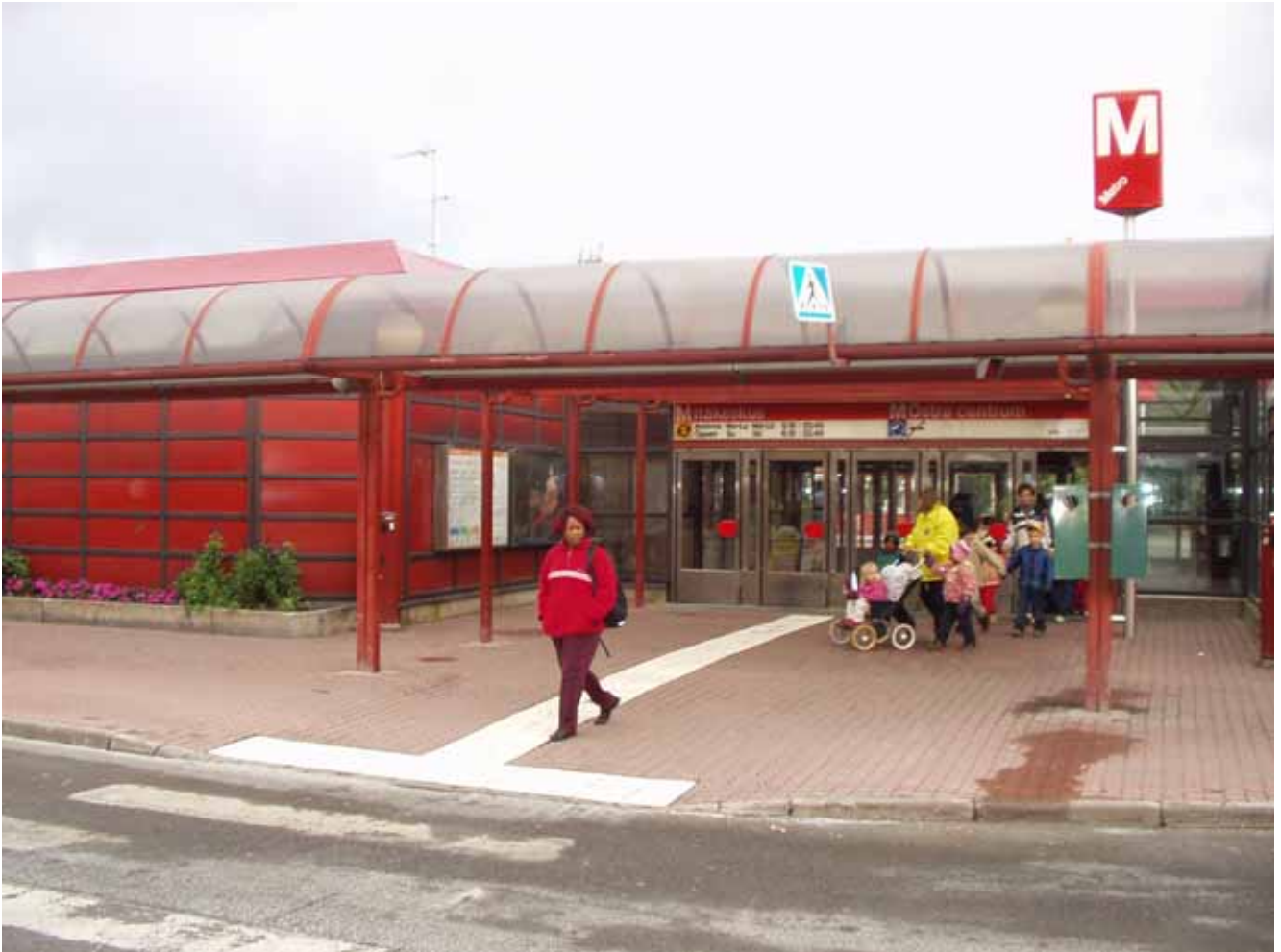
Kuva 15. Itäkeskuksen metroasemalta Näkövammaisten Keskusliitto ry:n toimitalolle johtavalla reitillä on käytetty koeluontoisesti maalattuun metallilevyyn perustuvia koholaattoja.
