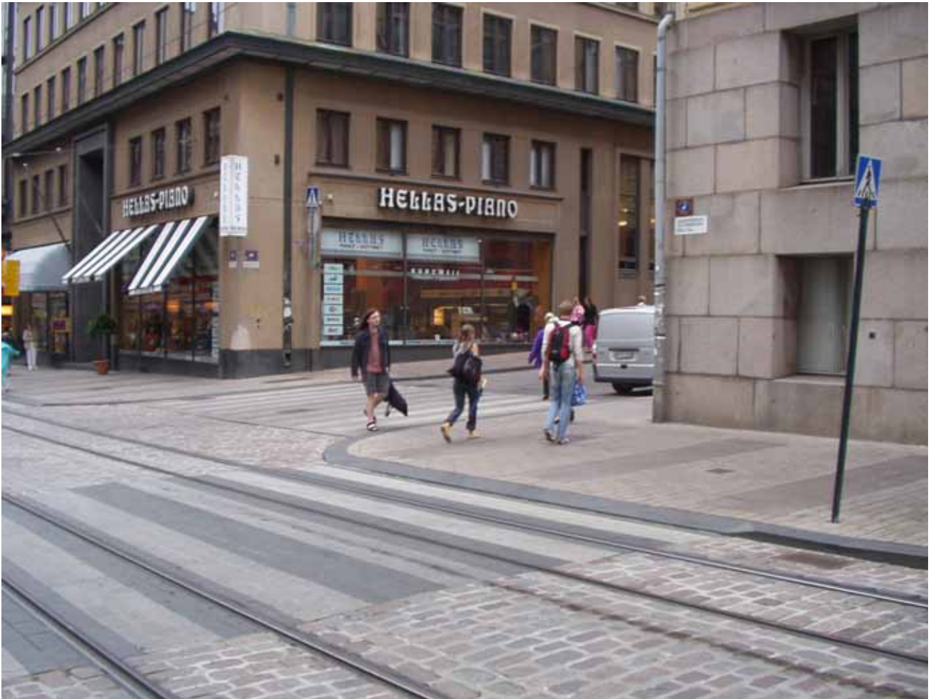
Kuvat 4. Helsingin Aleksanterinkadulla on käytetty erikoisreunakiviä, jotka ovat mitoitukseltaan ja asennustavaltaan lähellä SuRaKu-ohjetta, mutta luiskattu osuus on liian leveä (30 cm).
