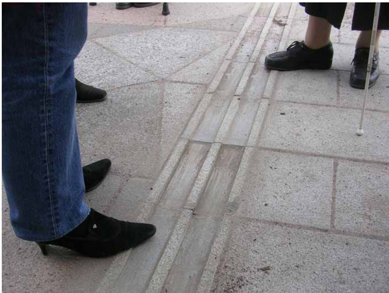
Kuva 51. Keskuskadun koeasennuksessa käytetty ohjausraita todettiin toimivaksi, mutta siihen toivottiin kontrastiväriä, tässä tapauksessa mustaa.
