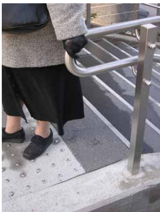
Kuva 48 - 49. Rajapaadenpolun portaat saivat testaustilaisuudessa erittäin positiivisen vastaanoton, vaikka portaiden liittäminen ympäristön päällysteisiin oli testaustilanteessa vielä kesken. Portaiden ala- ja yläpäissä on käytetty Suomen Graniittikeskuksen varoittavia graniittilaattoja.
