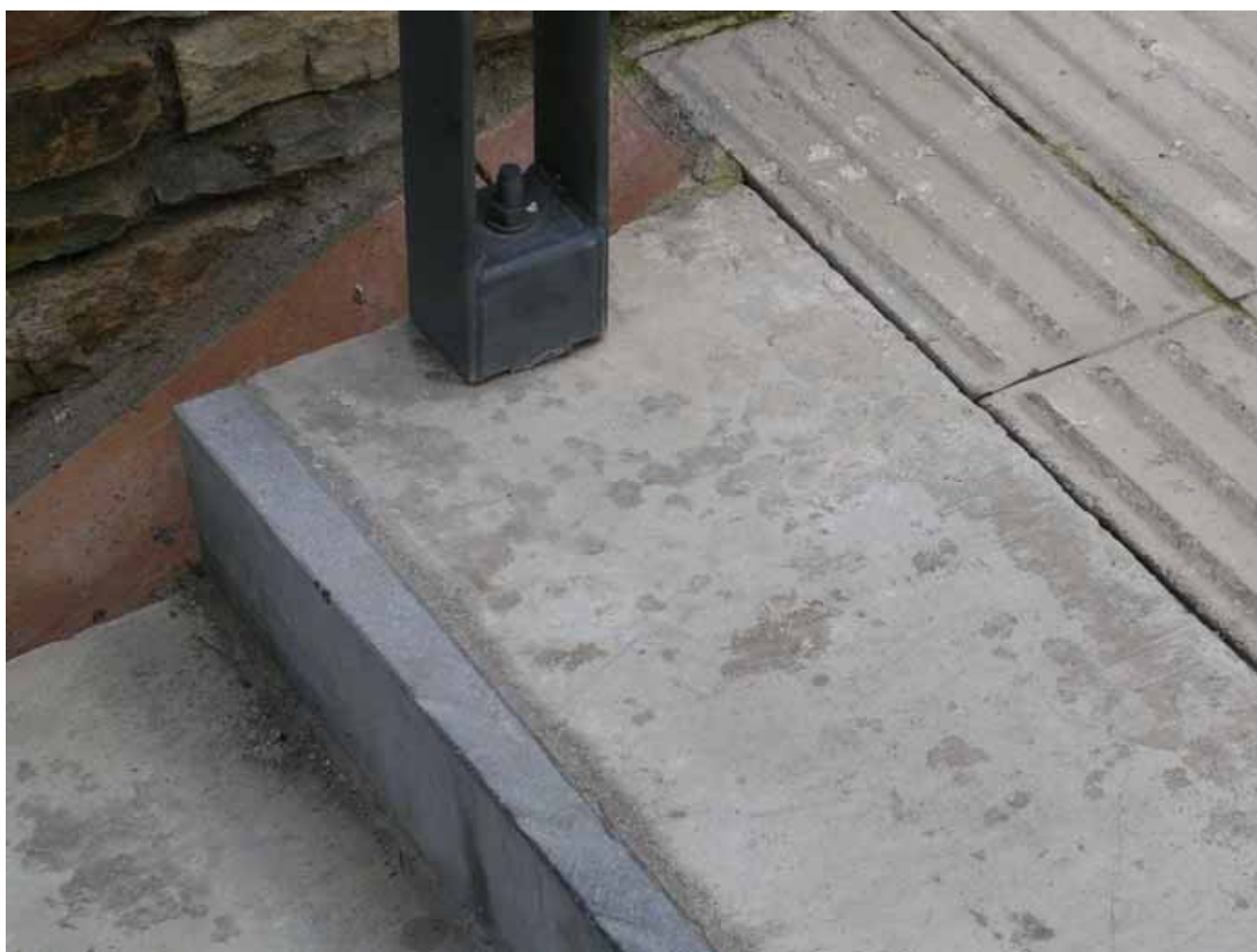
Kuva 27. Betonin huonon kestävyys takia portaiden reunassa on käytetty luonnonkivilevyä, joka mahdollistaisi myös kontrastivärin käytön. Portaan alussa on varoitusalue. Kuva Irlannista.
