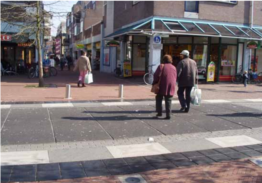
Kuva 20 – 21. Hollannissa suojateistä varoittavana materiaalina on käytetty mustia kumilaattoja, jois-sa joustava materiaali toimii jalalla tunnistettavana pintana. Lisäksi suojatien havaittavuutta on lisätty mustilla ja valkoisilla betonilaatoilla.
