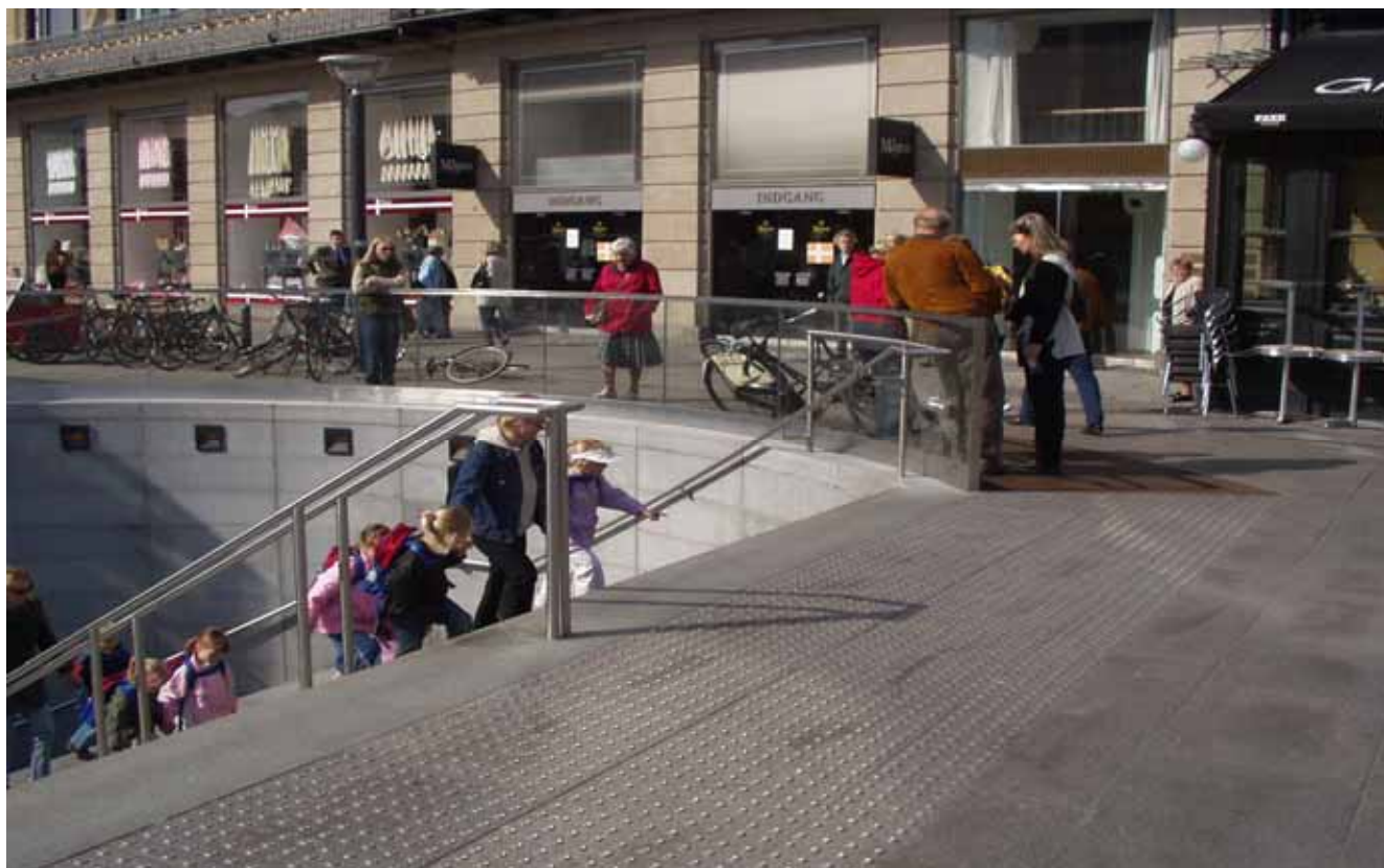
Kuva 12. Metallinastaan perustuvia luonnonkivisiä opaslaattoja on käytetty Kööpenhaminan metroasemien sisäänkäynneissä. Nastat on sijoitettu hyvin tiheästi, mikä on johtanut laatoituksen liukkauteen.
