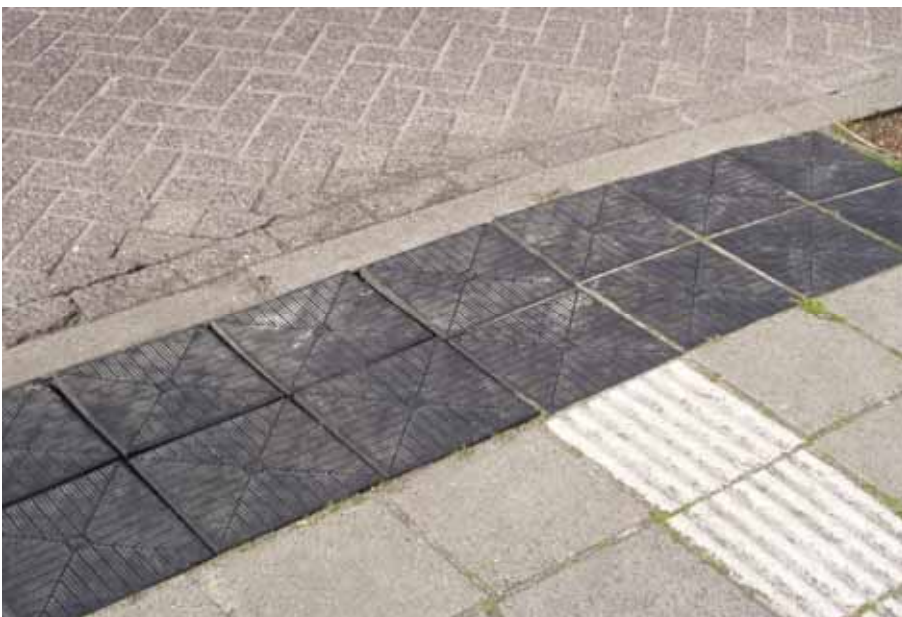
Kuva 20 – 21. Hollannissa suojateistä varoittavana materiaalina on käytetty mustia kumilaattoja, jois-sa joustava materiaali toimii jalalla tunnistettavana pintana. Lisäksi suojatien havaittavuutta on lisätty mustilla ja valkoisilla betonilaatoilla.
