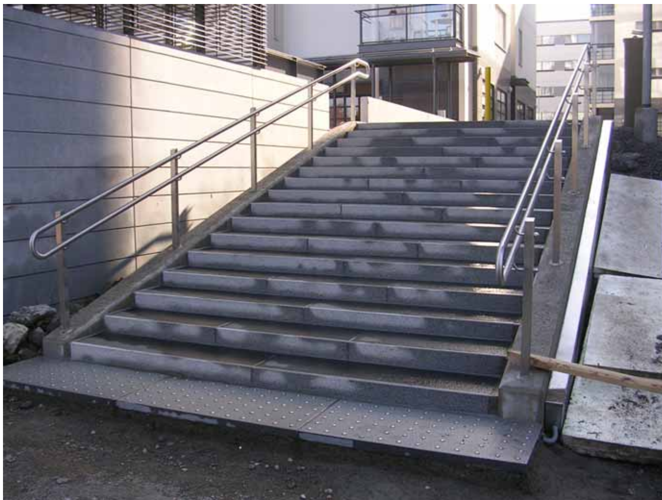
Kuva 48 - 49. Rajapaadenpolun portaat saivat testaustilaisuudessa erittäin positiivisen vastaanoton, vaikka portaiden liittäminen ympäristön päällysteisiin oli testaustilanteessa vielä kesken. Portaiden ala- ja yläpäissä on käytetty Suomen Graniittikeskuksen varoittavia graniittilaattoja.
