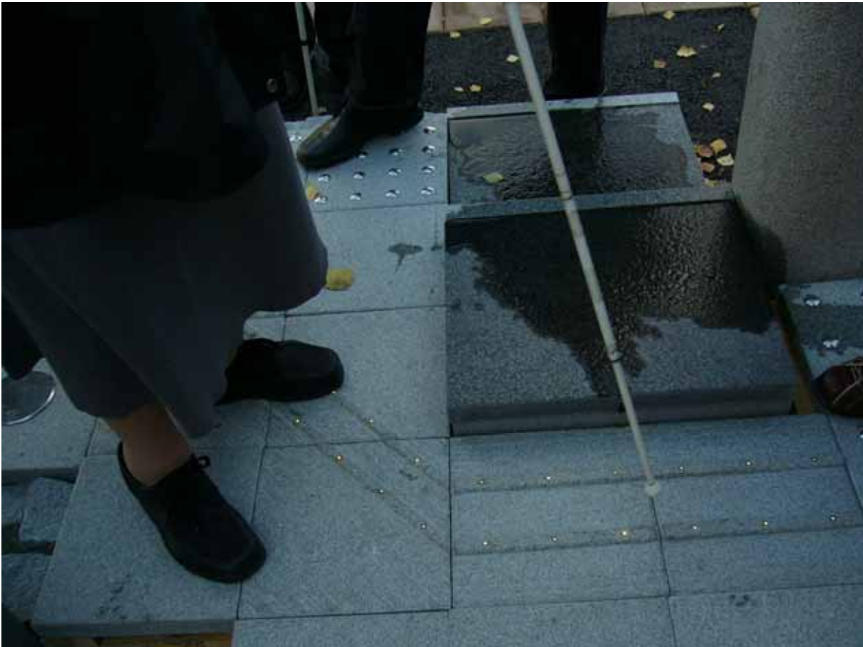
Kuva 13. Suomen Graniittikeskus Oy:n opaslaatoissa on mahdollisuus käyttää kuituvaloa niin, että valopisteet lisäävät kohokuvioiden havaittavuutta.
