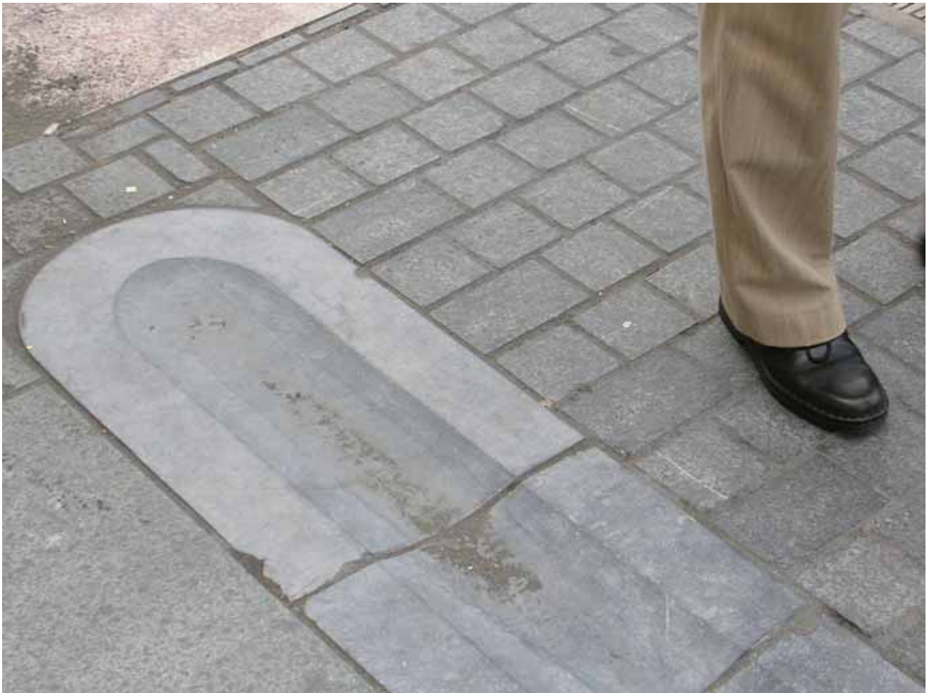
Kuva 28. Luonnonkivikourun pää on erityisen kauniisti muotoiltu, mutta itse kouru on muodoltaan sellainen, että pyörät juuttuvat siihen helposti. Kuva Irlannista.
