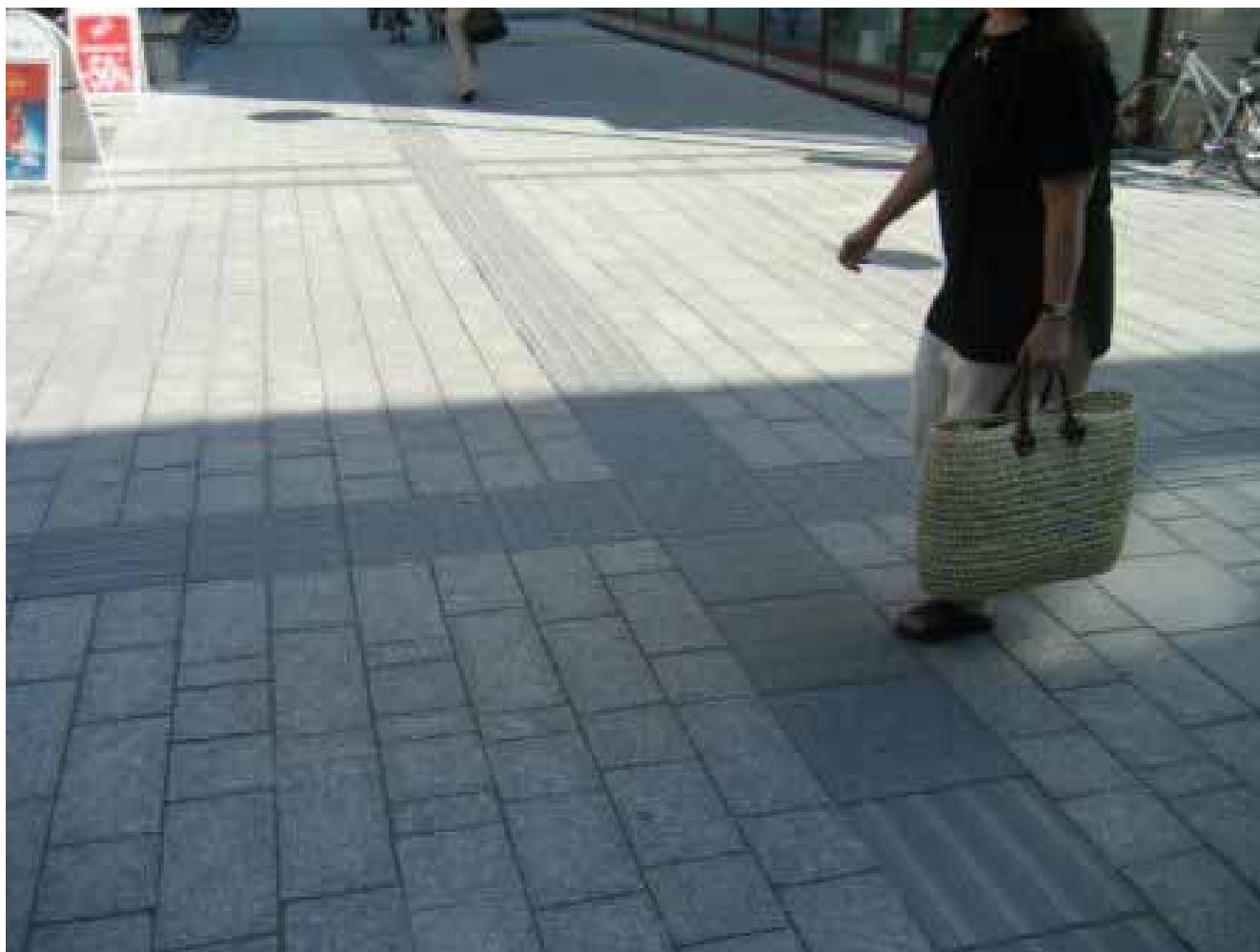
Kuvat 10 - 11. Tapiolan opaslaattarivit on toteutettu kohokuvioisilla graniittilaatoilla, joiden perusmitoitus vastaa SuRaKu-ohjeen vaatimuksia, mutta kohopisteet ovat pallopinnan sijasta sileäpintaisia neliöitä. Värikontrasti ympäröivään päällysteeseen on vähäinen.
