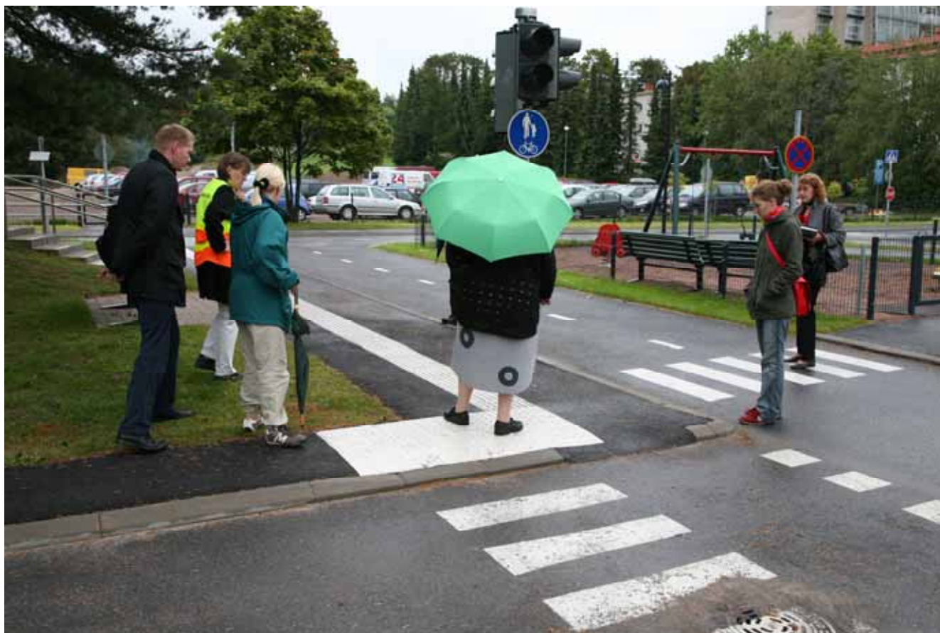
Kuva 22. Lasten liikennekaupungin Esteri-näyttelyalueelle on tehty koeasennus Tielinja Oy:n kohokuvioisista opastusmateriaaleista.
