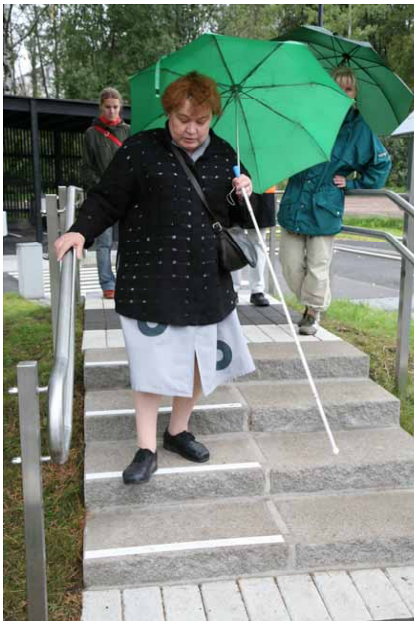
Kuva 41. Lemminkäinen Oyj:n betoniportaan prototyyppi on tehty vain osittain kontrastiraidalla, joka on toteutettu Tielinja Oy:n suojaatiemassalla.
