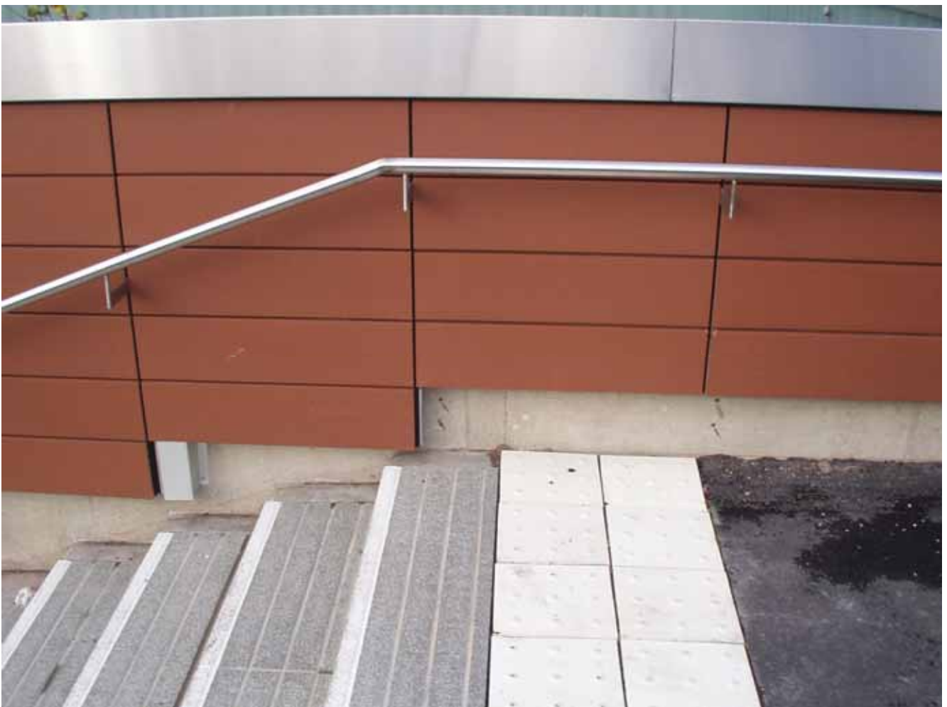
Kuva 23. Näkövammaisten Keskusliiton toimitalon lirixen pihalla luonnonkiviportaiden etureuna on maalattu valkoiseksi ensimmäiseen lämmityskaapelin uraan asti.
