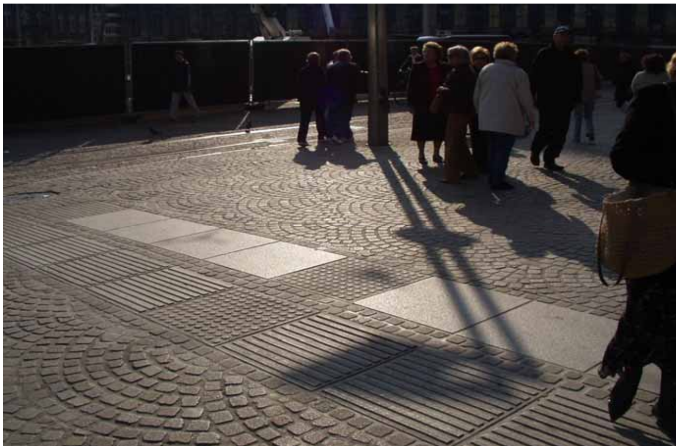
Kuva 9. Amsterdamin keskustassa käytetyn luonnonkivisen opaslaatan kohokuviot ovat selvästi tiheämpiä kuin SuRaKu-ohjeissa. Laattojen sijoitus karkealle kivipäällysteelle vaikeuttaa kohokuvioiden tunnistamista ja sileä laatta erottuu kuvioituja paremmin ympäröivistä päällysteistä.
