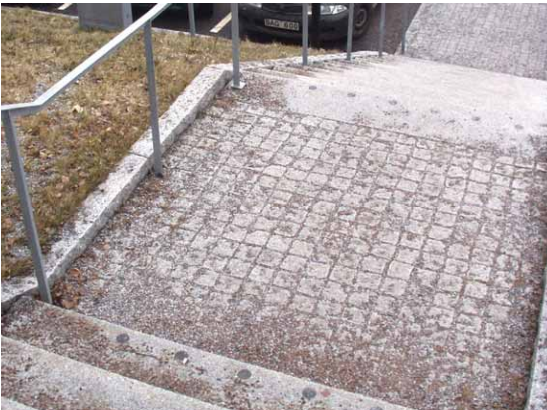
Kuva 26. Ruotsissa luonnonkiviportaiden reunamerkinnoissä käytetyt pallokuviot ovat osoittautuneet testeissä huonosti näkyviksi. Kuvassa hiekoitushiekka heikentää kuvioiden näkyvyyttä
