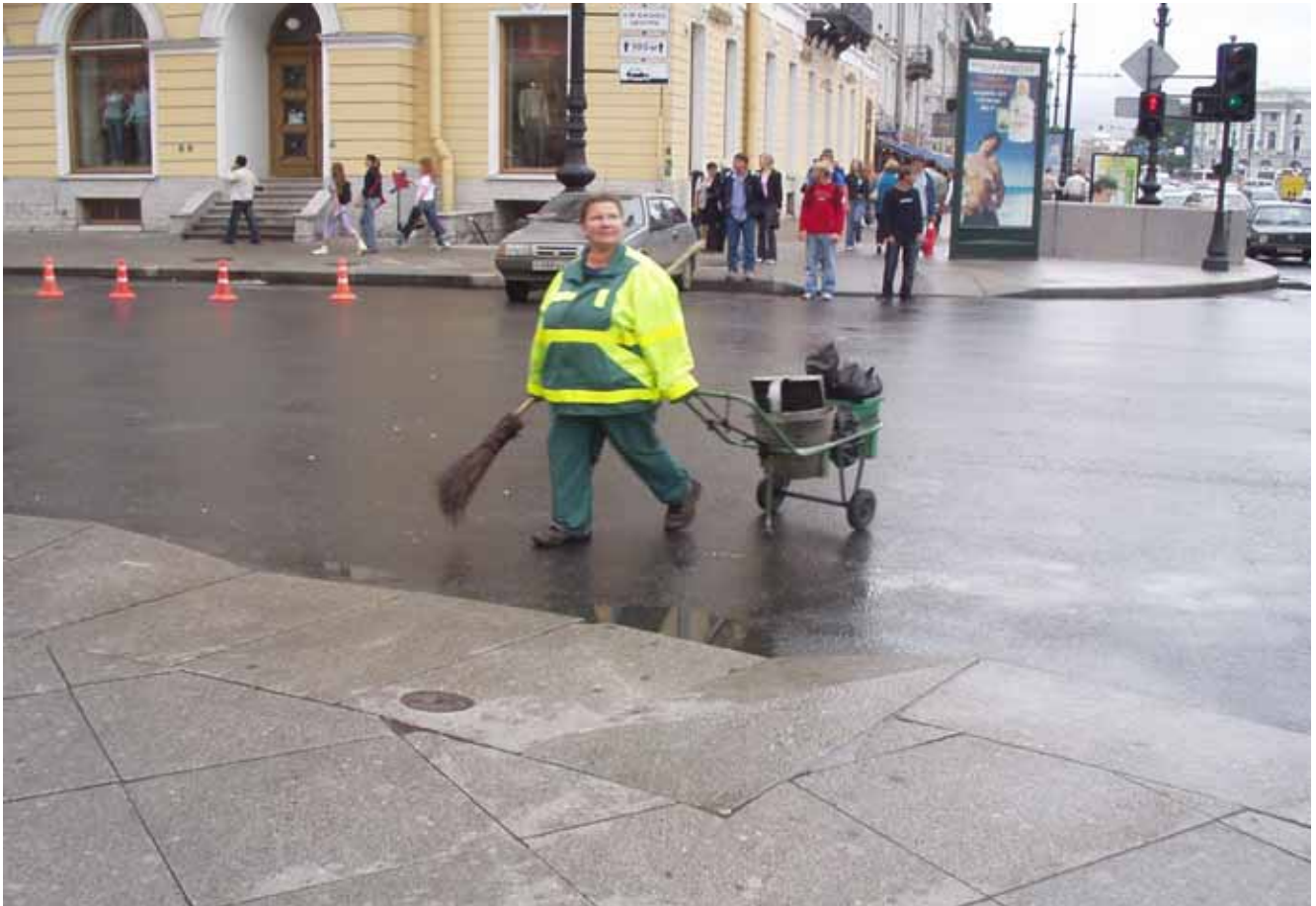
Kuva 5. Pietarin keskustan leveillä jalkakäytävillä luiskat (n. 5 %:n luiska + n. 3 cm:n suoraosuus) on toteutettu suurilla luonnonkivielementeillä, joiden koko on 70 x 140 cm. Suojatie on vaikeasti hahmotettava, koska ajoradalta puuttuvat suojatiemerkinnot eikä luiska ole kohtisuorassa suojatiehen nähden.
