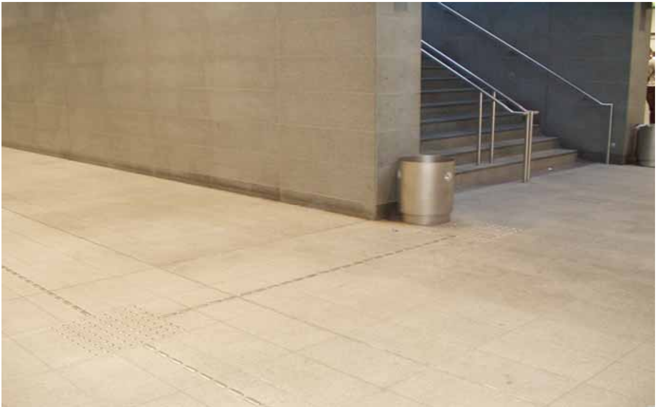
Kuva 17. Kööpenhaminan metroasemilla on käytetty samoja kohonastoja ja sauvoja kuin Kampin terminaalissa, mutta ne on asennettu tiheämmin kuin Kampissa. Opastustapa on vastaava.
