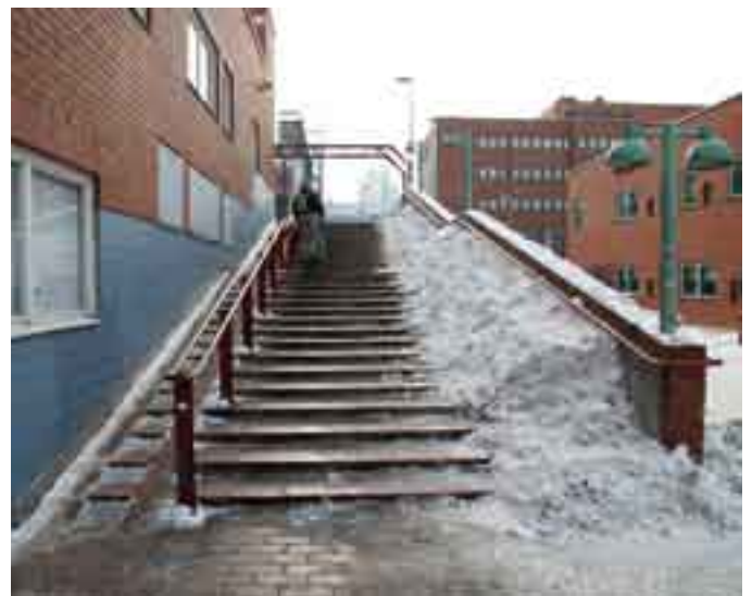
Kuva 39. Portaiden reunaan kasattu lumi estää käsijohteen käytön. Lastenvaunuluiska on erotettu käsijohteella eikä aiheuta kompastumisvaaraa portaissa. (Itäkeskus, Helsinki. Kuva: JH)
