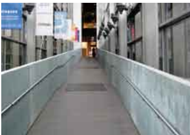
Kuva 4. Kuramatot haittaavat kulkemista luiskalla. (Kuva: AR)
