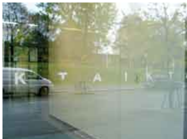
Kuva 2. Lasioven teksti ei ole riittävä toimiakseen kontrastimerkintänä. (Kuva: AR)
