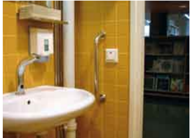
Kuva 22. Pesualtaan sijoitus hankaloittaa oven avaamista (Kuva: AR)
