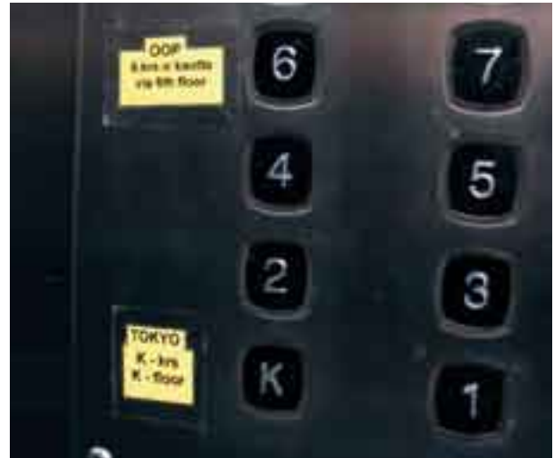
Kuva 16. Ohjauspaneeliin kerrospainikkeiden viereen lisätyt tekstit eivät erotu. (Kuva: AR)
