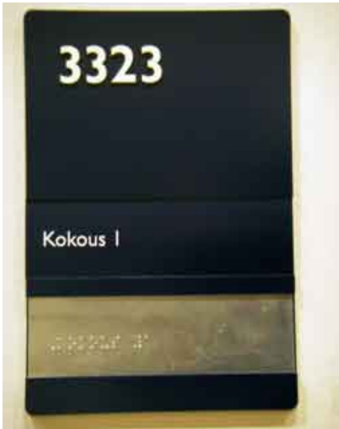
Kuva 22. Huoneopasteessa on kohonumero ja selkeä tummuuskontrasti, lisäksi informaatio on merkitty pistekirjoituksella. (Näkövammaisten palvelu- ja toimintakeskus Iiris, Helsinki. Kuva: JS)
