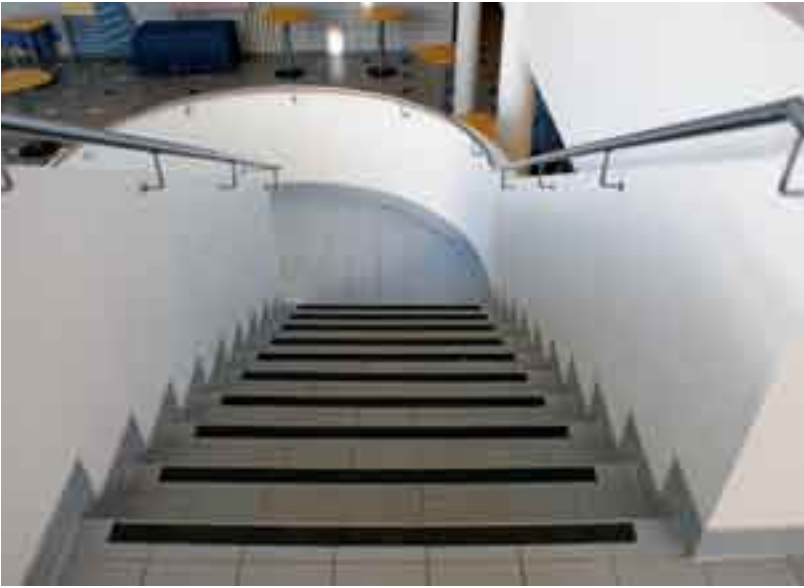
Kuva 61. Kontrastiraita porrasaskelman reunassa auttaa portaiden hahmottamisessa. Käsirohde on yhtenäinen ja jatkuu välitasanteella. (Valkea talo, Helsinki. Kuva: JS)
