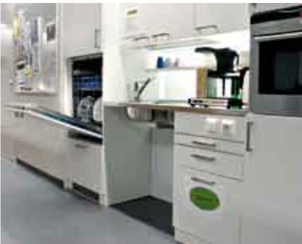
Kuva 78. Esteettömässä keittiöpisteessä tiskipöydän alla on vapaata polvitilaa, astianpesukone on täytettävissä kumartumatta ja jääkaappi on kahdella korkeudella. (Invalidiliiton esteetön toimitalo, Helsinki. Kuva: AR)
