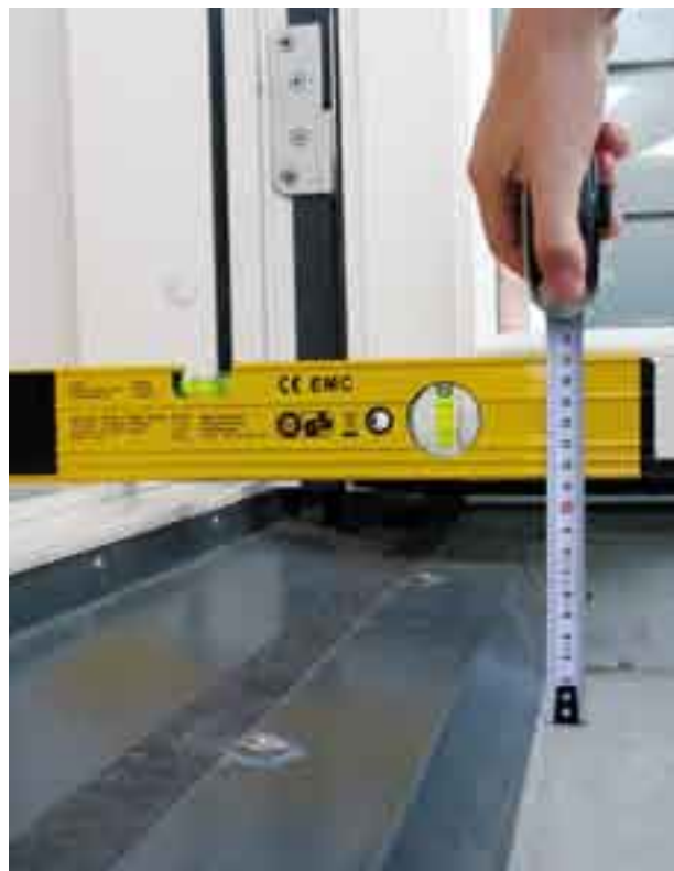
Kuva 57. Kynnyksen korkeuden mittaaminen sujuu helposti kaltevuusmitan avulla. (Kuva: AR)
