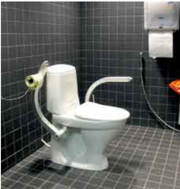
Kuva 21. Wc-istuimen käsituet eivät ole tarpeeksi tukevat. (Kuva: AR)
