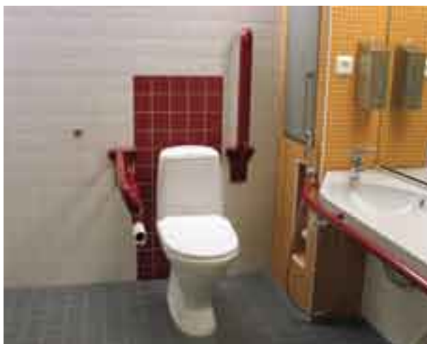
Kuva 79. Esteetön wc-tila voi muodostua myös kahdesta ns. peilikuva-wc:stä, joissa vapaata tilaa on vain joko wc-istuimen vasemmalla tai oikealla puolella. (Invalidiliiton esteetön toimitalo, Helsinki. Kuva: AR)
