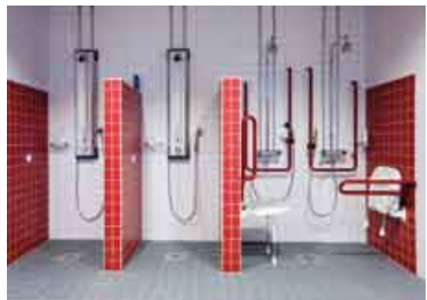
Kuva 83. Esteettömässä suihkupaikassa on sekä automaattisesti toimiva suihku että käsisuihku, käsituilla varustettu, sekä vasen- että oikeakätisesti käytettävissä oleva suihkuistuun ja tarvittavat tukikaiteet. (Invalidiliiton esteetön toimitalo, Helsinki. Kuva: TP)
