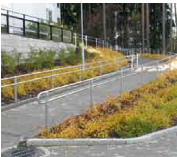
Kuva 41. Rinteessä sijaitseva kulkureitti on varustettu käsijohteilla ja levähdyspaikalla. (Vuosaari, Helsinki. Kuva: AR)
