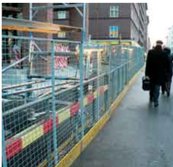
Kuva 51. Ohjaava työmaan suoja-aita. (Kuva: AJ)
