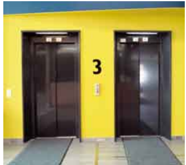
Kuva 67. Hissin ovet erottuvat selkeästi seinästä. Lisäksi matot ohjaavat oville ja kerrosmerkintä on selkeä. (Näkövammaisten palvelu- ja toimintakeskus Iiris, Helsinki. Kuva: JS)
