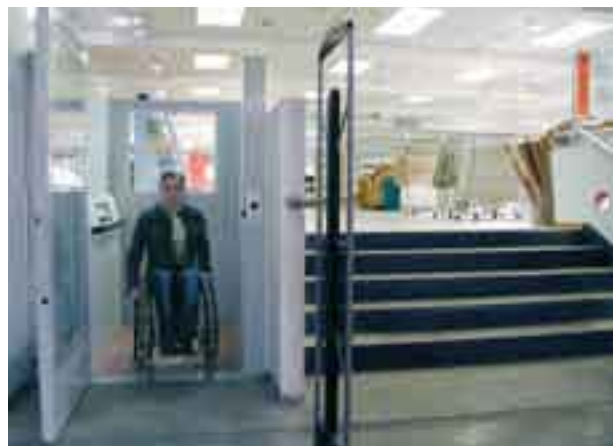
Kuva 69. Esteetön kulkuyhteys kerrostasanteelta toiselle on järjestetty pystyhissillä. (Stockmann, Helsinki. Kuva: JH)
