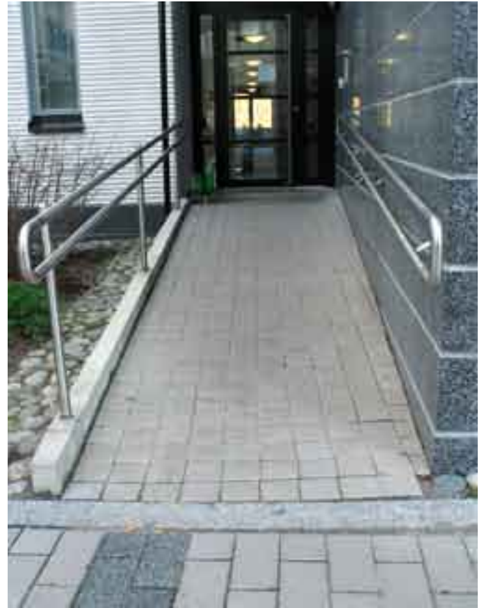
Kuva 37. Sisäänkäynnin yhteydessä oleva luiska johtaa tasanteelta tasanteelle. Luiskassa on molemminpuoliset käsijohteet sekä suojareuna. Toiselta puolelta luiska rajoittuu seinään. (Palvelutalo Cecilia, Helsinki. Kuva: AR)
