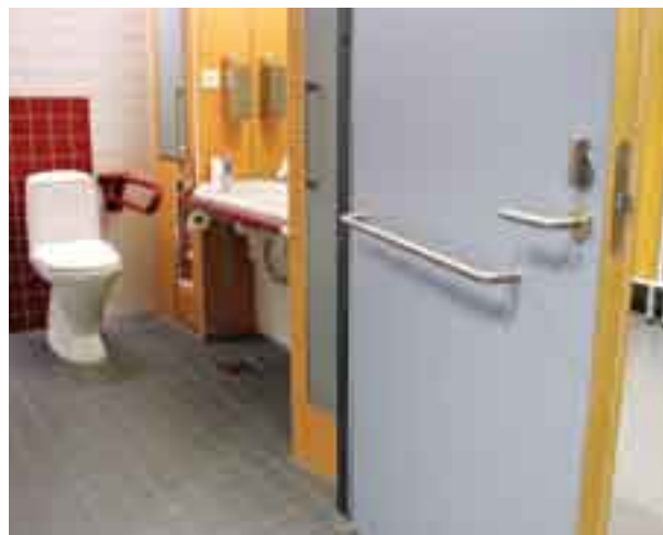
Kuva 81. Vaakasuuntainen lankavedin ovesa mahdollistaa oven kiinni vetämisen pyörätuolista käsin. (Invalidiliiton esteetön toimitalo, Helsinki. Kuva: AR)
