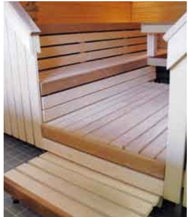
Kuva 85. Saunan lauteiden ja lauteille johtavien portaiden hahmottumista auttaa tummuuskontrastina erottuva reunalauta. (Lomakoti Haapalahti, Eno. Kuva: AR)
