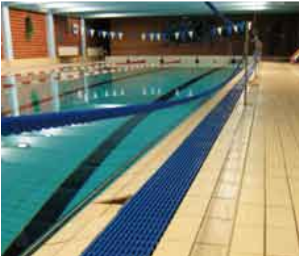
Kuva 87. Uima-altaan loiskekourun ritilä toimii varoittavana reunamerkintänä. (Jakomäen uimahalli, Helsinki. Kuva: AR)
