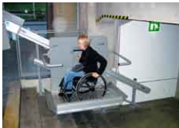
Kuva 70. Tätä porrashissiä voi käyttää itsenäisesti. Kuvan hississä vapaa korkeus jää kuitenkin alle vaaditun ja törmäysvaarasta varoitetaan huomioteippauksella. (Taideteollinen korkeakoulu, Helsinki. Kuva: JS)
