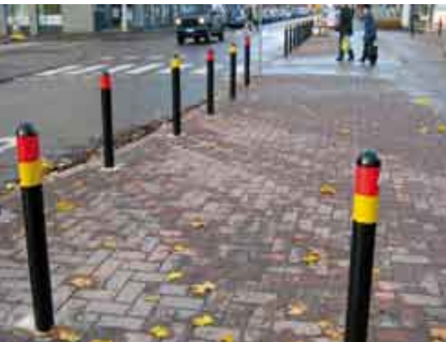
Kuva 35. Pollarit sijaitsevat kulkuväylästä poikkeavalla pintamateriaalilla, erottuvat tummuuskontrastina taustasta ja niissä on lisäksi heijastava huomioraita. (Herttoniemenranta, Helsinki. Kuva: AR)
