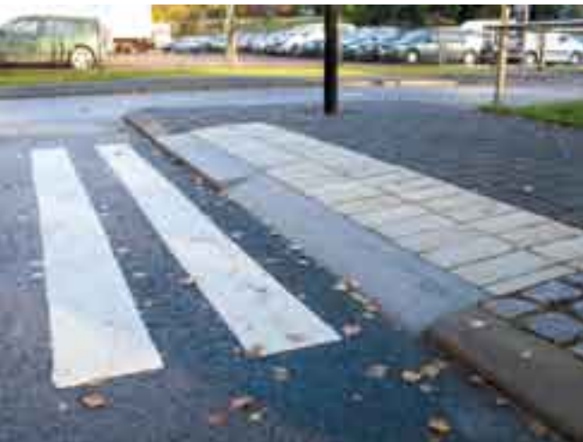
Kuva 34. Luiskareunatuki, pystysuora reunatuki ja varoitusalue suojatien alussa sekä massauksella tehdyt, hyvin erottuvat suojatiemerkinnot. (Esteettömyystuotteiden näyttelyalue Esteri, Lasten liikennekaupunki, Helsinki. Kuva: AR)
