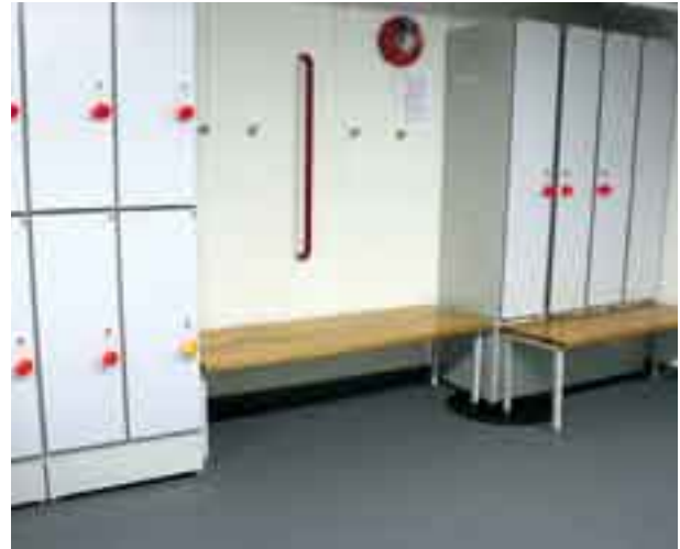
Kuva 82. Esteettömässä pukeutumistilassa vaatekaappien ääreen pääsee myös pyörätuolilla, sillä niiden edessä ei ole kiinteitä penkkejä. Tarvittaessa tukea voi ottaa pystytuesta tai nojaamalla kaapistoon. (Invalidiliiton esteetön toimitalo, Helsinki. Kuva: AR)
