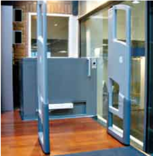
Kuva 30. Pystyhissin edessä ei ole tarpeeksi vapaita tilaa. (Kuva: AR)
