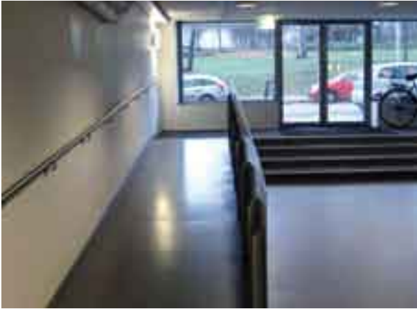
Kuva 6. Sisäänkäynnin jälkeen on luiska ja muutama porraskelma. (Kuva: AR)
