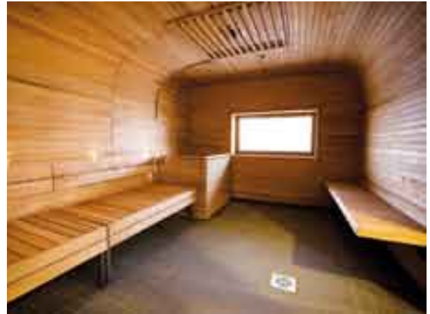
Kuva 84. Esteettömässä saunassa lauteina ovat penkit. Löylyn lämpö saadaan ulottumaan jaloille kiertoilmapuhaltimen avulla. (Invalidiliiton esteetön toimitalo, Helsinki. Kuva: TP)
