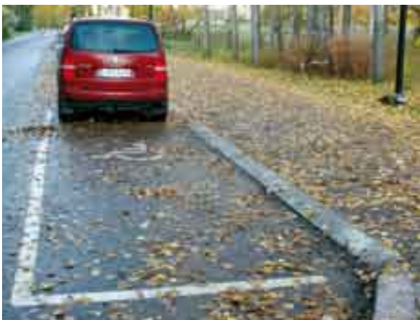
Kuva 40. Luiskareunatuki mahdollistaa turvallisen siirtymisen liikkumisesteisen pysäköintipaikalta jalkakäytävälle. (Ratsastie, Helsinki. Kuva: JS).
