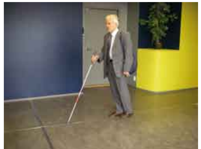
Kuva 28. Jatkuvaa metallilistaa on helppo seurata valkoisella kepillä. (Näkövammaisten palvelu- ja toimintakeskus Iiris, Helsinki. Kuva: JS)
