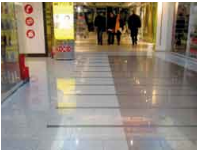
Kuva 27. Voimakkaat kuvioinnit ja kiiltävä lattia tekevät liikkumisesta epävarmaa. (City-käytävä, Helsinki. Kuva: AR)
