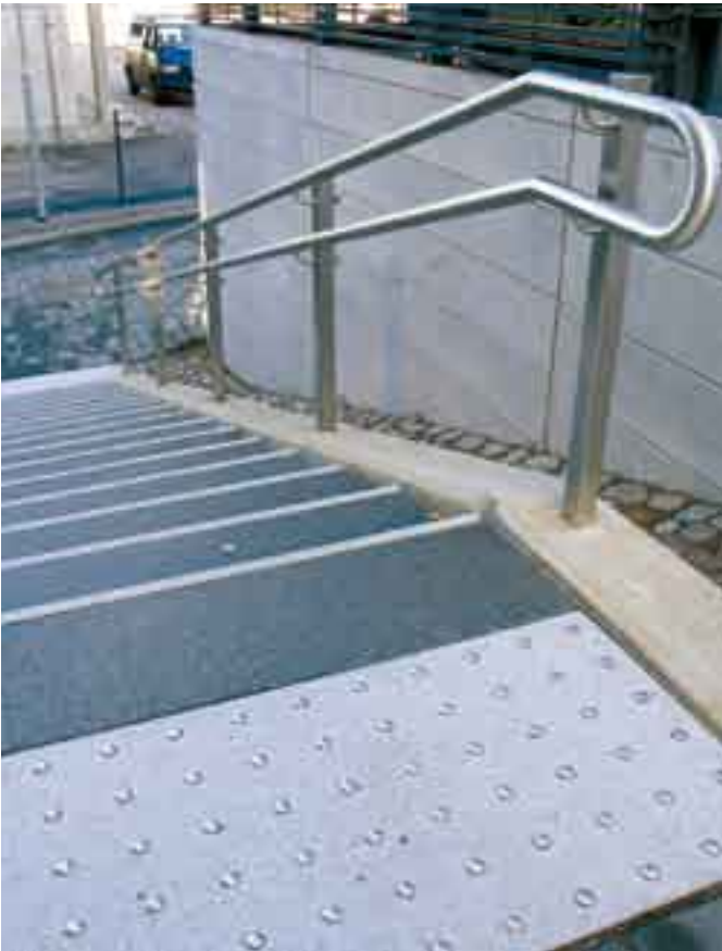
Kuva 36. Erikoistason esteettömissä ulkoportaissa on varoitusalue ennen portaita, selkeät kontrastiraidat askelmien etureunoissa ja oikein mitoitettu käsijohde. (Esteettömien ympäristötuotteiden kehityshankkeen (ELSATUOTE) koekohde, Rajapaadenpolun luonnonkiviportaat, Vuosaari, Helsinki. Kuva: AR)
