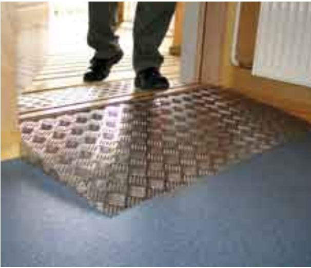
Kuva 55. Sisäänkäynti voidaan korjata esteettömäksi luiskaamalla korkea kynnyks. Kynnysluiskan tulee olla tukeva ja tarpeeksi loiva. (Kuva: AR)
