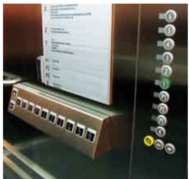
Kuva 68. Hissin vaakasuoja ja pystysuoja ohjauspaneeli mahdollistavat kerrospainikkeen painamisen eri korkeuksilta. (Invalidiliiton esteettömät toimitilat, Helsinki. Kuva: AR)
