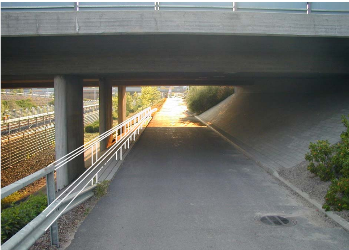
Kuva 7.4 Kaiteen jatkaminen sillan alle poistaa kovapintaiseen jyrkkään luiskaan liittyvän vahinkoriskin.
