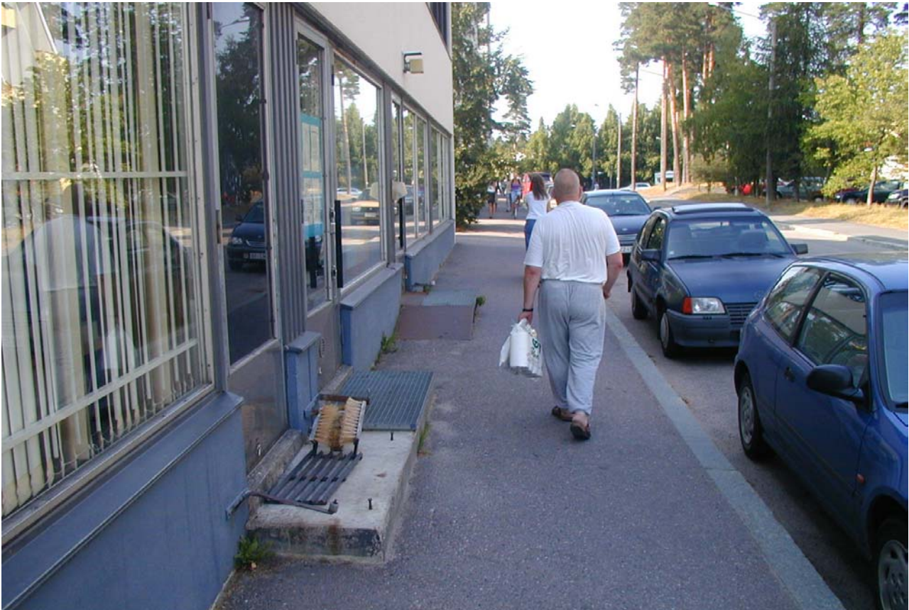
Kuva 7.2 Ulappasaarentien esteettömyyden parantaminen vaatii samanaikaisesti toteutettavia toimenpiteitä sekä rakennuksissa että kadulla.
