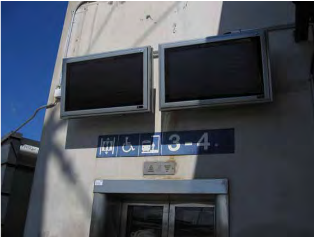
Kuva 16. Bussiterminaalien tasolla hissien oven yläpuolella sijaitsevat junien aikatauluopasteet ovat liian korkealla. Myös auringon häikäisy haittaa lukemista.
