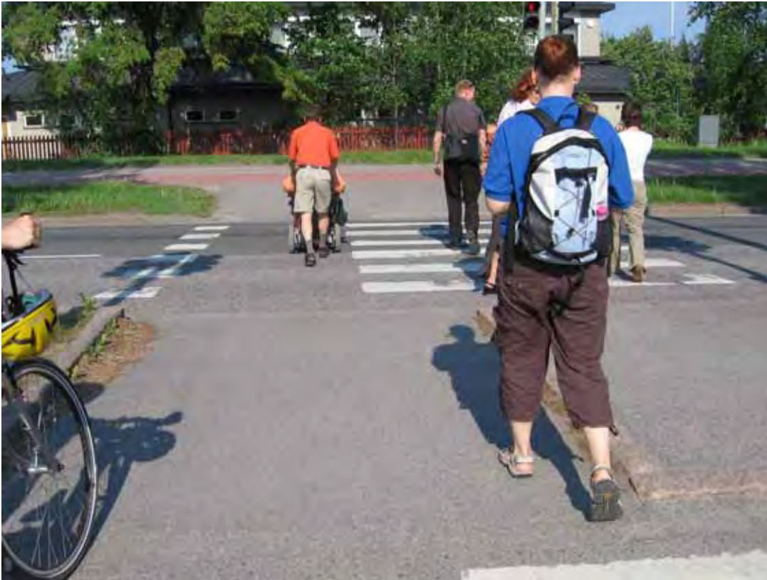
Kuva 20. Kirkonkyläntien suojateissa on matalat reunakivet jalankulkijoiden väylillä, mikä helpottaa näkövammaisen ajoradan reunan tunnistamista. Rollaattoria tai pyörätuolia käyttäville on reunaki-vetön ylityslinja.
