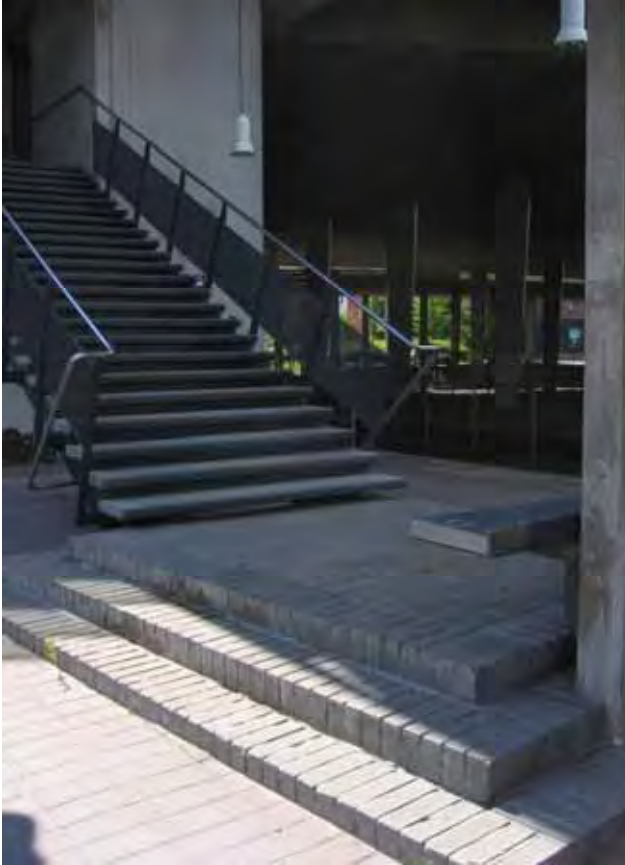
Kuvat 17 ja 18. Arkkitehtonisesti persoonalliset portaat ovat hankalat ja vaaralliset näkövammaiselle tai huonon tasapainon omaavalle. Laiturin reunan kontrastivyoöhyke ei erotu riittävästi.
