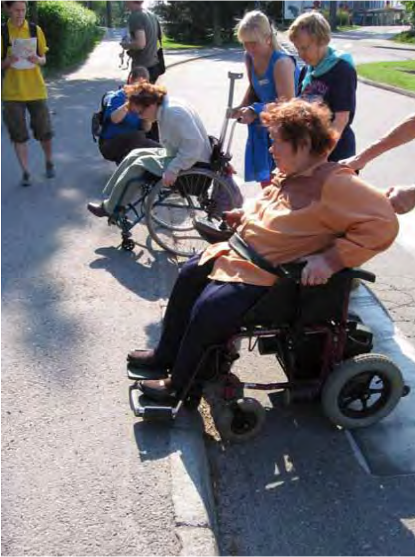
Kuva 22. Malmin sairaalakadulla terveysaseman kohdalla sijaitsevan suojatien korkeat reunakivet aiheuttavat ongelman rollaattorin ja pyörätuolin käyttäjälle. Ylä-Malmin toimenpidekartan kohta 9.
