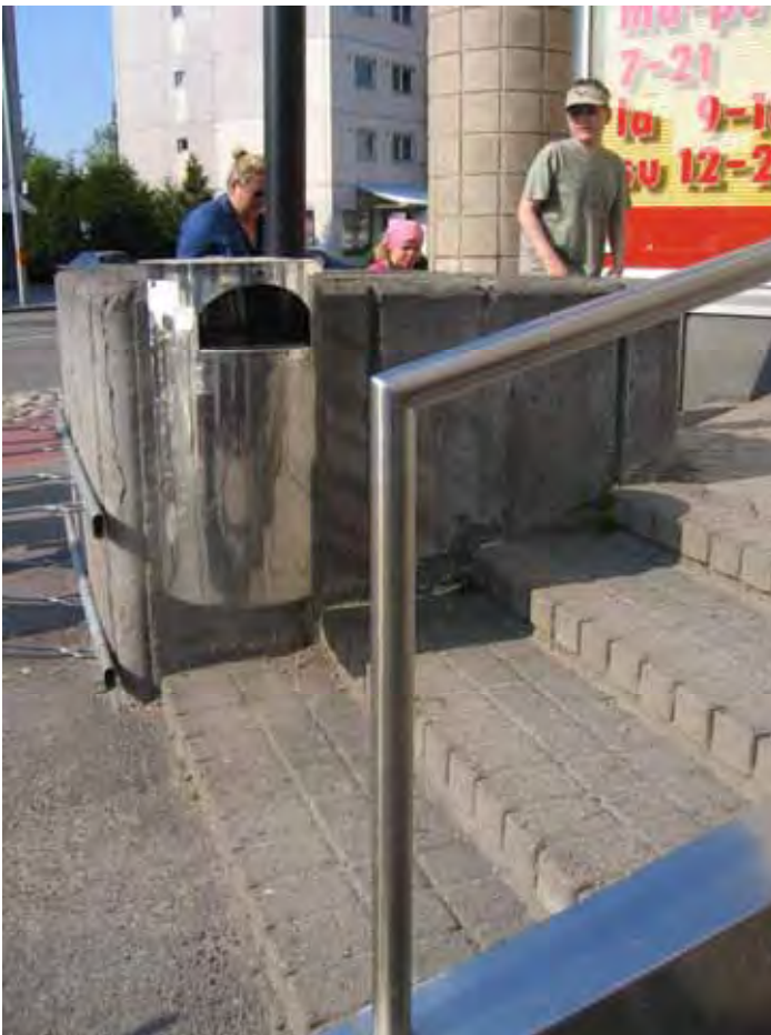
Kuva 31. Heikkonäköinen tai sokea kulkija törmää helposti portaaseen sijoitettuun roska-astiaan ja rikkiineseen pyörätelineeseen. Malmin keskustan toimenpidekartan kohta 12.
