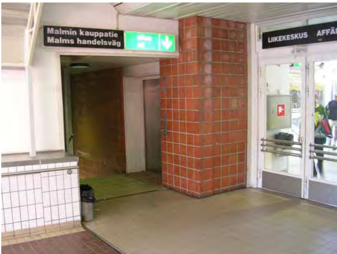
Kuva 12. Hissi radan ylikulkusillalta pohjoispuolen osaan Malmin liikekeskusta on toimiva. Porasyhteys Malmin kauppatielle alkaa kuitenkin vaarallisen läheltä hissien oviaukkoa.
