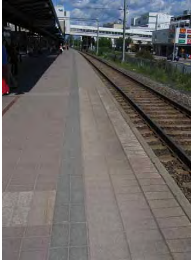
Kuvat 17 ja 18. Arkkitehtonisesti persoonalliset portaat ovat hankalat ja vaaralliset näkövammaiselle tai huonon tasapainon omaavalle. Laiturin reunan kontrastivyoöhyke ei erotu riittävästi.
