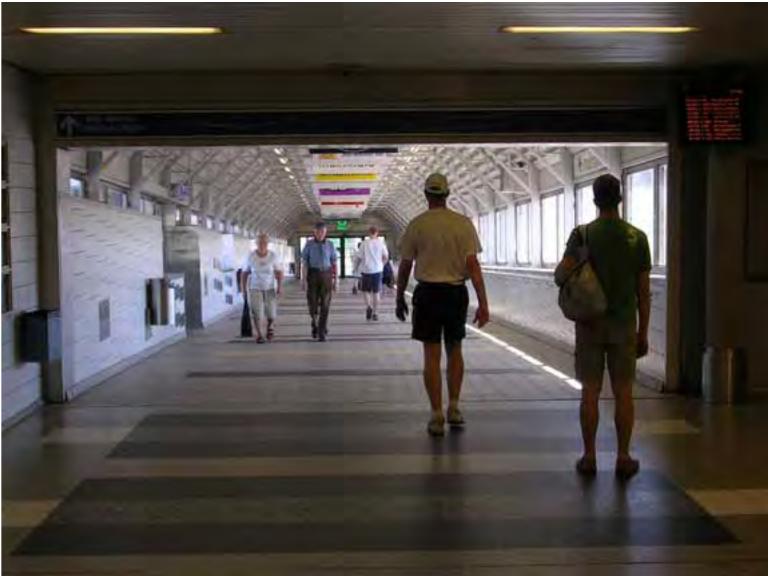
Kuva 14. Radan ylittävän käytävän laatoitus on vaihdettu vähemmän liukkaaseen. Näkövammaisen voi luulla kulkupinnan voimakkaita raitoja porrasaskelmaksi, mikä aiheuttaa vaaratilanteen.
