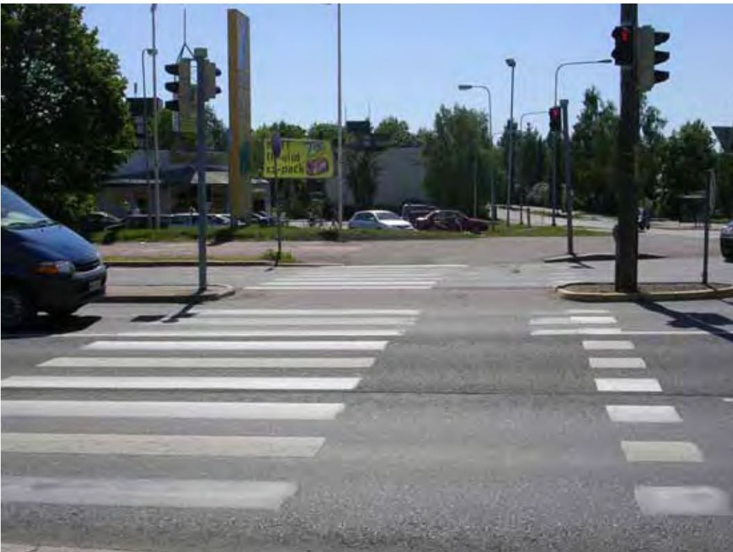
Kuva 35. Esteettömän ympäristön suunnitteluohjeiden mukaisten reunatukien asentaminen helpottaa sokean ja heikkonäköisen kadunylitystä Kirkonkyläntien ylittävällä suojatiellä Laulurastaantie kohdalla. Ylä-Malmin toimenpidekartan kohta 2.
