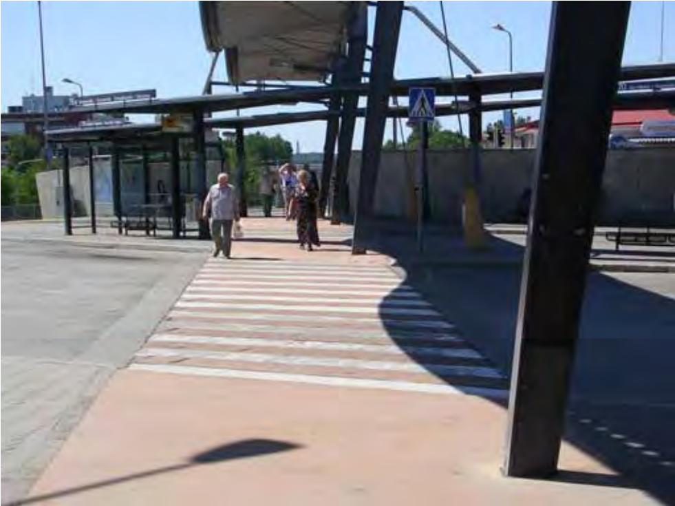
Kuva 29. Bussiterminaalien suojatiejaksoilta on korkeat luiskanosut laiturialueille, mitkä aiheuttavat kaatumisvaaran useille pyörätuolinkäyttäjille. Myös se, etteivät suojatiemaalauksen raidat ole koh-tisuorassa ylityssuuntaan nähden, aiheuttaa suunnanotto-ongelman sokealle kulkijalle. Suojatien reunan merkitseminen kontrastiraidalla auttaa suunnan säilyttämistä. Bussiterminaalien yksityiskoh-taisten toimenpiteiden määrittäminen edellyttää kaupunkisuunnitteluviraston liikennesuunnittelua ja kokonaisuuden kaupunkikuvallista tarkastelua. Malmin keskustan toimenpidekartan kohta 10.
