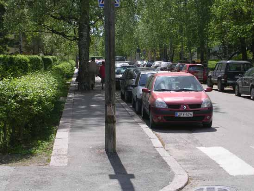
Kuva 21. Otavantien ja Kauppaneuvoksentien risteyksessä suojatien kohdalla sijaitseva valaisinpylväs pitää siirtää jalkakäytävän reunaan. Toimenpiteen toteuttaminen kuuluu Helsingin energialle. Toimenpidekartan kohta 3.
