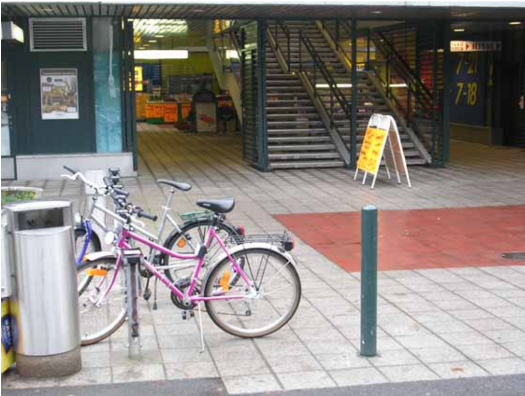
Kuva 23. Lauttasaaren ostoskeskuksen pyöräpysäköintialueenpinnoite tulisi vaihtaa ja portaiden alle käveleminen tulisi estää.
