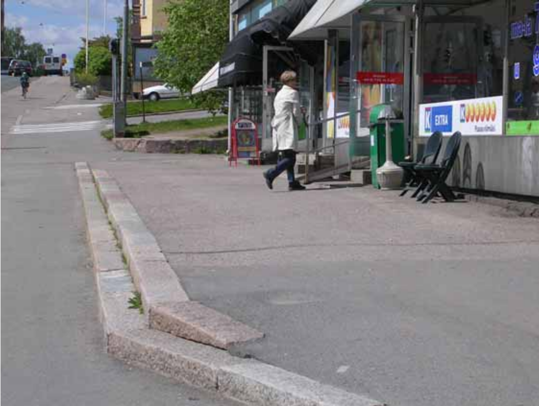
Kuva 25. Lauttasaarentie 5:n kohdalla sijaitsevaan porrastasanteeseen pitää lisätä vaalea vyöhyke esim. lohkopintaisista noppakivistä varoittamaan heikkonäköisiä tasoerosta. Toimenpidekartan kohta 8.
