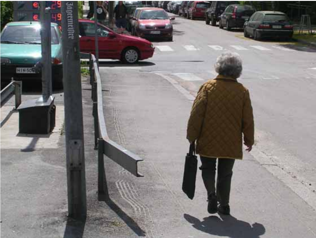
Kuva 26. Vaarallisesti törröttävä kaiteenpää Otavantiellä pitää leikata. Toimenpidekartan kohta 12.
