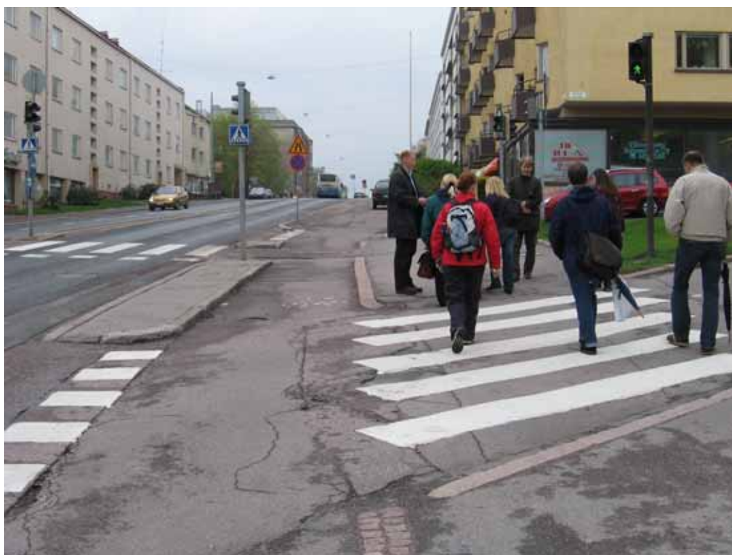
Kuva 8. Kläärantien liittymän kohdalla suojaitemaalaukset ovat vinossa jalankulkijan kulkusuuntaan nähden, mikä vaikeuttaa opaskoiran ylityssuunnan tunnistamista. Pyörätien ja jalankulun erottavaa noppakiviraitaa tulee jatkaa myös suojaite kohdalla, jolloin sitä voi käyttää valkoisella kepillä suunnan säilyttämiseen. Kiviraita tulee kuitenkin katkaista selvästi reunakivellä ajoradan reunassa. Toimenpidekartan kohta 7.
