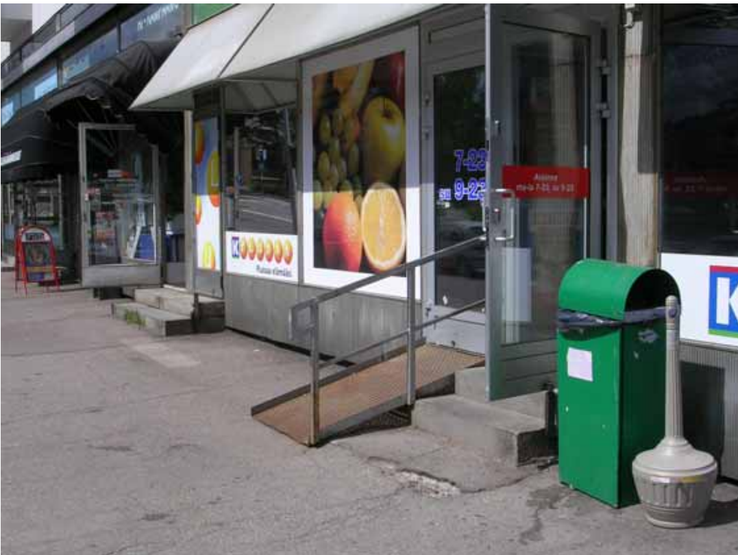
Kuva 12. Liike- ja asuintalossa osoitteessa Lauttasaarentie 5 on mm. vanhustentalon asukkaiden paljon käyttämä lähikauppa. Kiinteistöjen sisäänkäyntien portaita on kuitenkin erittäin vaikea poistaa, koska kadun tasausta ei voi nostaa tarvittavaa määrää.
