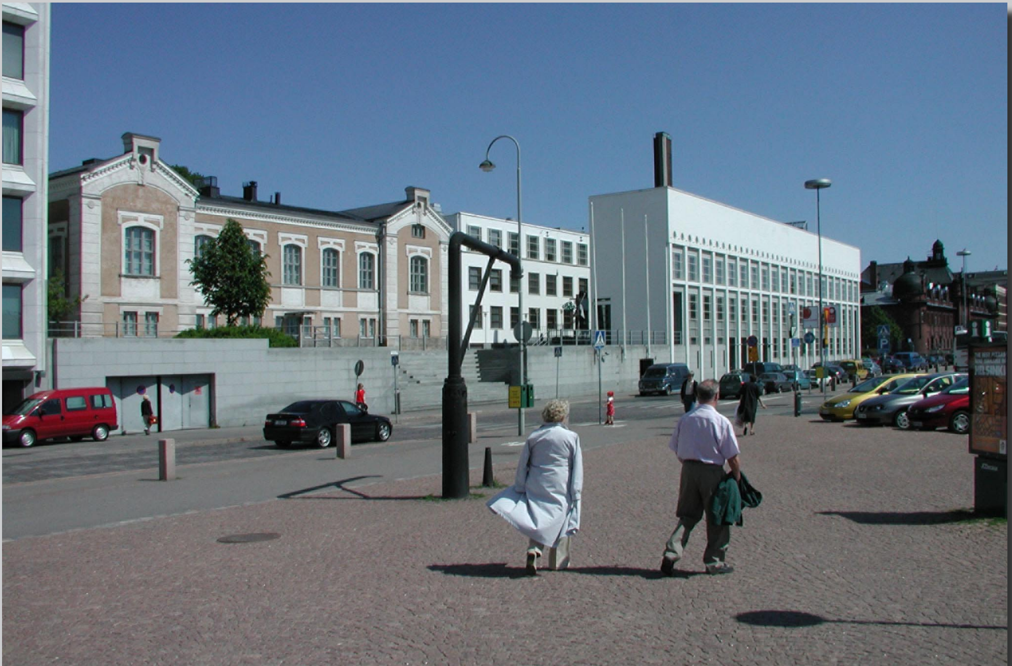
Rahapaja vuodelta 1864, arkkitehti August Boman. Etualalla muisto satamaradasta, höyryveturin vesiposti. Oikealla ulkoasiainministeriön virastorakennus vuodelta 1993, Olli Pekka Jokela. Sen suunnittelua on pitkälti ohjannut Aallon Enson konttorissa aloittama valkoinen, uusklassismiin viittaava julkisivujen käsittely.
