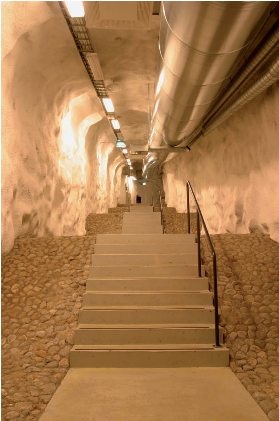
Kuva 20. Kampin työtukikohdan jalankulkuyhteys
