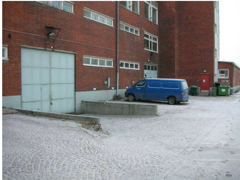
Kuva 1. Yleiskuva piha-alueesta rakennuksen länsisivusta.
