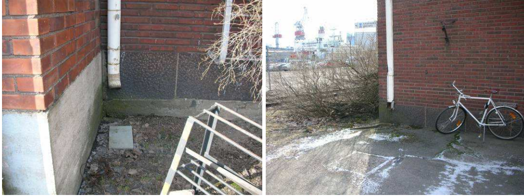
Kuvat 2 ja 3. Kattovedet johdetaan syöksytorvilla rakennuksen vierustalle ja valtaosa vesistä imeytyy maaperään eikä ohjaudu rakennuksen vierustalta pois. Rakennuksen pohjoispäädyssä syöksytorvet on upotettu tiilimuuraukseen.
