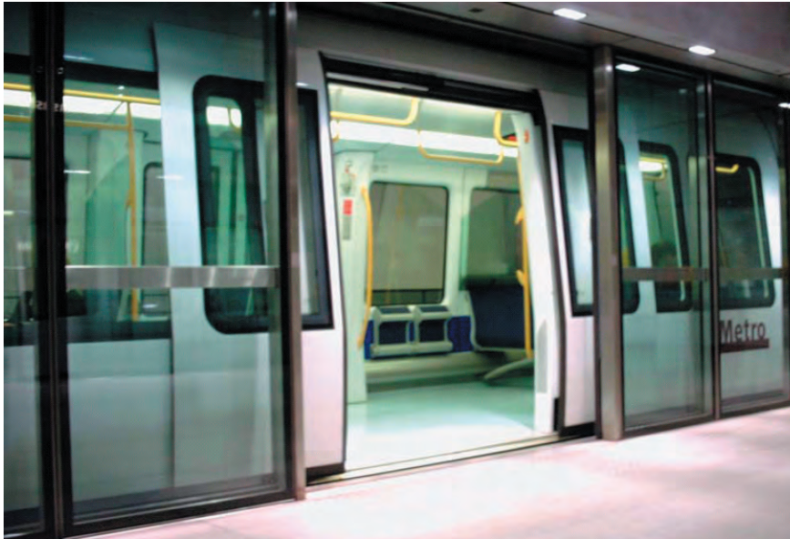
Kööpenhaminan maanalainen metroasema ja auki liukuvat turvaovet. (Kuva: Kerkko Vanhanen, WSP LT-Konsultit Oy)
