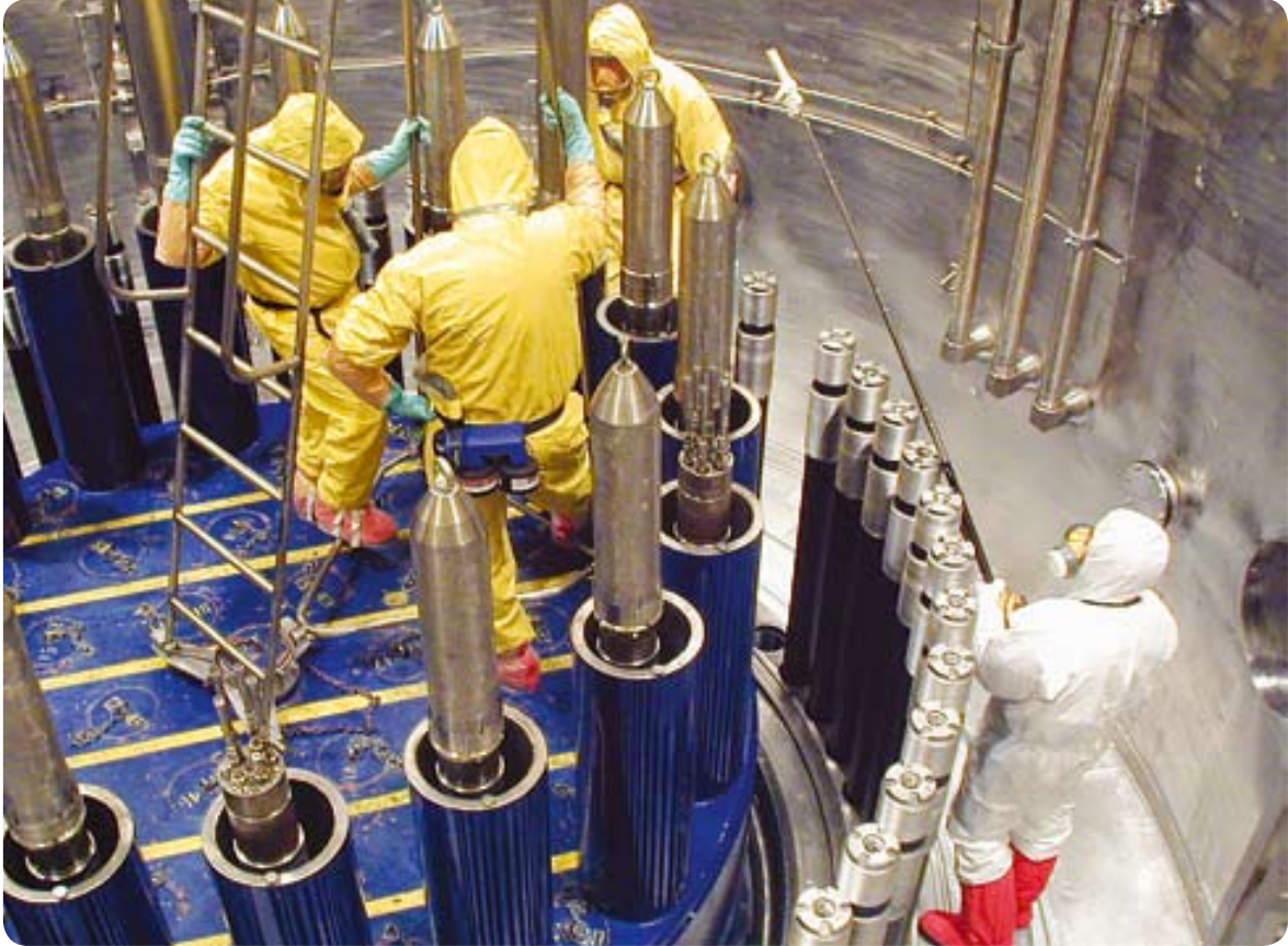
Vuosittaisessa polttoaineenvaihtoseisokissa tehtävillä huolto- ja korjaustöillä varmistetaan voimalaitoksen turvallisuus tulevalle käyttöjaksolle.
