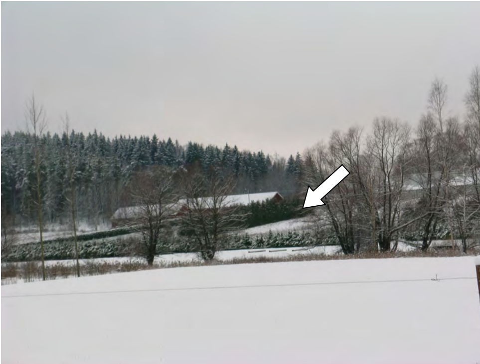
Rakennuspaikka on kasvihuoneiden ja harjakattoisten puurakennusten välissä. Kuva on otettu etelästä Nuuksion kansallispuiston suunnasta.
