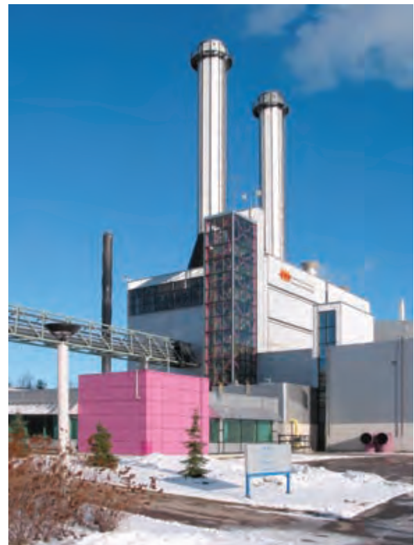
Vuosaaren A-voimalaitos Kuva: Helsingin Energia
