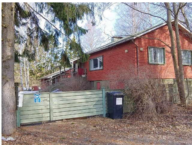
Kuva: Markkinatie 27:n rakennukset kuvattuna Markkinatien puolelta. Etualalla 1964 valmistunut asuinrakennus.
