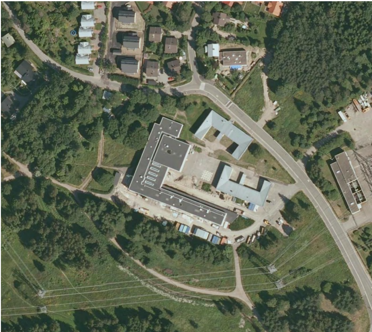
Ilmakuva tontista vuonna 2008 peruskorjauksen aikana. Pihatilat ovat työmaakäytössä. Kuva: Helsingin karttapalvelu.
