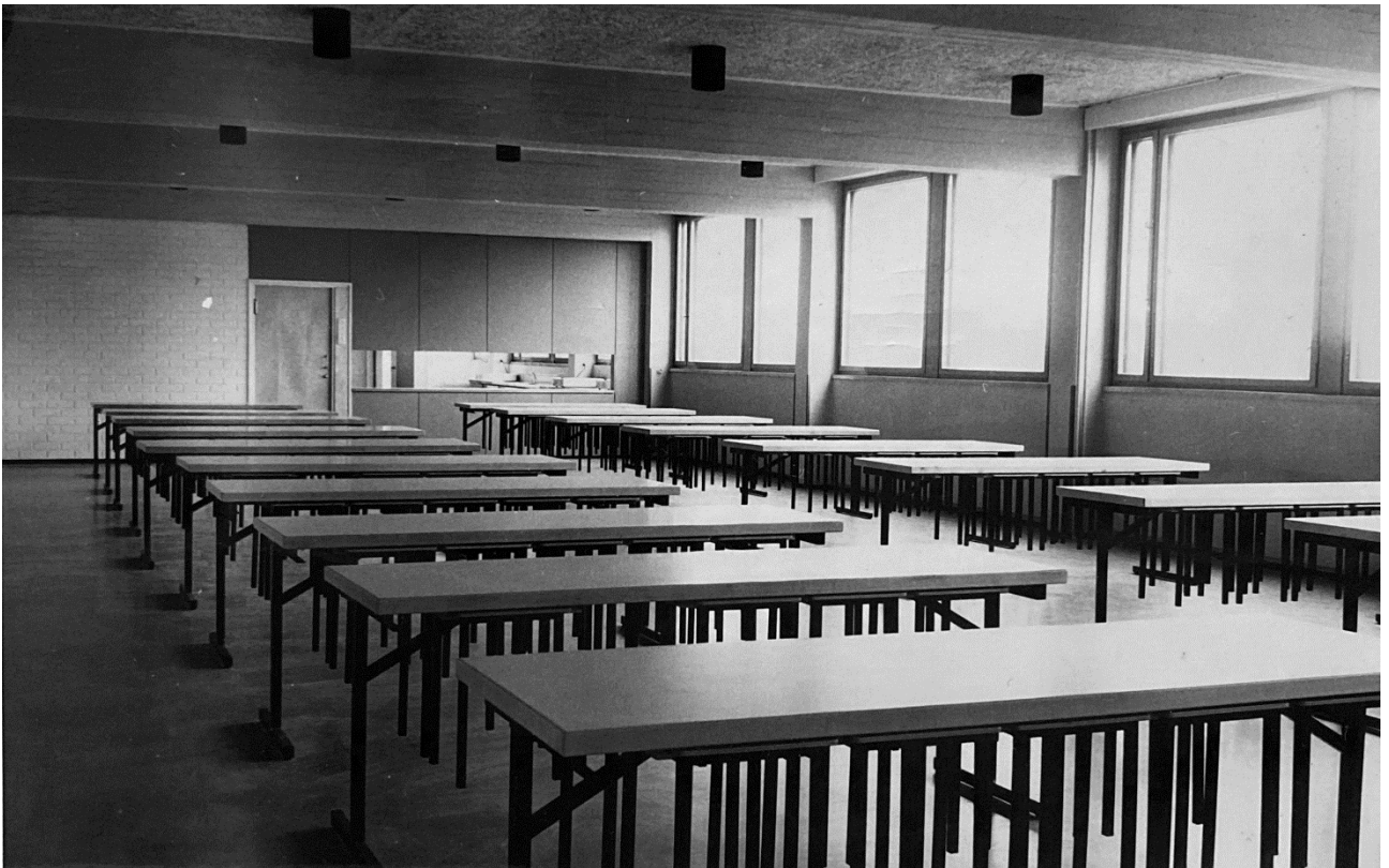
Ylemmässä kuvassa koulun näkymä aulasta aamiaissaliin. Pilareissa on pyöristetyt puukulmalistat, valaisimet katossa muodostavat valonauhoja, matalissa kaiteissa on puiset käsijohteet. Alemmassa kuvassa aamiaissali. Alkuperäiset downlight- valaisimet ja Tojax-levyt ovat aamiaissalin katossa. Kuvat: valokuvaaja ja ajankohta tuntematon, Fotoni.
