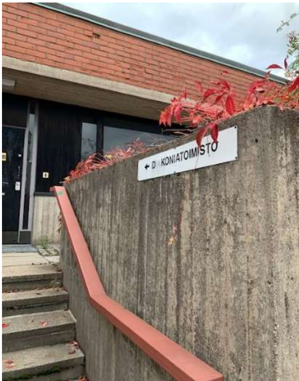
Kuva 89: Betonimuri ja maalattu teräskäsijohde
