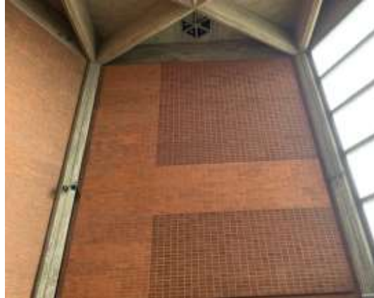
Kuva 98: Akustinen tiiliverhous
