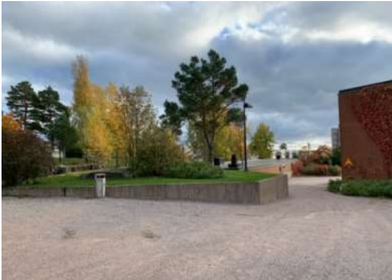
Kuva 64: Viherkattoinen jäteasema / ulkovarasto parkkipaikalta kuvattuna
