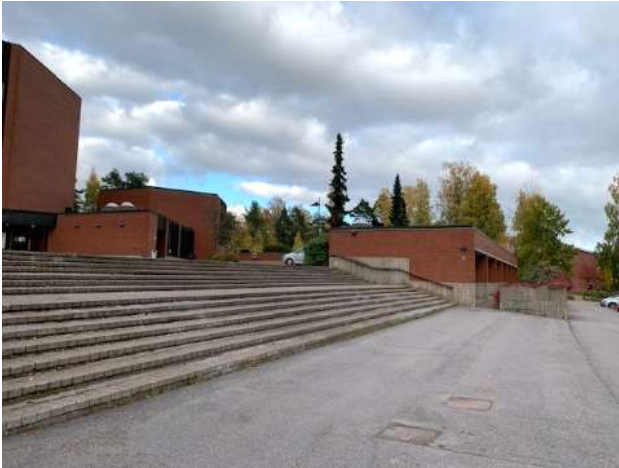
Kuva 59: Leveät portaat kirkolle ovat linjassa seurakuntasiiven kanssa
