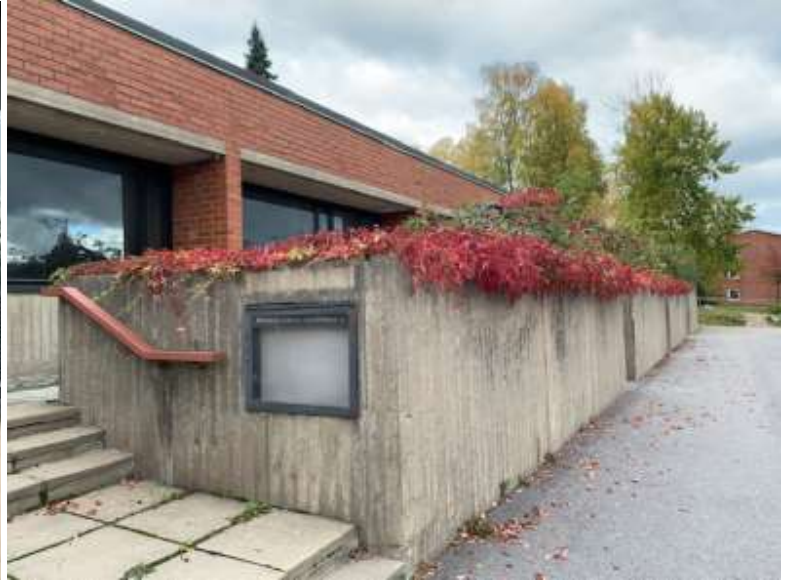
Kuva 88: Laatoitus ja portaat sisäänkäynnille, kyltissä lukee "Roihuvuoren seurakunta"
