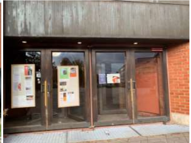
Kuva 84: Pääsisäänkäynti, otsapellit patinoitunutta kuparia
