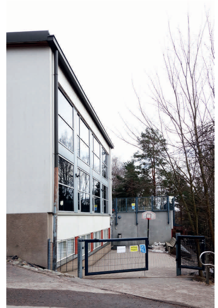
▲ Liikuntasalilaajennus on elementtirakenteinen. Taustalla näkyy pihakansi. JKMM 2022.
