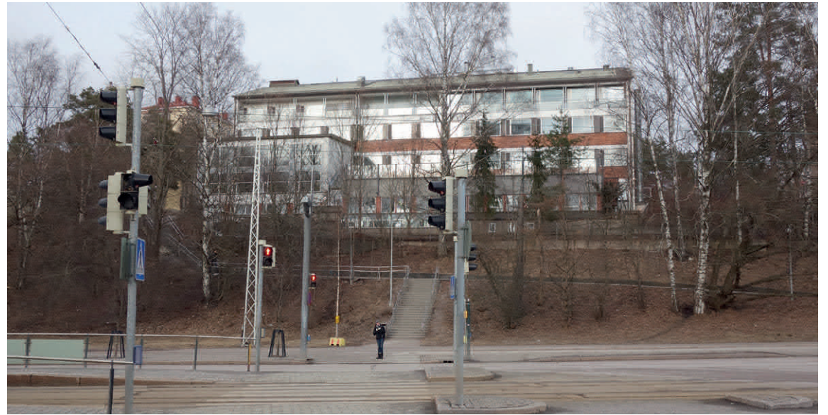
▲ Englantilainen koulu Paciuksenkadulta katsottuna. Koulu sijaitsee jyrkässä rinteessä, koulun editse kulkee kevyen liikenteen reitti ja portaat. Vuoden 1998 laajennus ja pihakansi ovat rinteeseen puolella ja näkyvät etummaisena rakennusmassana. Kesäisin rakennus on kasvillisuuden peitossa. JKMM 2022.
