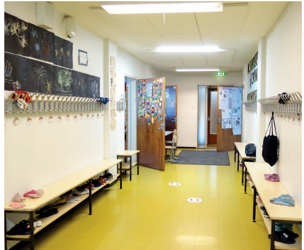
▲ 2. kerroksen käytävä eteläpäädyn suuntaan. Tummat, viilupintaiset ovet ovat todennäköisesti alkuperäisiä. Käytävän päässä näkyy puulasiseinä, joka johtaa päädyn porrashuoneeseen. Lattian Finflex kvartsivinyliasbestilattia on 1970 -luvulta. JKMM 2022.
