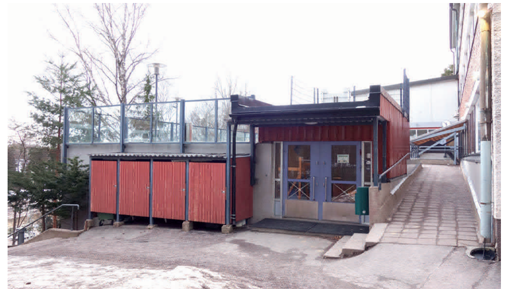
▲ Pihakansi, jätekatos ja pihakannen sisäänkäynti etelästä kuvattuna. Sisäänkäynnin julkisivut ovat profiilipeltipintaiset. JKMM 2022.
