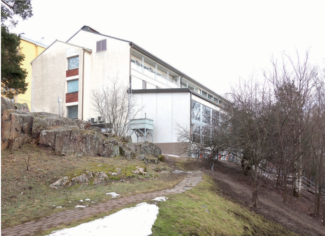
▲ Englantilaisen koulun pohjoispääty mäen päältä kuvattuna. Etualalla näkyy liikuntasalilaajennus. Oikealla kevyen liikenteen portaat. Ylimmässä kerroksessa on parvekerivistö. JKMM 2022.
