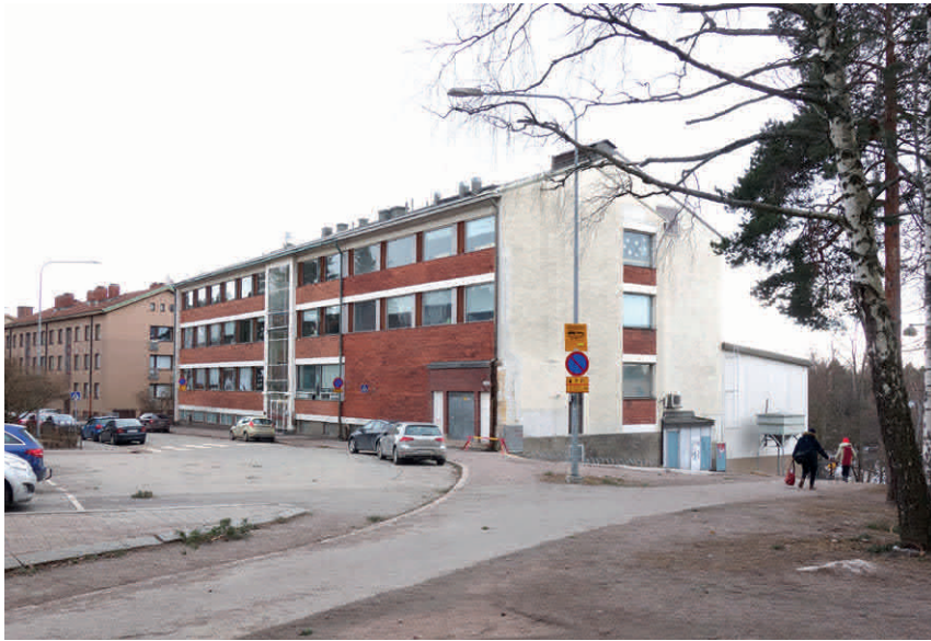
▲ Englantilainen koulu, etualalla näkyy vuoden 1975 Mäntytien suuntainen laajennus. Rakennuksen nurkalla on muuntamo, joka on muuta laajennusta vanhempi, se on laajennuksen yhteydessä liitetty osaksi koulurakennusta. Oikeassa laidassa näkyy matalampi liikuntasalin laajennus vuodelta 1998. JKMM 2022.
