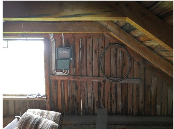
Toisen kerroksen päädyn ulkoseinärunko on rankarakenteinen.
