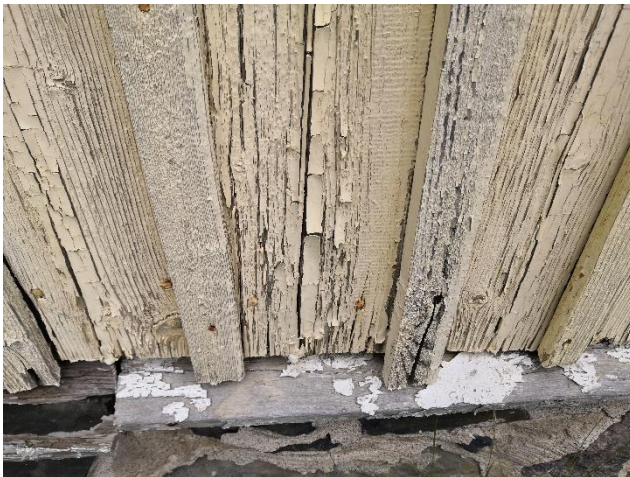
Julkisivun laudoituksia on osittain vaihdettu.
