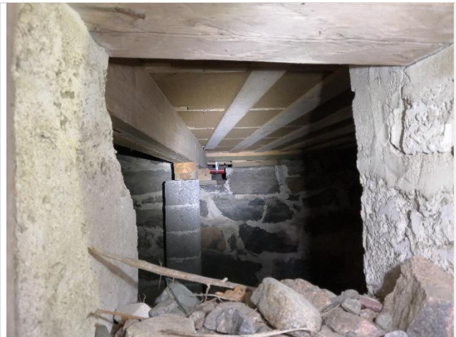
Harkkomuurattuja perustuksia alapohjatilassa.
