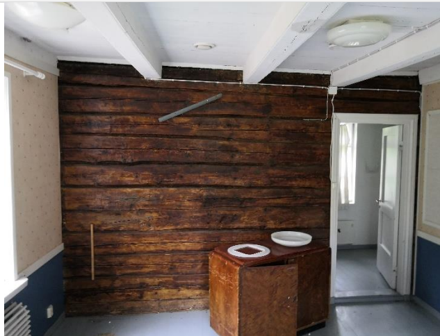
Väliseinien hirsirunkoa ja välipohjan puukannattajia ensimmäisessä kerroksessa.
