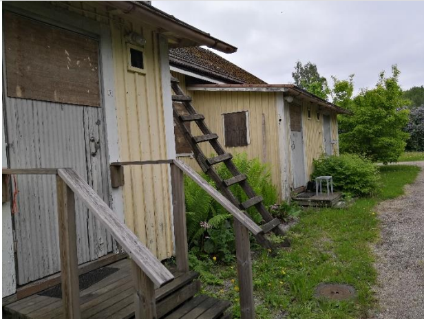
Yleiskuva rakennuksen vierustoilta sisäänkäyntien puolelta.
