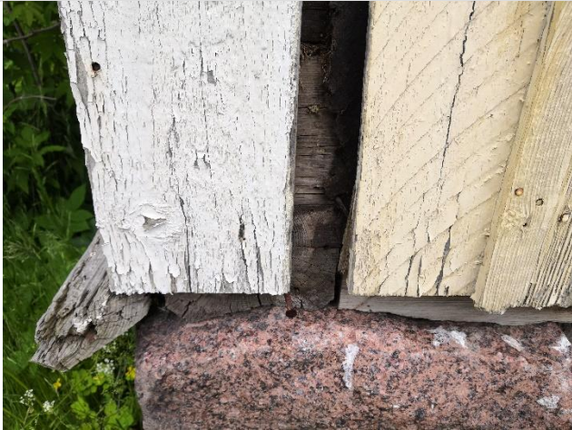
Hirsirungon nurkkaliitos näkyvissä kivijalan päällä nurkkalaudan ja julkisivuverhouksen liittymässä.
