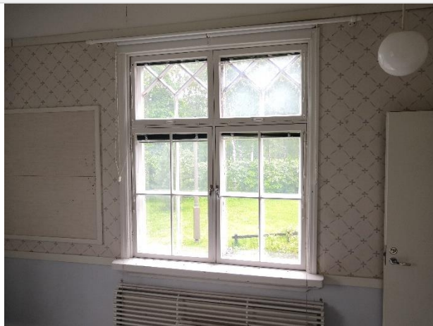
MSU-ikkunoita sisäpuolelta kuvattuna.
