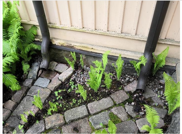
Kattovesien poisohjaus loiskekupein rakennuksen vieressä.
