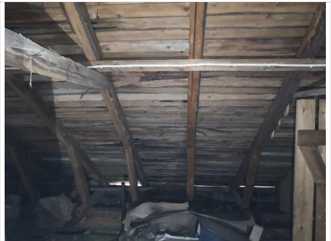
Kattoristikkorakenteita ja aluskatteen aluslaudoitusta.
