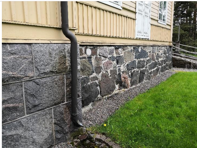
Alkuperäisen osan ja tornilaajennuksen kivijalkaa.
