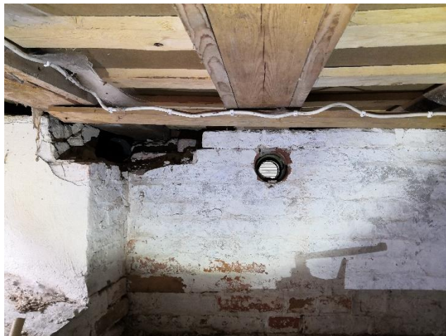
Tiilimuurattuja perustusrakenteita pääsisäänkäynnin viereisellä kellaritasolla.
