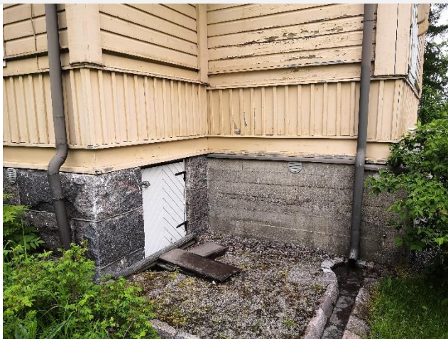
Kivijalka on osittain paikallavalettua teräsbetonia.
