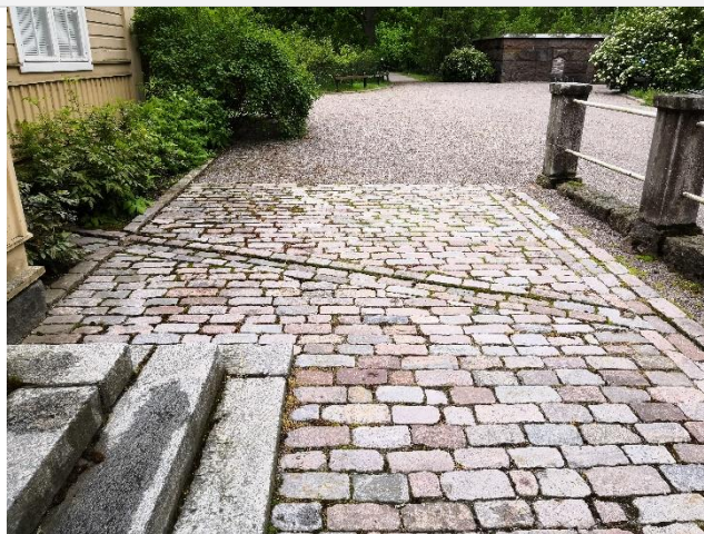
Pääsisäänkäynnin edustalla luonnonkivilaatoitus.
