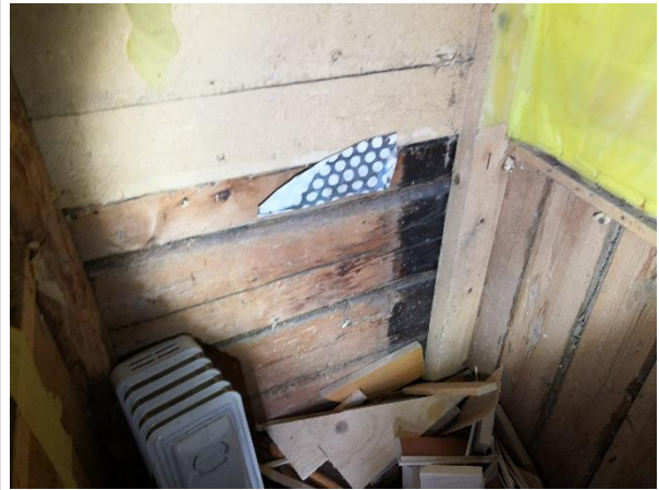
Hirsirungon sisäpintaa asunnon eteisessä.
