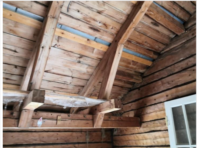
Hirsirunkoa ja kattoristikoida ullakkotilassa.
