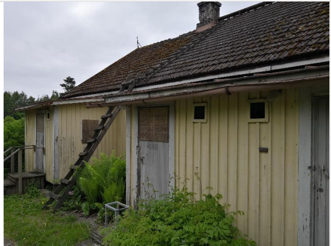
Yleiskuva julkisivupinnoista, kuvattuna etelästä.
