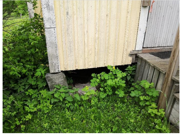
Rakennuksen vierusta ja kuistin kivijalka.
