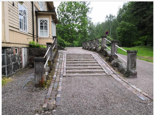
Pääsisäänkäynnin luonnonkivisiä rakenteita.
