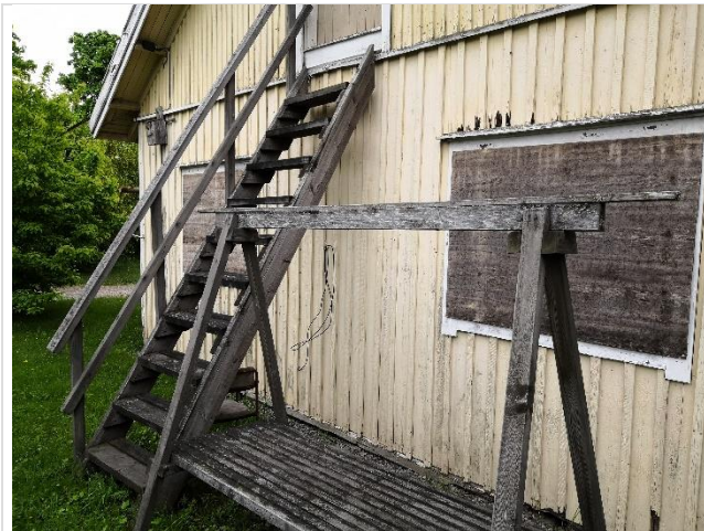
Puiset portaat toiseen kerrokseen.
