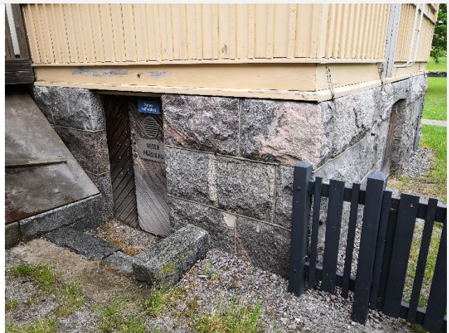
Tornilaajennuksen harkkomaisista lohkotuista luonnonkivistä tehty kivijalka.
