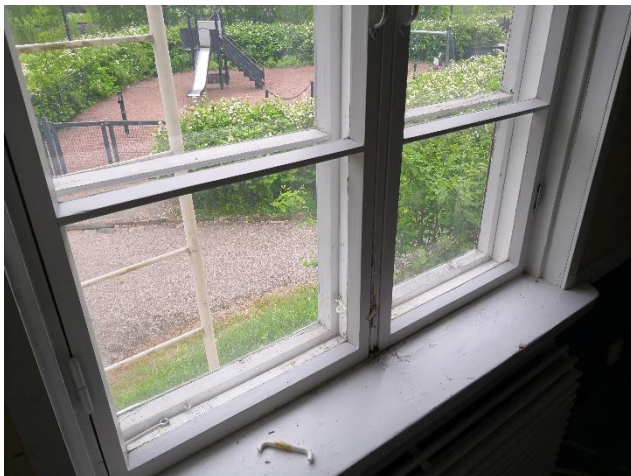
MSU-ikkuna sisäpuolelta.
