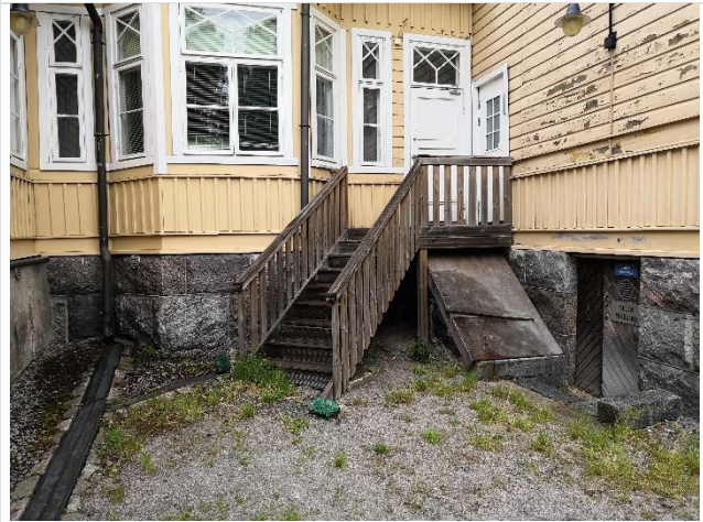
Kaakkoissivun sisäänkäynnin puuportaikko.
