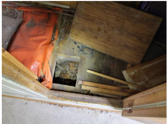
Alapohjarakenteen vanha avauskohta huoneiston eteisessä.
