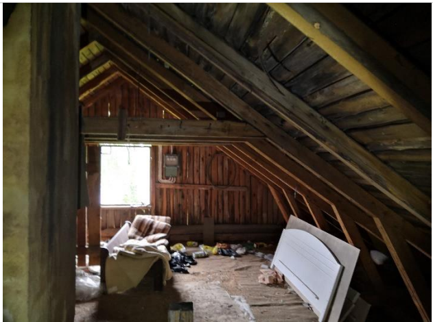
Vesikaton kantavat ristikot ullakkotilassa.
