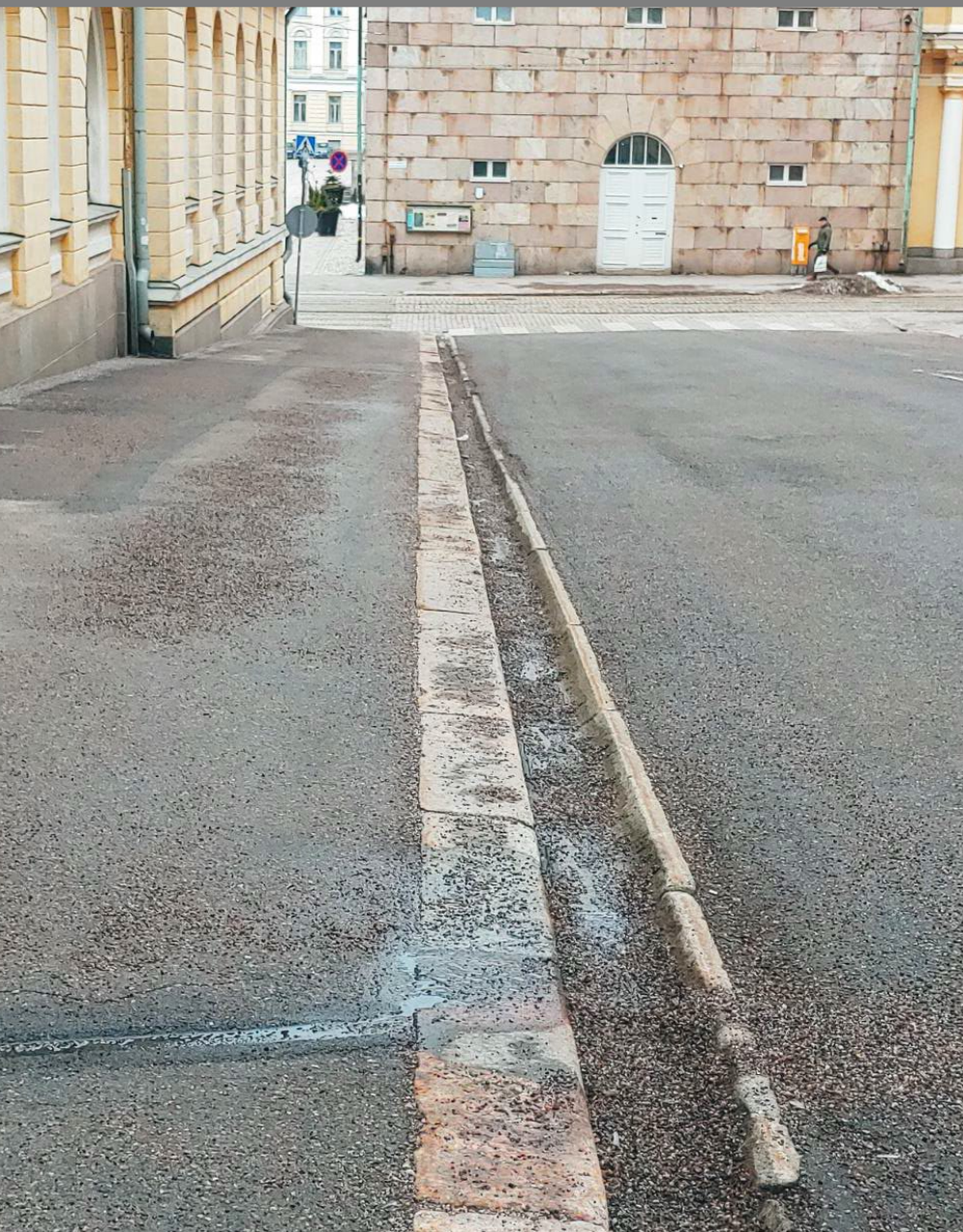
Hallituskadun kadun ja jalkakäytävien graniittikivi- ja asfalttipinnoitteet
