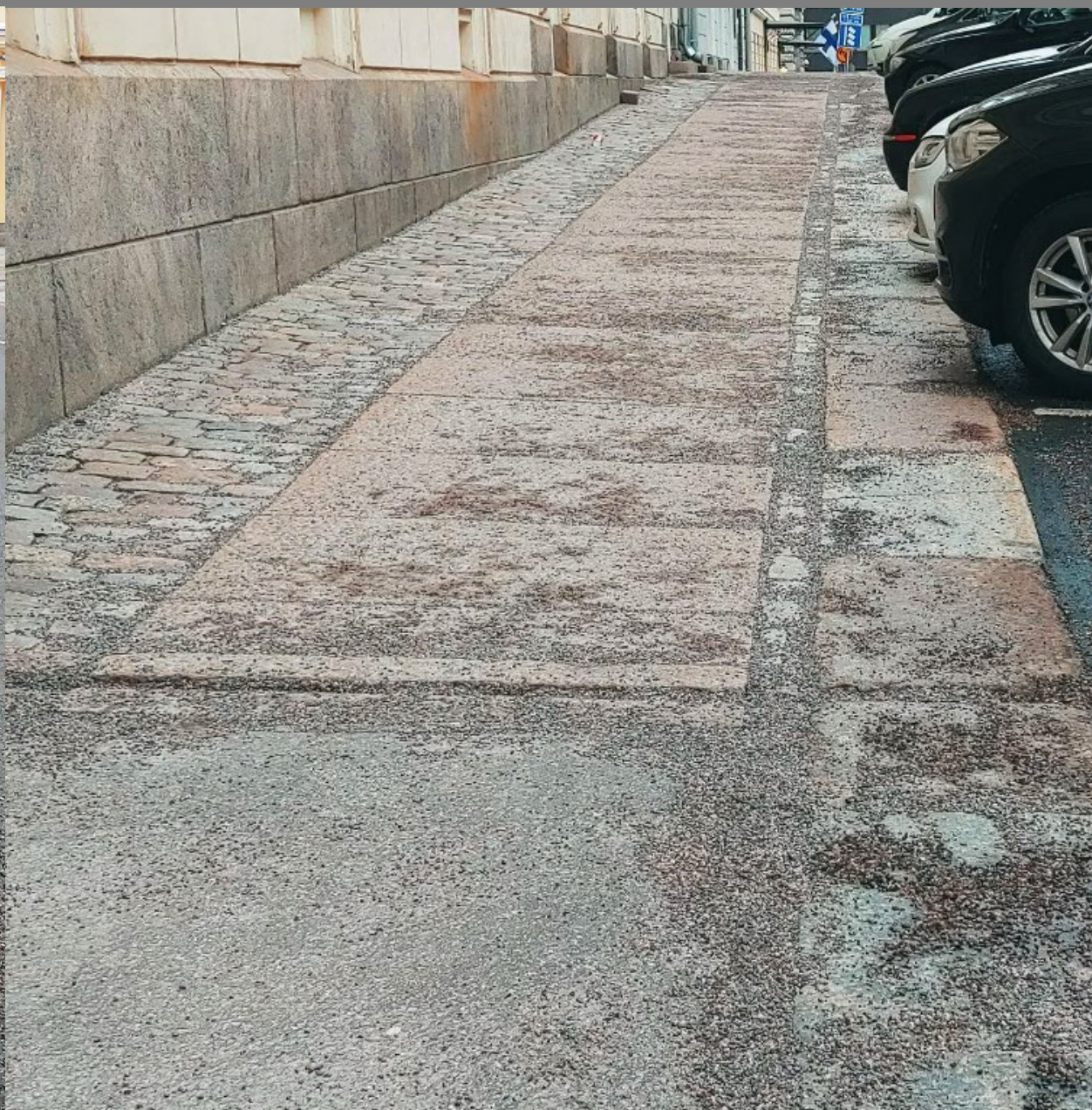
Hallituskadun kadun ja jalkakäytävien graniittikivi- ja asfalttipinnoitteet
