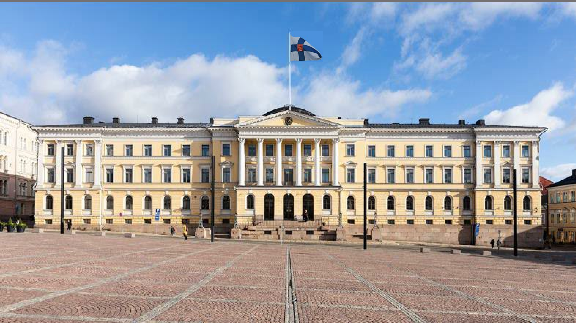
Valtioneuvoston linna julkisivu Senaatintorin aukiolle
