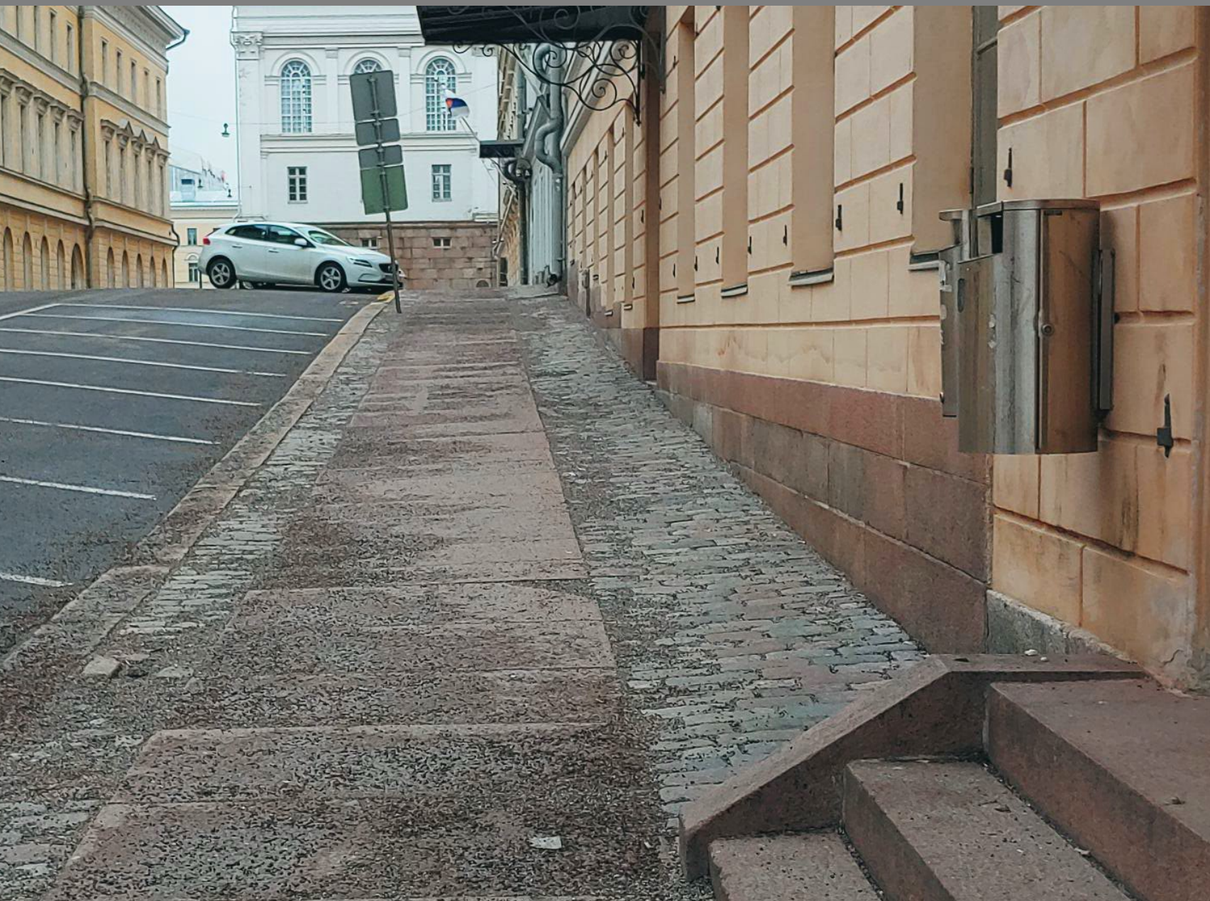
Hallituskadun kadun ja jalkakäytävien graniittikivi- ja asfalttipinnoitteet
