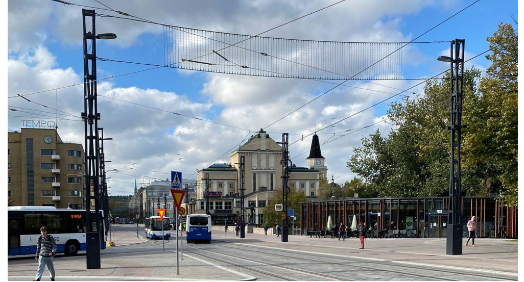
Esimerkki kohteeseen suunnitellusta yhteiskäyttöpylvästä: Tampereen Hämeenkadun yhteiskäyttöpylväät, joissa kierteinen ristikkorakenne, kuva WSP.
