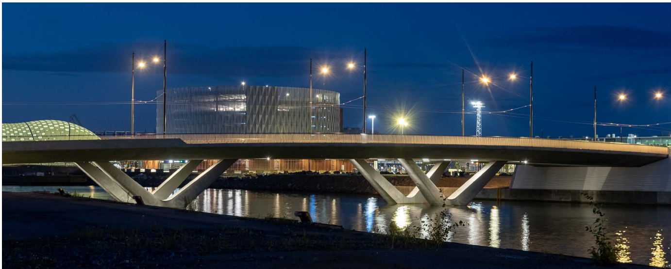
Kuva 4: esimerkki siltamuotoilusta erikoiskaiteella ja kaidevalaistuksella, Atlantinsilta, kuva WSP
