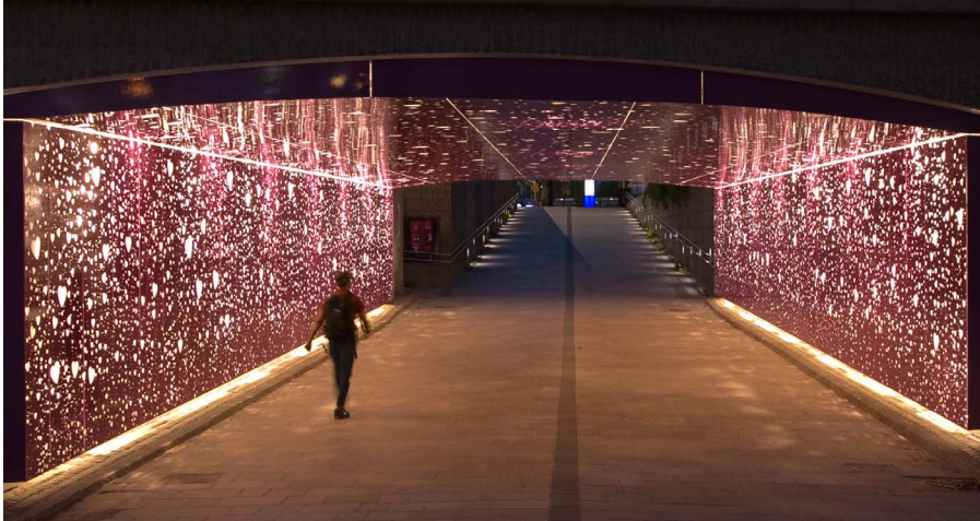
Kuva 1: Esimerkki alikulkuun sijoittuvasta taiteesta ja erikoisvalaistuksesta, taiteilija Akseli Leinonen, valaistus WSP, kuva WSP.
