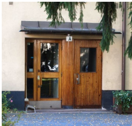
Myöhempää kerrostumaa edustava lippakatos on raskaampi ja tavanomaisempi.
