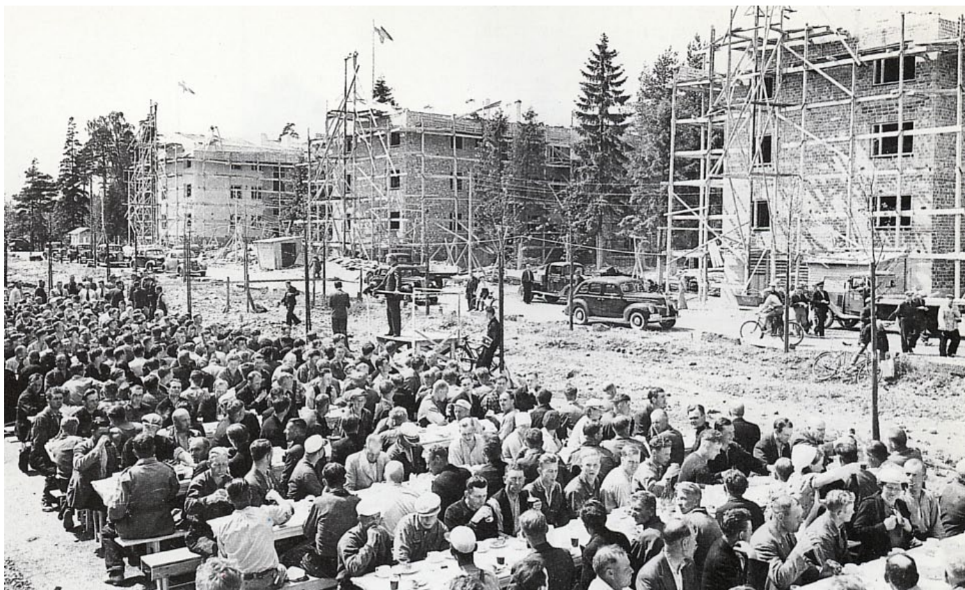
Olympiakylä rakennusvaiheessa. Rakennusliike Haka
