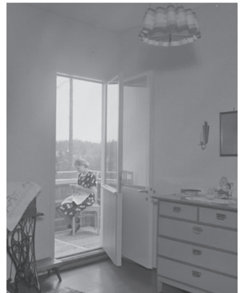
Nainen istuu parvekkeella neulomassa. Parvekkeen ovena on maalattu puupaneelilasiovi. Kuva vuodelta 1940, OTK, Työväenmuseo Werstas
